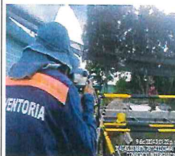
FOTOGRAFÍA No. 34: La comisión de topografía corrige los niveles de las cerchas del sedimentador N° 3
