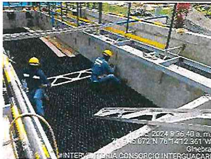
FOTOGRAFÍA No. 19: Reubican la platinas donde se instalarán las cerchas que soportaran las canaletas de reparto
