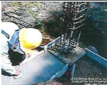
FOTOGRAFÍA No. 47: Funde el solado de limpieza para iniciar a el armado de los castillos de las vigas de cimentación en la caseta eléctrica.
