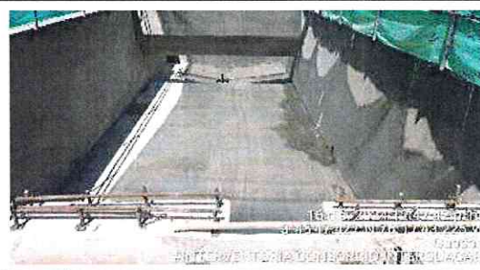
FOTOGRAFÍA No. 44: Las intervenciones de obra civil ya finalizaron. El contratista toma medidas para la construcción de los elementos del barrelos del sedimentador N° 2. En espera que llegue el personal del montaje metalmecánico
