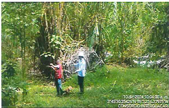
FOTOGRAFÍA No. 65: La comisión de topografía realiza levantamiento en la zona de la bocatoma
