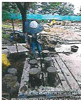
FOTOGRAFÍA No.5: Se realiza la toma de muestras del concreto de los muros de la caja de entrada a el tanque de almacenamiento
