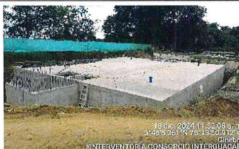
FOTOGRAFÍA No. 12: Terminan de retirar la formaleta del tanque de almacenamiento. En espera que se realice la prueba de estanqueidad para poder iniciar el relleno del perímetro del tanque y la impermeabilización de los muros y la losa de fondo
