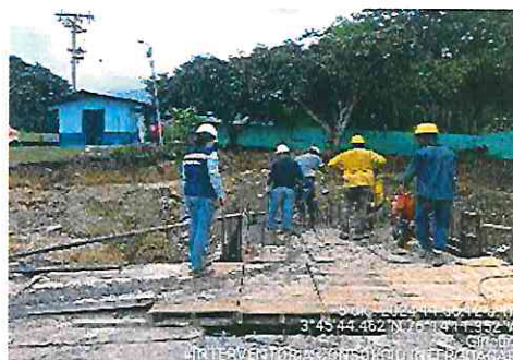
FOTOGRAFÍA No.4: Realizan la fundición de los muros de la caja de entrada a el tanque de almacenamiento
