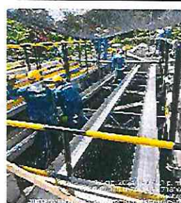
FOTOGRAFÍA No. 21: Realizan el montaje de las canaletas de reparto el sedimentador N° 2
