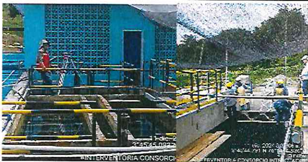
FOTOGRAFÍA No. 17: La comisión de topografía realiza el chequeo de los niveles para la instalación de las cerchas que soportaran las canaletas de reparto en acero inoxidable en el sedimentador N° 2
