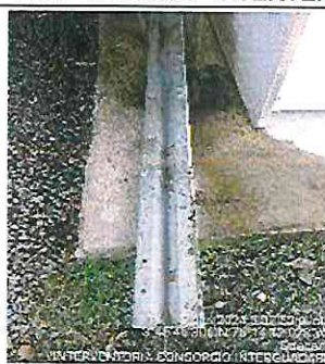
FOTOGRAFÍA No. 33: En el sedimentador N° 3, se presentó un daño, debido a que entre la pantalla inclinada y la pantalla perforada tienen una escalera la cual en el momento de poner en operación el barrelados la escalera entro en contacto con una de las traviesas frenando el sistema y finalmente ocasiona que la traviesa se doble y reviente la cadena del motor.
