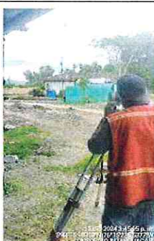
FOTOGRAFÍA No. 57: La comisión de topografía en conjunto con la interventoría, realiza chequeos a el nivel de la excavación del tanque de almacenamiento
