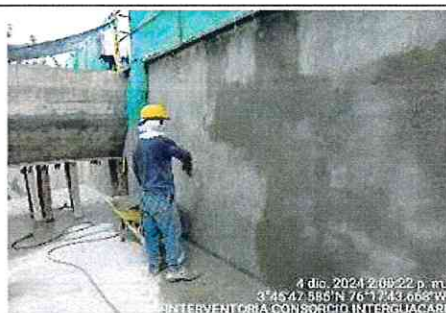
FOTOGRAFÍA No. 41: Terminan el repello de los muros del sedimentador N° 2.
