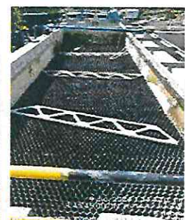
FOTOGRAFÍA No. 34: La comisión de topografía corrige los niveles de las cerchas del sedimentador N° 3
