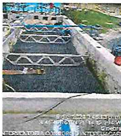
FOTOGRAFÍA No. 35: Se instalan de nuevo las cerchas con los niveles corregidos
