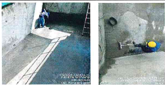
FOTOGRAFÍA No. 43: Aplican el impermeabilizante en los muros y en la losa en el sedimentador N° 2.
