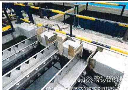
FOTOGRAFÍA No. 27: Se realiza la fundición del grouting en el vano del muro en concreto en la entrega de las canales en el sedimentador N° 2.
