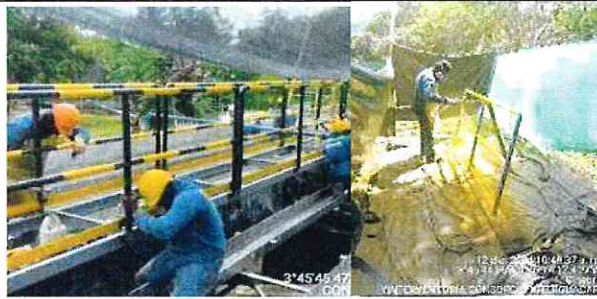
FOTOGRAFÍA No. 24: Realizan la actividad pintura de los pasamanos de las pasarelas
