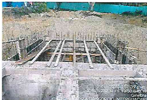
FOTOGRAFÍA No.1: Terminan la instalación de la formaleta de los muros de la caja de entrada, del tanque de almacenamiento
