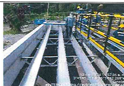
FOTOGRAFÍA No. 38: Realizan la instalación de las canaletas de reparto en el sedimentador N° 3.
