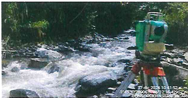
FOTOGRAFÍA No. 67: La comisión de topografía en conjunto con la interventoria, realiza batimetría en la zona donde se va construir la bocatoma y el desarenador
