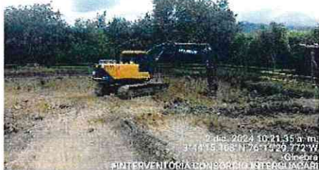
FOTOGRAFÍA No. 55: La retroexcavadora de oruga realiza la excavación para llegar a la rasante, el cual es de 0.40 mt aproximadamente
