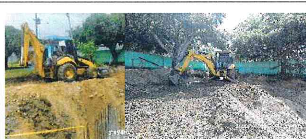
FOTOGRAFÍA No.10: La retroexcavadora realiza la extensión y relleno en el frente a la caja de entrada del tanque
