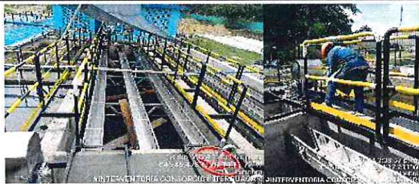
FOTOGRAFÍA No. 13: Realizan la instalación de la estructura en IPE de 4" de las pasarelas y los pasamanos de las pasarelas entre los sedimentadores N° 1 y N° 2 y N° 2 y N°3.
