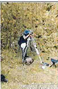
FOTOGRAFÍA No. 59: La comisión de topografía en conjunto con la interventoría, realizan chequeo a la rasante del tanque de almacenamiento.
