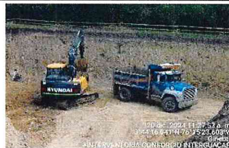
FOTOGRAFÍA No. 56: Retiro en volqueta del material proveniente de la excavación del tanque de almacenamiento.
