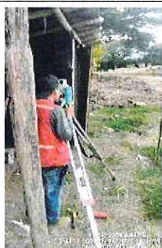
FOTOGRAFÍA No. 57: La comisión de topografía en conjunto con la interventoría, realiza chequeos a el nivel de la excavación del tanque de almacenamiento
