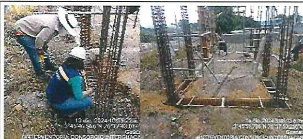
FOTOGRAFÍA No. 48: Realizan la revisión de los aceros de las vigas de cimentación y las columnas de la caseta eléctrica.
