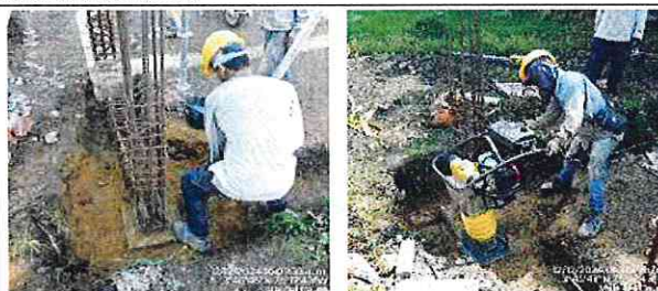
FOTOGRAFÍA No. 46: Realiza el relleno con material de sitio en la zona donde se construyeron las dos zapatas.
