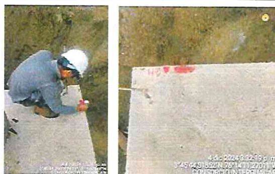
FOTOGRAFÍA No.2: La comisión de topografía deja niveles en el muro, para dar inicio a el relleno del perímetro del tanque de almacenamiento
