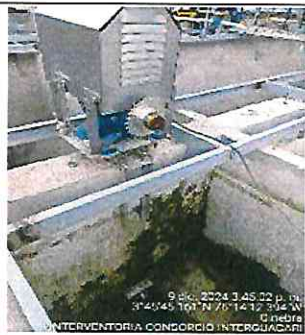
FOTOGRAFÍA No. 33: En el sedimentador N° 3, se presentó un daño, debido a que entre la pantalla inclinada y la pantalla perforada tienen una escalera la cual en el momento de poner en operación el barrelados la escalera entro en contacto con una de las traviesas frenando el sistema y finalmente ocasiona que la traviesa se doble y reviente la cadena del motor.
