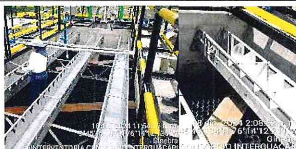
FOTOGRAFÍA No. 28: Aplican sello en los pernos de anclaje de las platinas donde se soldaron las canales de reparto en el sedimentador N° 2. El contratista realiza chequeo de los niveles del vertedero en la canal de reparto en el sedimentador N° 2.
