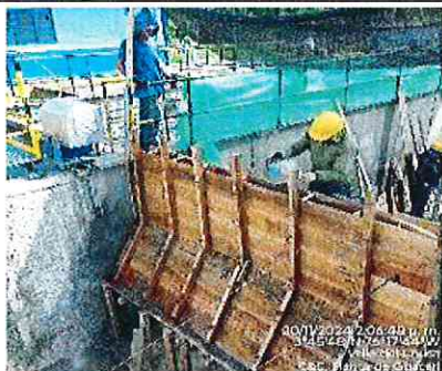
FOTOGRAFÍA No. 39: Encofran y funden la pantalla inicial inclinada en el sedimentador N° 2
