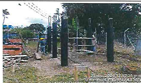
FOTOGRAFÍA No. 54: Fundición de las columnas de la caseta eléctrica. Se recubren con polisombra para el fraguado
