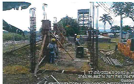
FOTOGRAFÍA No. 52: Armado de las formaletas de las columnas de la caseta eléctrica.
