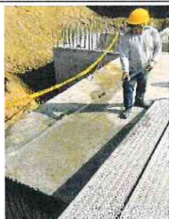
FOTOGRAFÍA No.11: Terminan de retirar la formaleta del tanque de almacenamiento y realiza limpieza en la losa
