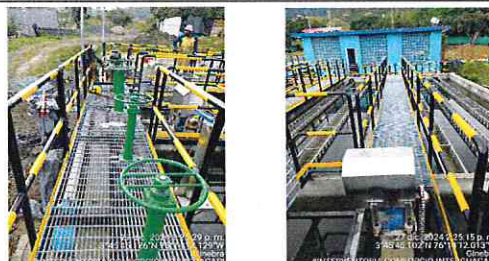
FOTOGRAFÍA No. 30: Se realiza la instalación de las rejilla de la pasarela
