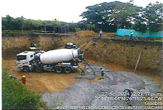
FOTOGRAFÍA No. 63: Realizan el vaciado del solado de limpieza, del tanque de almacenamiento
