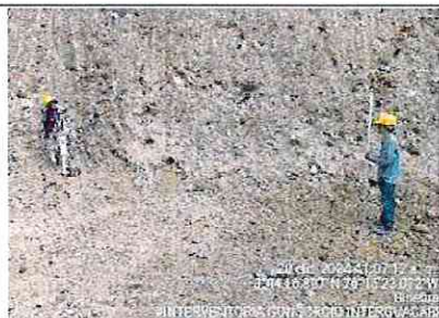
FOTOGRAFÍA No. 59: La comisión de topografía en conjunto con la interventoría, realizan chequeo a la rasante del tanque de almacenamiento.
