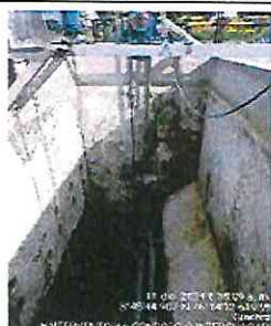
FOTOGRAFÍA No. 37: Se instala de nuevo la cadena del motor y la traviesa del barrelados
