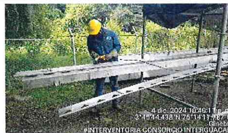
FOTOGRAFÍA No. 14: Realizan el corte y la apertura de los orificios para la instalación de los pernos que harán que la canaleta sea escualizable, debido a que están muy altas y tendrían problemas con la operación de los sedimentadores.
