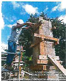
FOTOGRAFÍA No. 51: El contratista y la interventoria, realiza chequeo de los niveles y plomos de las columnas de la caseta eléctrica.
