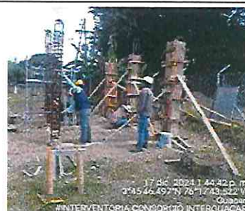
FOTOGRAFÍA No. 50: La interventoria realiza la verificación de las longitudes de los aceros de las columnas de la caseta eléctrica.
