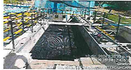
FOTOGRAFÍA No. 16: Realizan la instalación de los módulos tipo colmena en el sedimentador N° 2.
