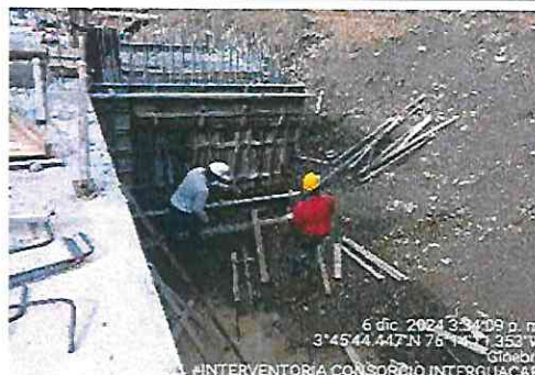
FOTOGRAFÍA No.6: Realizan la actividad retiro de la formaleta de los muros de la caja de entrada del tanque de almacenamiento
