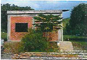
FOTOGRAFÍA No. 31: Las actividades en la caseta finalizaron. Esta pendiente el detallado de la caseta, el repello para dar pendiente a la viga canal, la impermeabilización, limpieza de las puertas y las ventanas.
