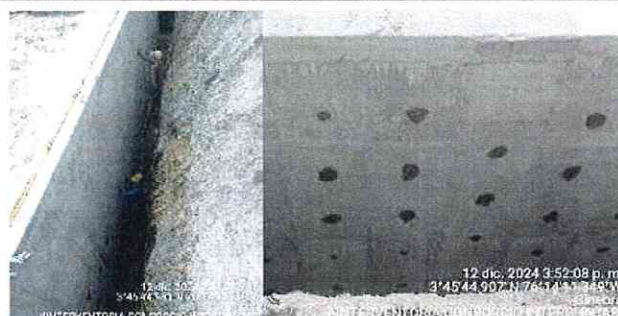
FOTOGRAFÍA No. 8: Resane de los oficios de los tornillos que ajustaban la formaleta
