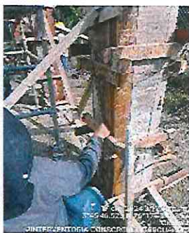
FOTOGRAFÍA No. 51: El contratista y la interventoria, realiza chequeo de los niveles y plomos de las columnas de la caseta eléctrica.
