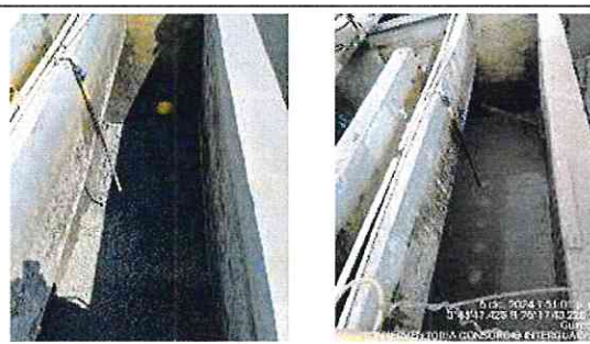
FOTOGRAFÍA No. 42: Realizan la fundición de la losa del sedimentador en el módulo de entrada en la pantalla perforada, con esto se evita que el lodo se quede acumulado en este espacio en el sedimentador N° 2.
