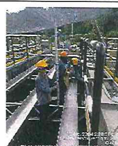
FOTOGRAFÍA No. 22: La comisión de topografía realiza el chequeo de los niveles para la instalación de las canaletas de reparto el sedimentador N° 2
