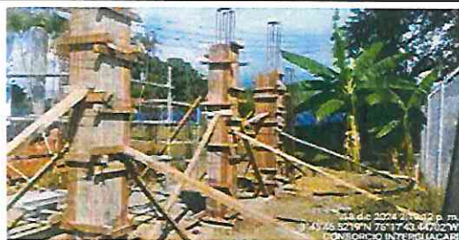
FOTOGRAFÍA No. 53: Se realiza el encofrado de las columnas
