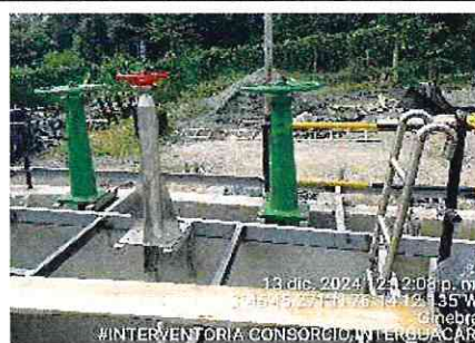
FOTOGRAFÍA No. 26: Realiza la instalación de la válvula mariposa de diámetro 4" y las válvulas existentes que se les realiza mantenimiento del sedimentador N° 2.
