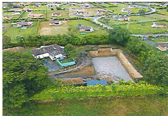
FOTOGRAFÍA No. 64: Vista aerea del vaciado del solado de limpieza, del tanque de almacenamiento
