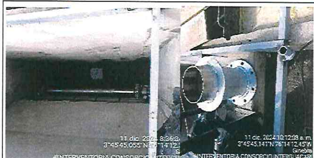
FOTOGRAFÍA No. 18: Instalación del pasamuros con su brida, a instalar en el tubo de 8", que trasportará el lodo hasta la caja ciega en el sedimentador N° 2
