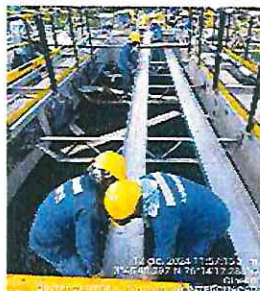
FOTOGRAFÍA No. 21: Realizan el montaje de las canaletas de reparto el sedimentador N° 2
