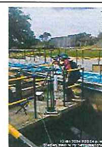
FOTOGRAFÍA No. 22: La comisión de topografía realiza el chequeo de los niveles para la instalación de las canaletas de reparto el sedimentador N° 2
