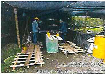
FOTOGRAFÍA No. 15: Realizan el armado los módulos tipo colmena para el sedimentador N° 2
