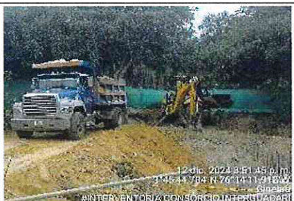
FOTOGRAFÍA No.9: Relleno del perímetro del tanque con material traído del tanque de almacenamiento de la Albania
