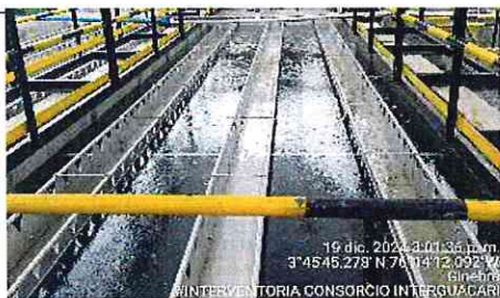
FOTOGRAFÍA No. 29: Con el apoyo del personal de Acuvalla, se hace el llenado del sedimentador N° 2. Se deja por un tiempo mientras se hace el llenado de las canales. Se observa que se debe sellar con grouting entre la ventana en concreto y la base de la canalita, para evitar el paso de agua y puedan funcionar los vertederos
