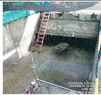
FOTOGRAFÍA No. 40: Encofran y funden la pantalla final inclinada en el sedimentador N° 2
