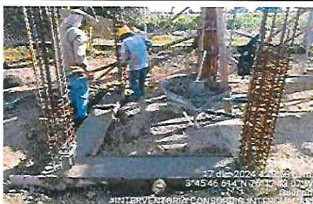
FOTOGRAFÍA No. 49: Realizan la fundición de las vigas de cimentación de la caseta eléctrica.
