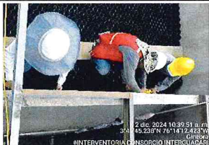
FOTOGRAFÍA No. 23: La comisión de topografía, realiza la localización de los puntos de anclaje, de los pernos de las platinas que soportan las canales de reparto del sedimentador N° 2
