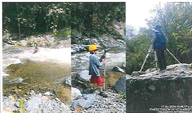
FOTOGRAFÍA No. 68: La comisión de topografía en conjunto con la interventoria, realiza batimetría en la zona donde se va construir la bocatoma y el desarenador
