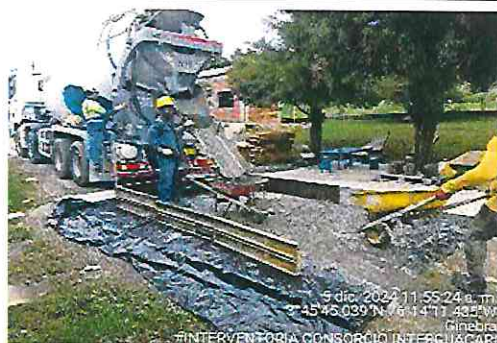
FOTOGRAFÍA No.3: Fundición de los muros de la caja de entrada a el tanque de almacenamiento
