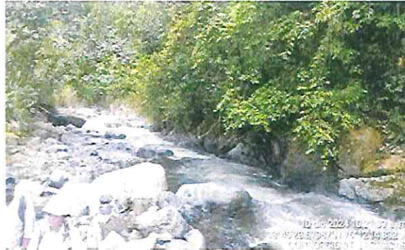
FOTOGRAFÍA No. 66: La comisión de topografía realiza levantamiento en la zona de la bocatoma
