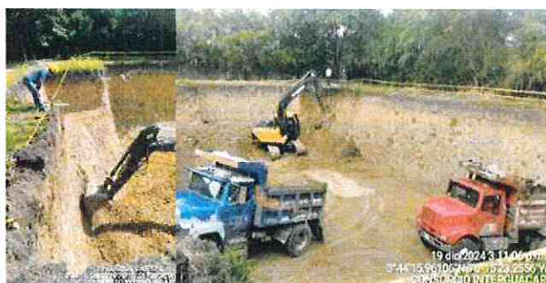
FOTOGRAFÍA No. 58: Excavación de los taludes tanque almacenamiento
