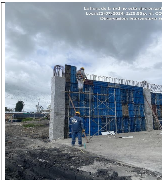
Se evidencia trabajo en alturas en obra
