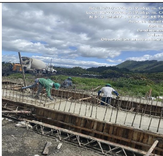
Se observa manejo de material y personal con epp en obra
