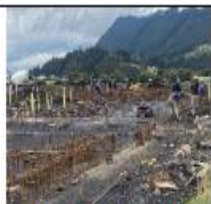
Inspección de obra
