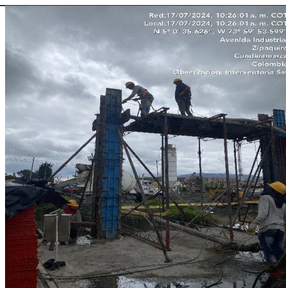
Se observa fundida y personal con epp en obra
