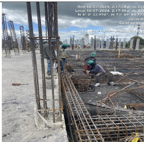
Se evidencia personal con epp en obra
