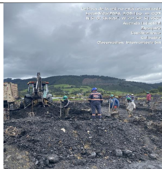
Se evidencia personal con epps en obra
