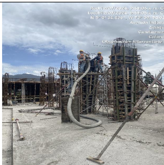
Se evidencia fundida y personal con epps en obra
