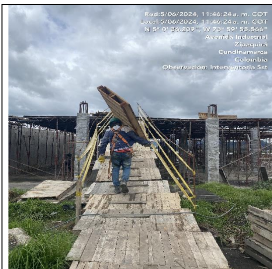
Se evidencia manejo de carga material en obra
