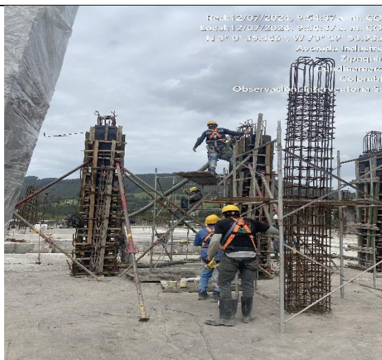
Se observa fundida en obra
