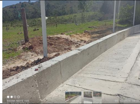
Imagen 12: Corte de dilatación de bordillo k0+150.
