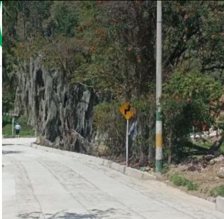
Imagen 17: Instalación de señales k0+0
