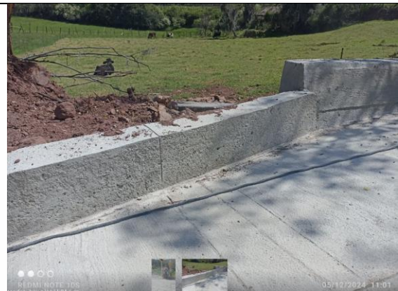
Imagen 8: Corte de dilatación de bordillo k0+040.
