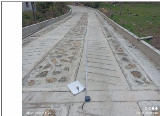
Imagen 23: Conformación de viga riostra a la altura de la abscisa k0+096
