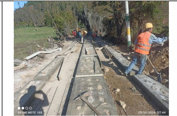
Imagen 02: Conformación de módulos laterales e internos de concreto ciclópeo a la altura de la abscisa k0+075
