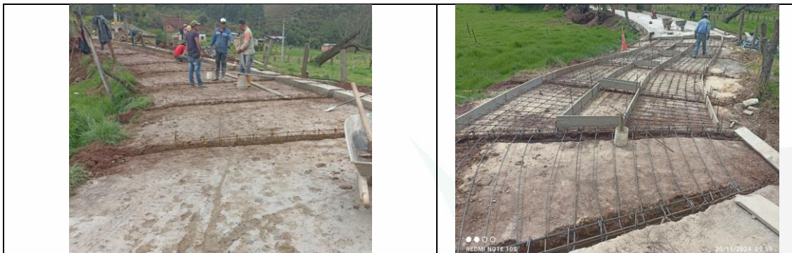
Imagen 46: Excavaciones para vigas riostras.
