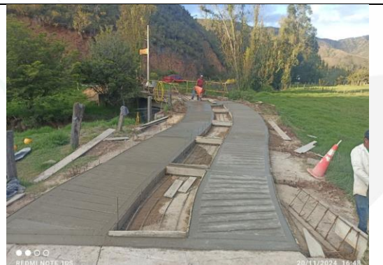
Imagen 24: Conformación de bordillo a la altura de la abscisa k0+015
