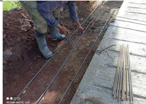
Imagen 12: Instalación de acero de módulos de Cuneta a la altura de la abscisa k0+045
