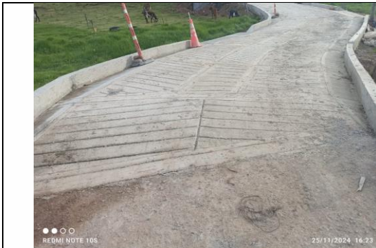
Imagen 23: Conformación de rampa de acceso k+007.
