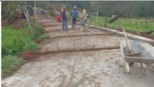
Imagen 15: Instalación de acero de viga riostra la altura de la abscisa k0+024
