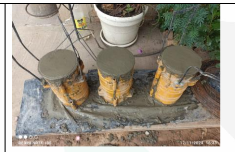
Imagen 48: Toma cilindros concretos de 3000PSI para Placa Huellas .
