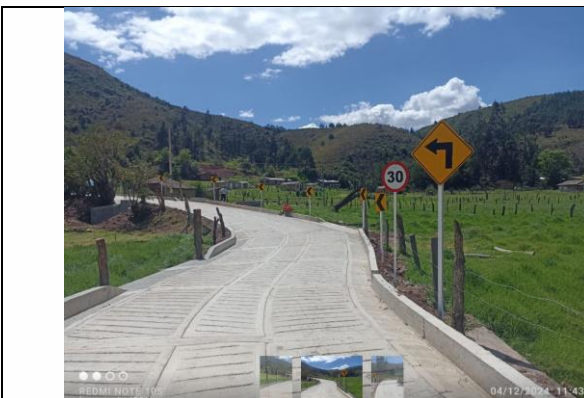
Imagen 15: Instalación de señales k0+020
