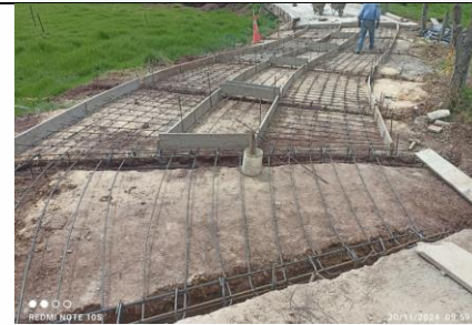
Imagen 16: Instalación de acero de viga riostra la altura de la abscisa k0+007
