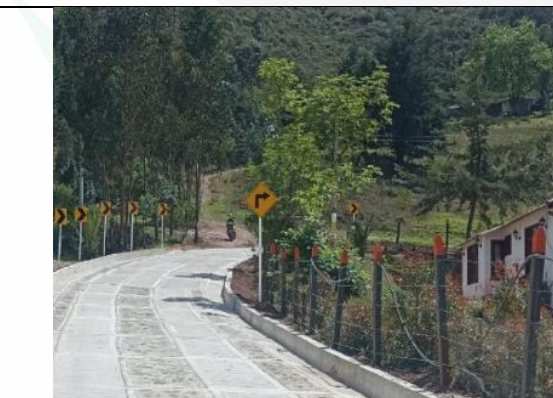
Imagen 16: Instalación de señales k0+130.
