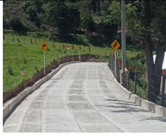
Imagen 18: Instalación de señales k0+190.
