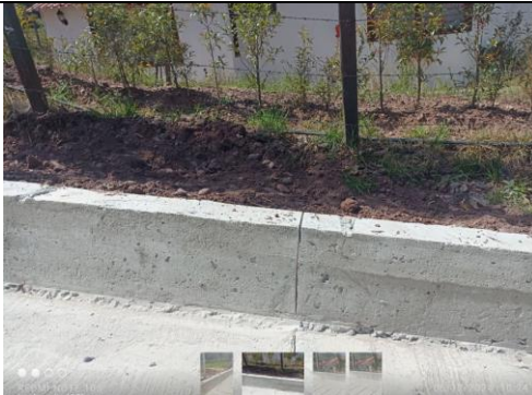
Imagen 13: Corte de dilatación de bordillo k0+165.
