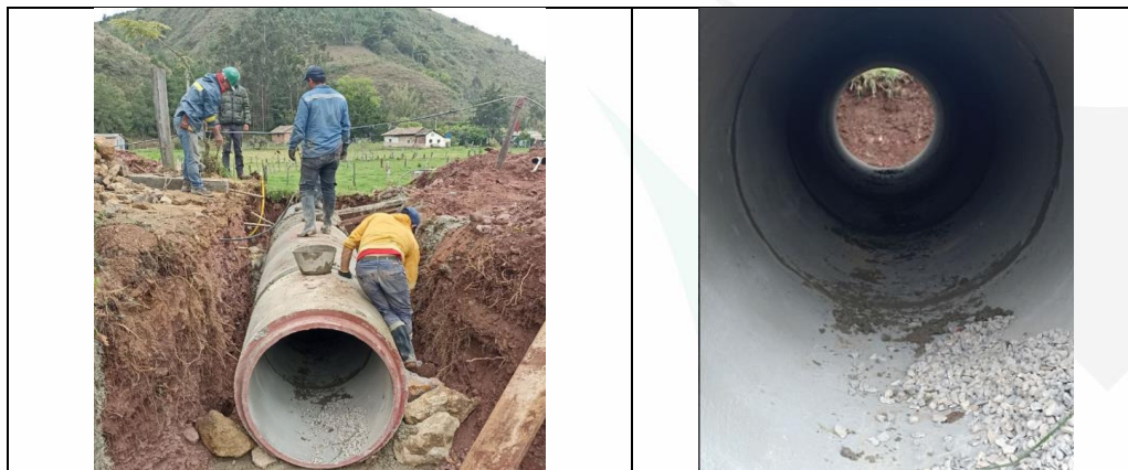
Imagen 39: Instalación y emboquillado de tubería en concreto.
