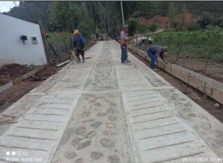
Imagen 13: Instalación de acero de para bordillo a la altura de la abscisa k0+096
