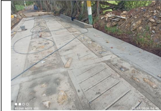
Imagen 03: Conformación de módulos laterales e internos de concreto ciclópeo a la altura de la abscisa k0+069.
