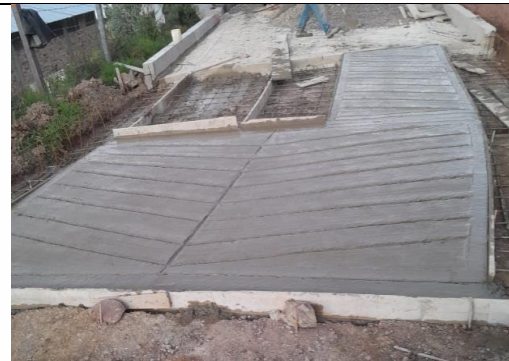
Imagen 24: Conformación de rampa de acceso k+219.
