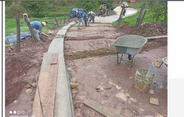
Imagen 04: Conformación de módulos lateral derecho de concreto ciclópeo a la altura de la abscisa k0+018.
