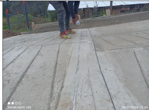
Imagen 45: Aplicación de epóxico para juntas
