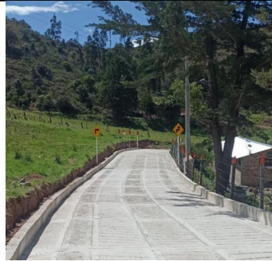
Imagen 22: Instalación de delineadores de curva entre k0+195/219.
