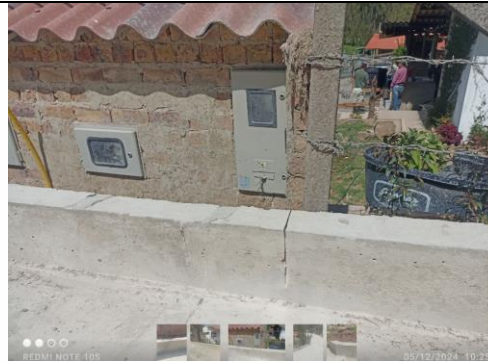
Imagen 14: Corte de dilatación de bordillo k0+185.
