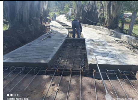
Imagen 10: Instalación de acero de módulos de Placa Huella a la altura de la abscisa k0+069
