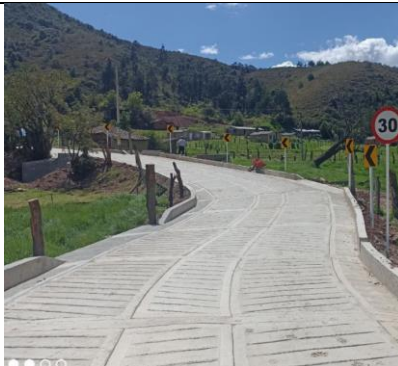
Imagen 19: Instalación de delineadores de curva entre k0+015/080.
