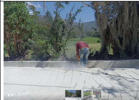
Imagen 9: Corte de dilatación de bordillo k0+070.
