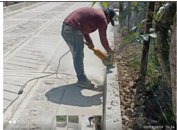
Imagen 10: Corte de dilatación de bordillo k0+090.
