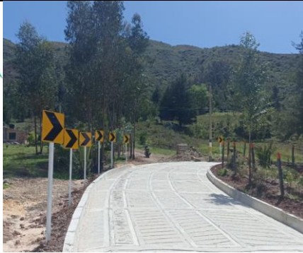
Imagen 21: Instalación de delineadores de curva entre k0+130/170.
