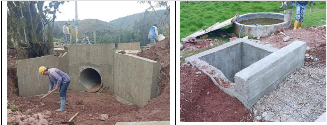
Imagen 38: Bases en ciclópeo para elevaciones
