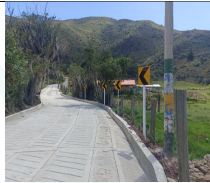
Imagen 20: Instalación de delineadores de curva entre k0+015/080.
