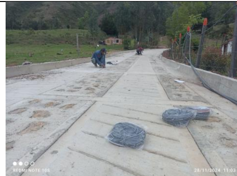
Imagen 43: Instalación cordón "JUMBOLOM"
