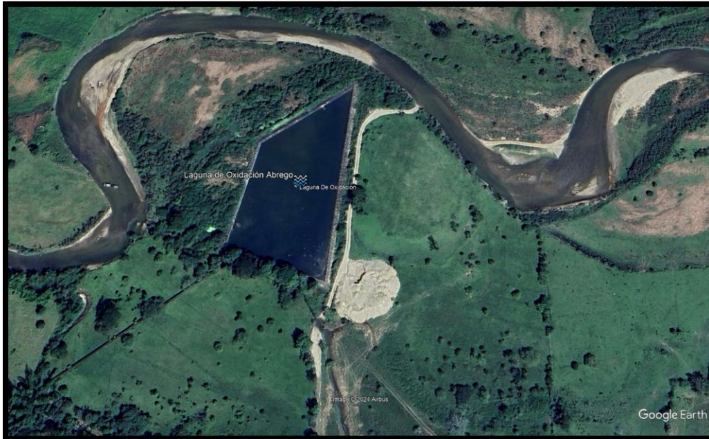
Figura 3. Localización laguna de oxidación de Abrego, vereda El Molino Fuente: Análisis del sector
