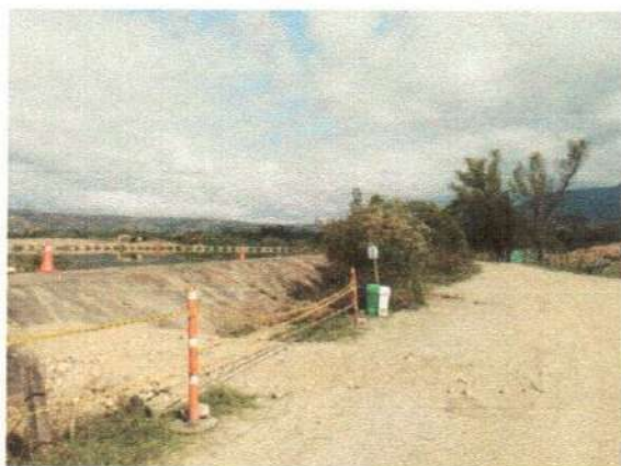
FOTO No. 11: Señalización
