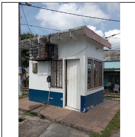
Ilustración 26: Vista General Caseta Paso a Nivel Miraflores PK 443+086/105, Barrancabermeja Fuente: Consorcio Gis Red Férrea
