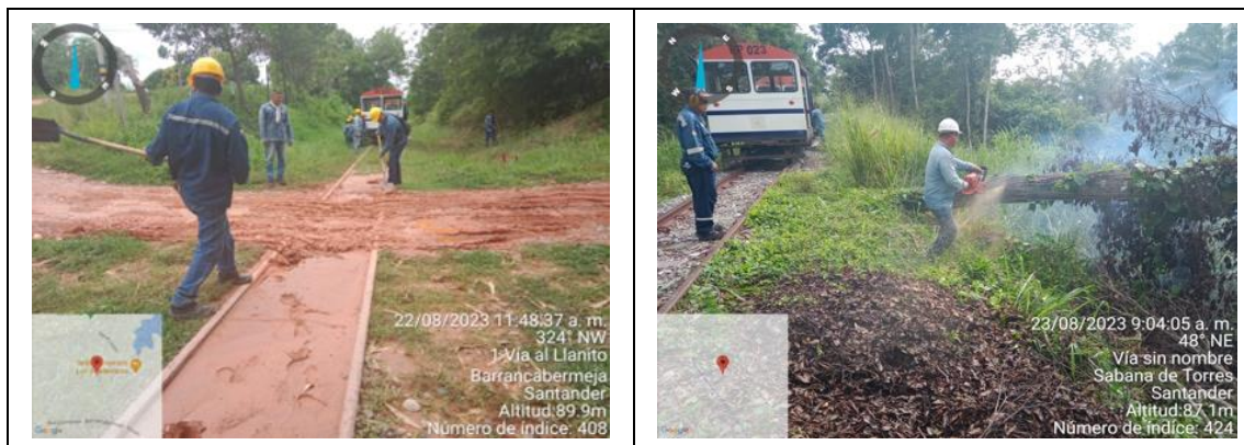
Ilustración 7: Izquierda, Descarne Vía PK442+850; derecha, Retiro de árboles en la vía PK510+000
