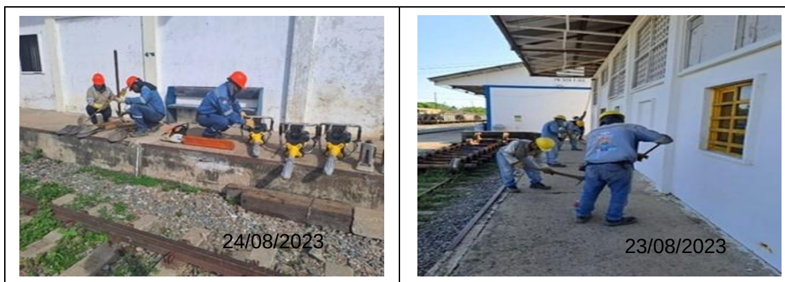
Ilustración 4: Izquierda, Inspección y mantenimiento general de herramientas y equipos; derecha, Aseo General PK328+800
