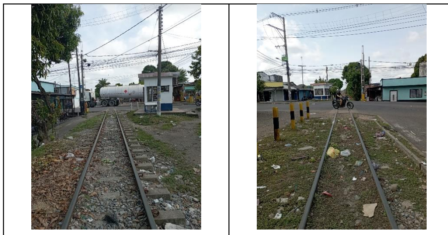
Ilustración 28: Izquierda, vista Sur-Norte; derecha, vista Norte-Sur PN Miraflores PK443+086/105, Barrancabermeja Fuente: Consorcio Gis Red Férrea
