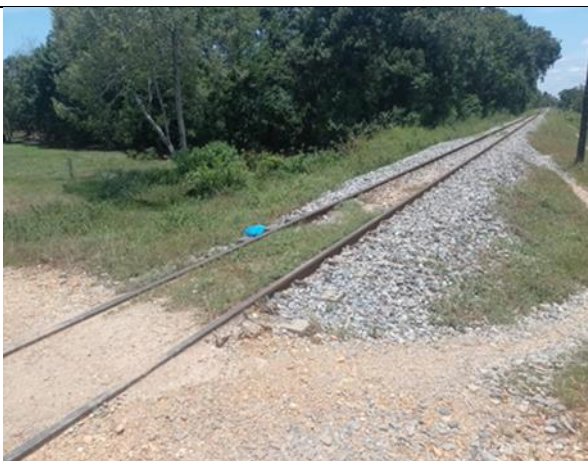
Ilustración 4: Izquierda, Vía colmatada en la parte central, presenta pérdida y desprendimiento progresivo de balasto.; Derecha, Presenta perdida en el hombro. Fuente: Elaboración propia
