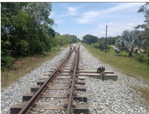
Ilustración 5: Izquierda, Perdida y desprendimiento del material de balasto se encuentra esparcido a varios metros del LI de la vía.; Derecha, Pérdida progresiva del material de balasto.
