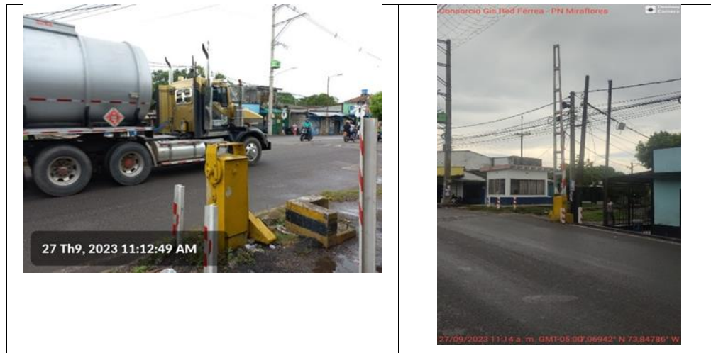
Ilustración 35: Izquierda, vista del soporte de la barrera de seguridad Nor-Orienta, No está la talanquera; derecha, Vista de la barrera de seguridad Sur-Occidental, no funciona. PN Miraflores PK443+086/105, Barrancabermeja
