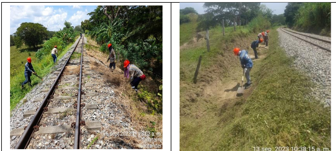
Ilustración 7: Rocería y Deshierbe Manual PK 360+250; Derecha, Limpieza de Cunetas PK 267+240 Fuente: Consorcio San Felipe Férreo
