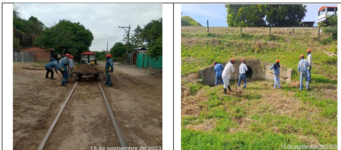
Ilustración 8: Izquierda, Descarne de Vía PK 269+015; derecha, Limpieza de Alcantarillas PK 356+080 Fuente: Consorcio San Felipe Férreo
