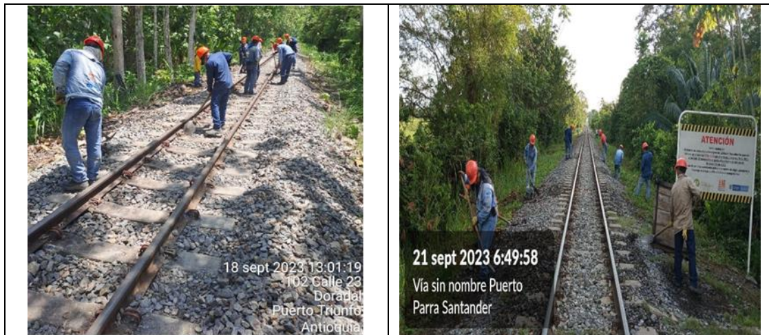
Ilustración 9: Alce-Alineación-Nivelación de Vía PK 246+400; Derecha, Recolección y Perfilado de Balasto PK 376+250
