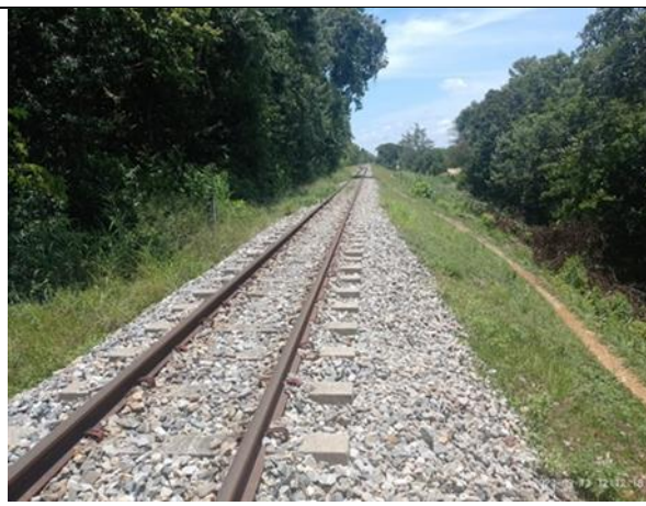
Ilustración 4: Izquierda, Vía colmatada en la parte central, presenta pérdida y desprendimiento progresivo de balasto.; Derecha, Presenta perdida en el hombro. Fuente: Elaboración propia
