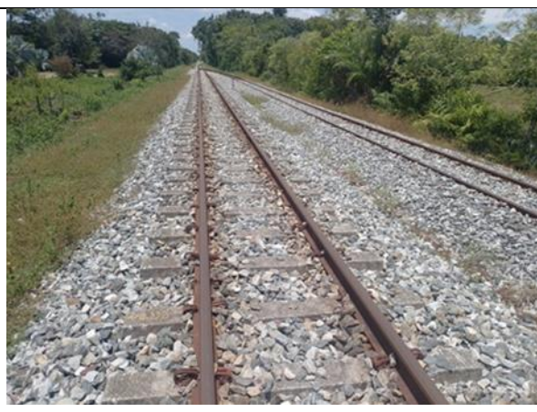
Ilustración 5: Izquierda, Perdida y desprendimiento del material de balasto se encuentra esparcido a varios metros del LI de la vía.; Derecha, Pérdida progresiva del material de balasto.
