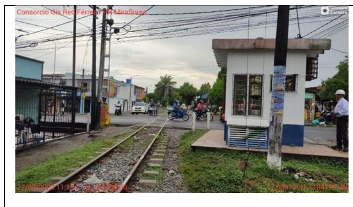
Ilustración 34: Izquierda, vista Sur-Norte, PN Miraflores PK443+086/105, Barrancabermeja Fuente: Consorcio Gis Red Férrea
