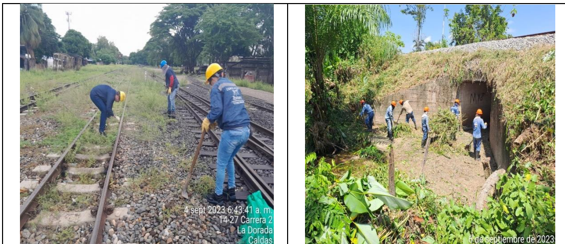
Ilustración 6: Rocería Y Deshierbe Manual PK 202+060; Derecha, Limpieza de Alcantarillas PK 363+721
