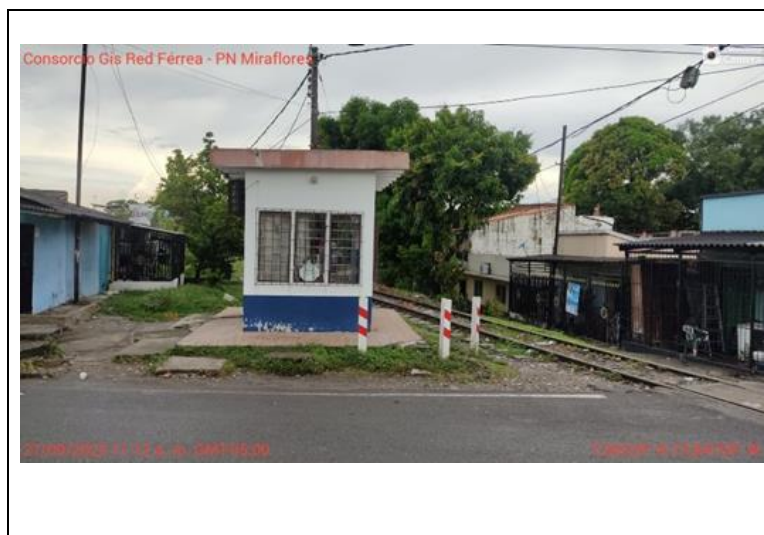
Ilustración 32: Vista General Caseta Paso a Nivel Miraflores PK 443+086/105, Barrancabermeja Fuente: Consorcio Gis Red Férrea
