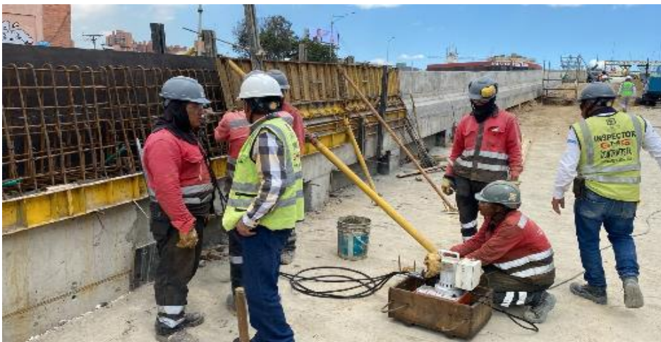
Imagen 6. Fundida de concreto en NEW JERSEY Aroche Norte.
