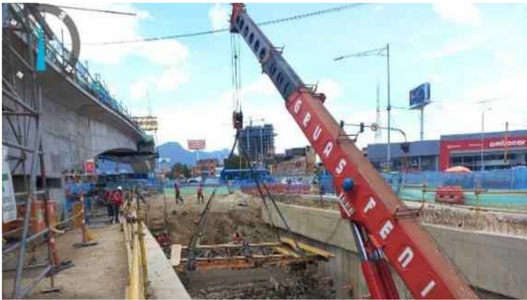
Imagen 8. Instalación puntales para excavación Ramal Norte.
