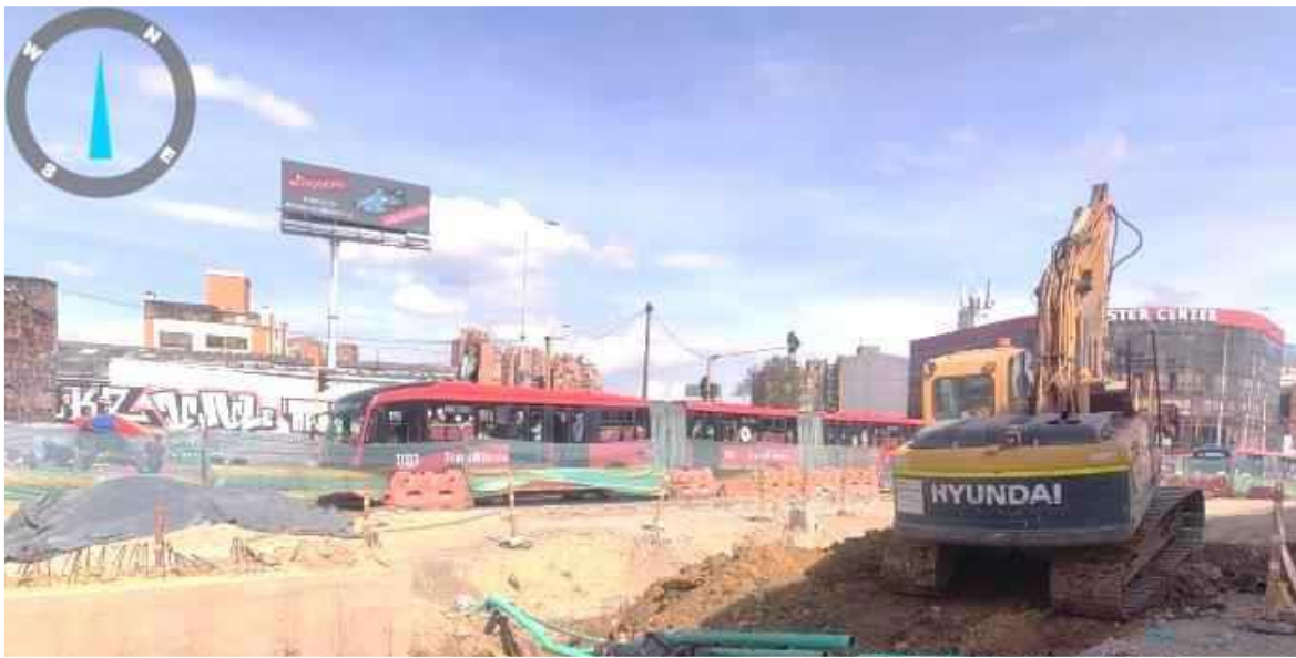
Imagen 9. Excavación Ramal Central
