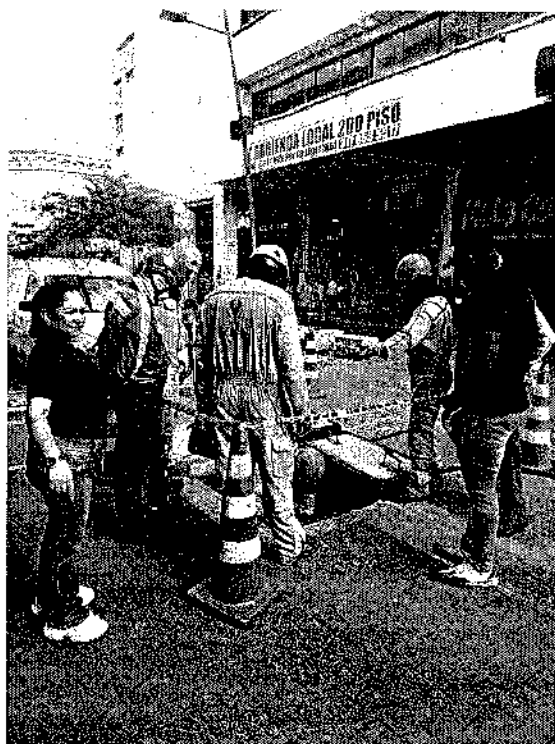
Brinde apoyo en la revisión y mantenimiento de energía del centro comercial.
