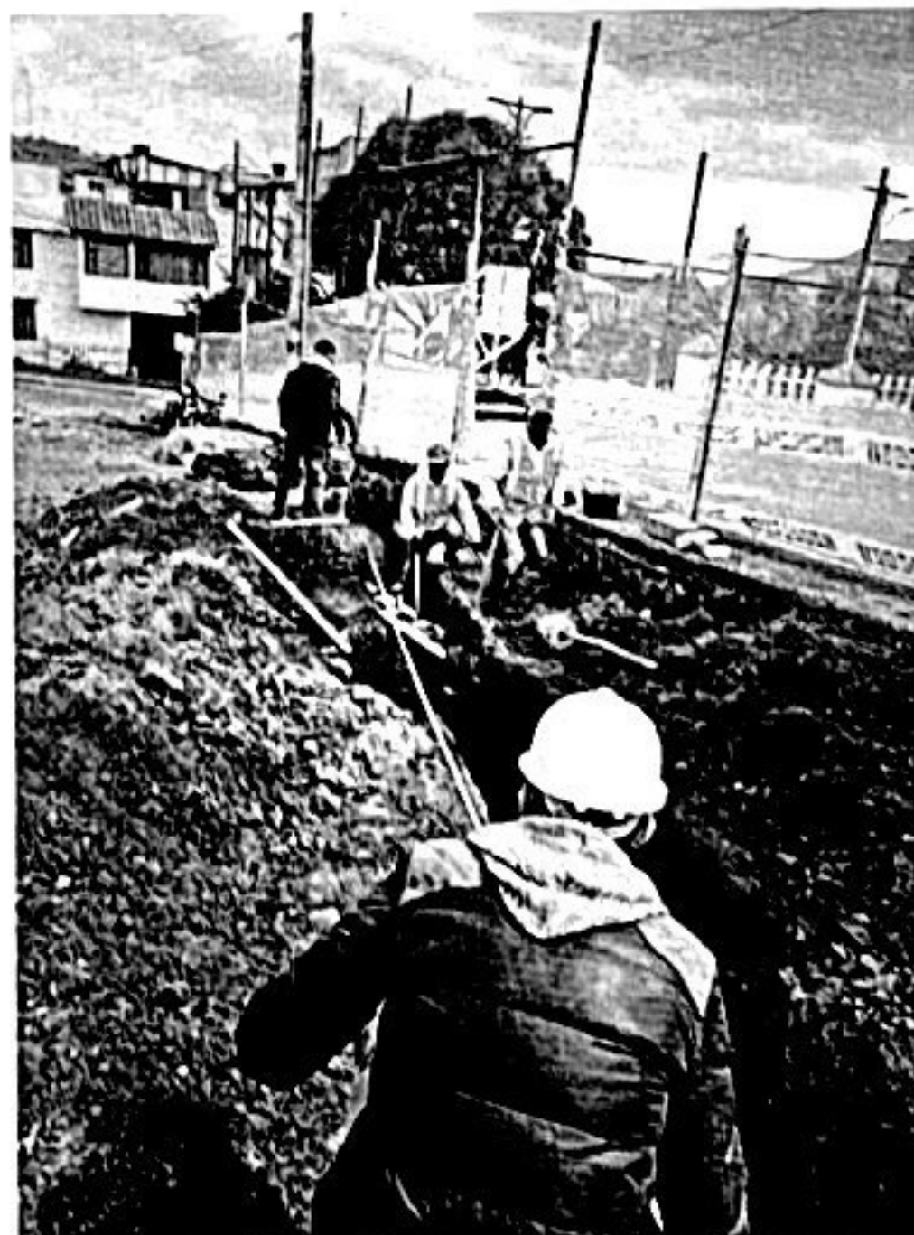
Instalación de Tubería de PVC
