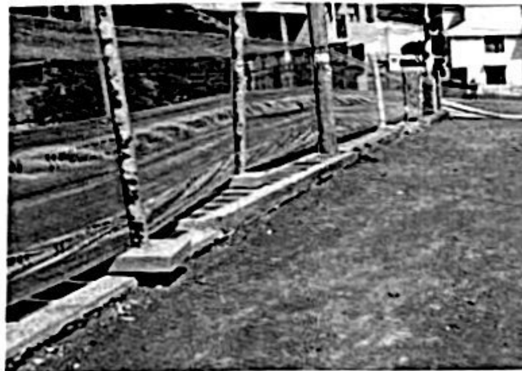
Bordillos fundidos en sitio
