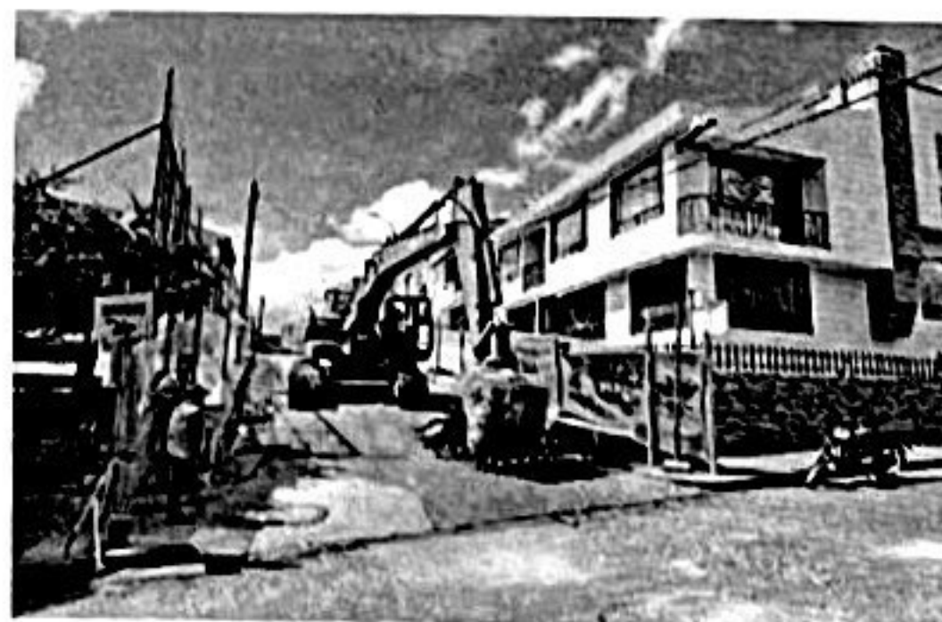
Demolición de concreto y pavimento
