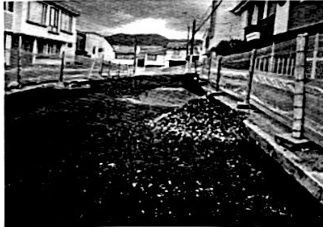
Compactación subrasante, sub base y base
