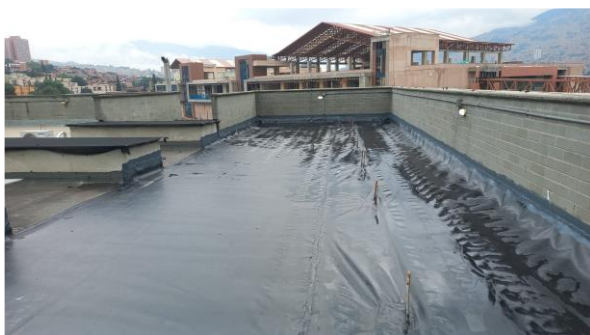
IMPERMEABILIZACION EN AZOTEA
