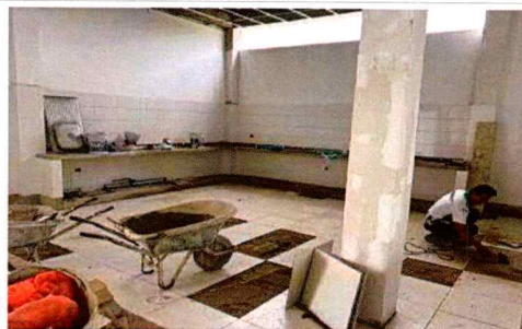
DESCRIPCIÓN: DEMOLICIÓN DE ENCHAPES
