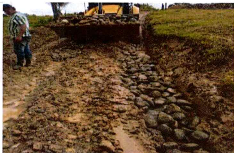
DESCRIPCIÓN: MATERIAL PARA RUTA DE ACCESO
