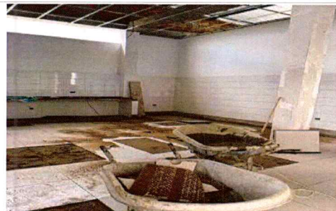
DESCRIPCIÓN: DEMOLICIÓN DE ENCHAPES
