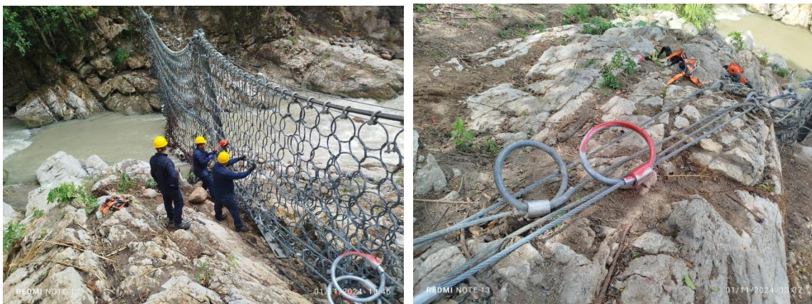
Fotografía 6 y 7. Retensionamiento de cables y cambio de frenos
