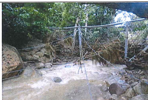
NUEVO MATERIAL RETENIDO EN BARRERA LOS MICOS
