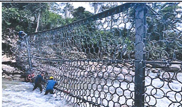
RETENSIONAMIENTO DE CABLES LATERALES BARRERA K-18
