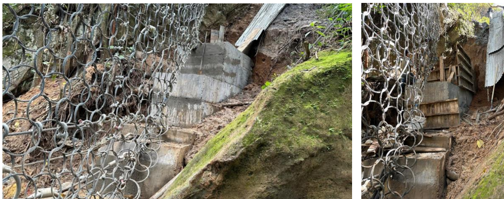
Fotografía 22 y 23. Proceso de construcción protección con concreto
