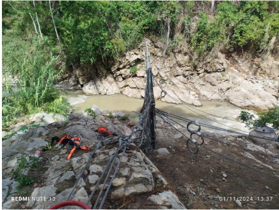
Fotografía 8 y 9. Registro fotográfico de la barrera limpia, 5 frenos ya cambiados y 5 cables tensionados en su totalidad.
