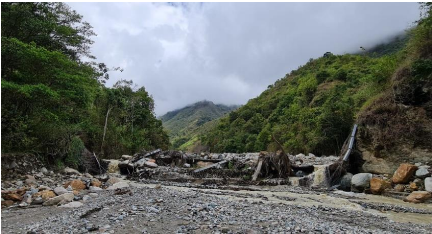
Fotografía 5. Condiciones actuales de la barrera.
