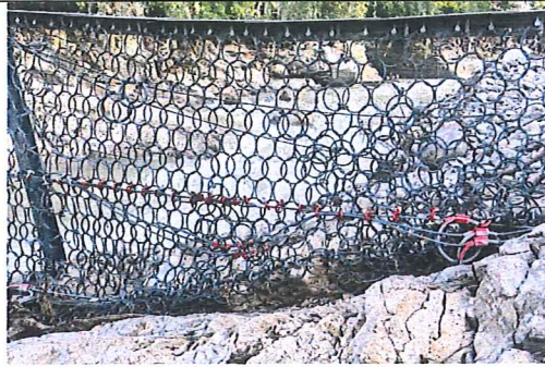
INSTALACIÓN DE GRILLETES DE 1" DE BARRERA DEL K-18
