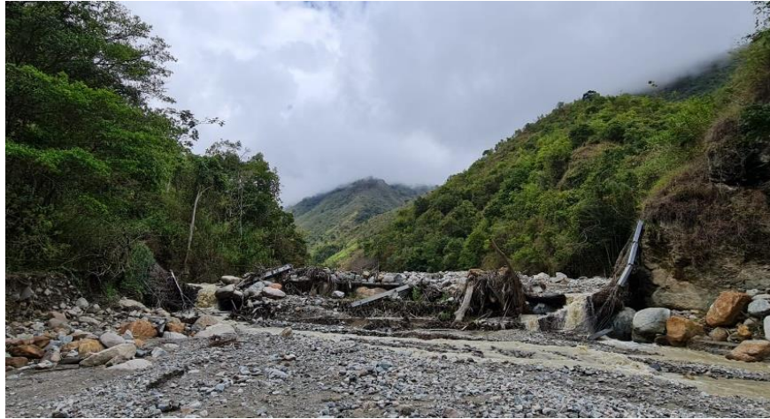
Fotografía 14. Condiciones actuales de la barrera.
