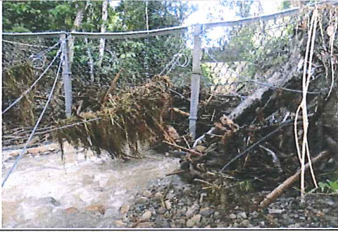
NUEVO MATERIAL RETENIDO EN BARRERA LOS MICOS
