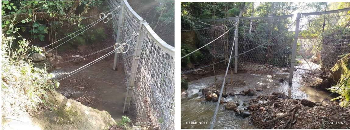
Fotografía 19 y 20. Fotografías de la barrera ya limpia de material
