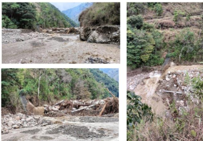
Barrera dinámica No 3 durante la avenida torrencial ocurrida el 26 de marzo de 2024.
