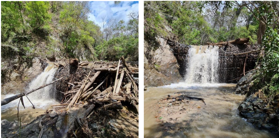
Fotografía 28 y 29. Fotografías del estado actual de la barrera
