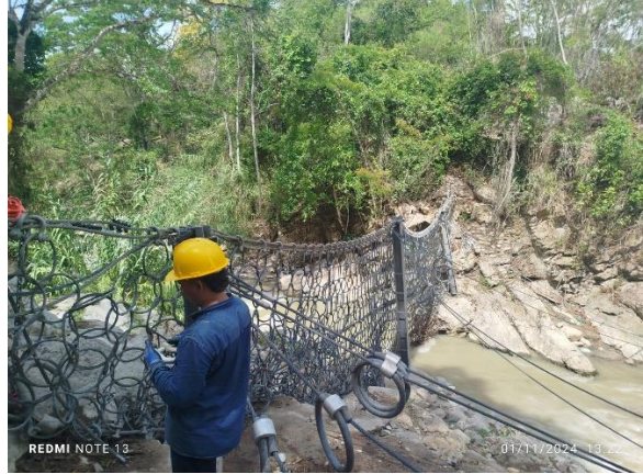
Fotografía 8 y 9. Registro fotográfico de la barrera limpia, 5 frenos ya cambiados y 5 cables tensionados en su totalidad.
