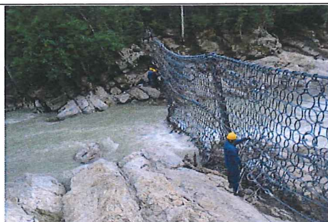
CAMBIO DE FRENOS DE BARRERA DEL K-18
