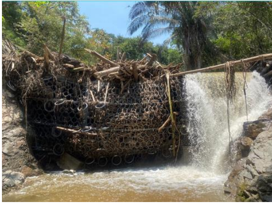
Fotografía 24 y 25. Fotografías de estado inicial de la barrera antes de la limpieza de material
