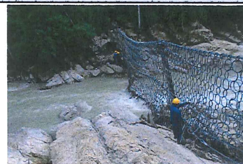
RETENSIONAMIENTO DE CABLES LATERALES BARRERA K-18
