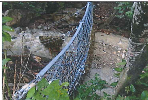
NUEVO MATERIAL RETENIDO EN BARRERA LOS MICOS
