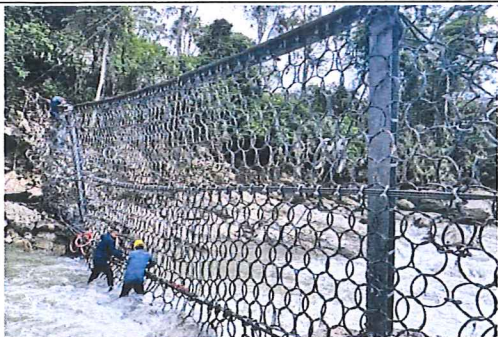
RETENSIONAMIENTO DE CABLES DE BARRERA DEL K-18
