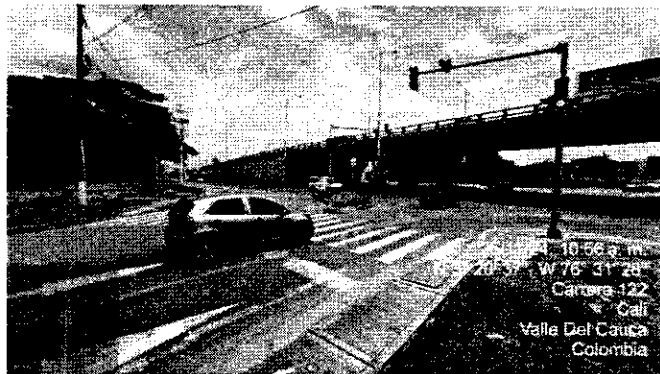
Punto final, box culvert
