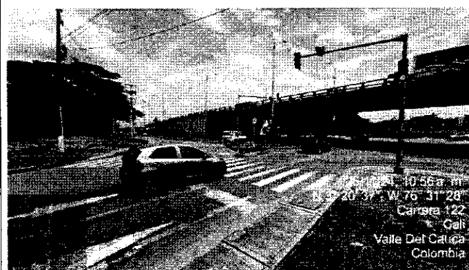
Punto final, box culvert
