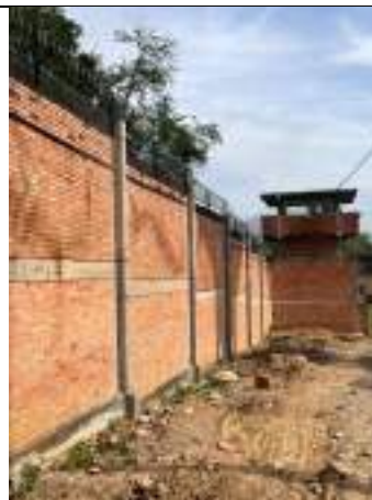
Ilustración 4: 20/12/2024 Lugar de Reforzamiento muro perimetral zona norte e instalación de concertina sobre muro
