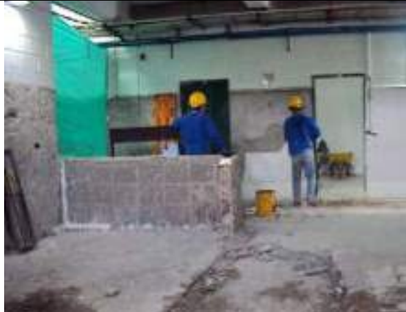
Ilustración 6: 12/09/2024 Picada de pañete de muros
