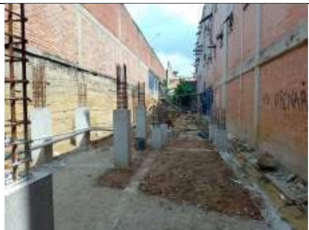
Ilustración 4: 13/01/2025 Fundición de columnas, fundición de vigas de cimentación y excavación de zapatas
