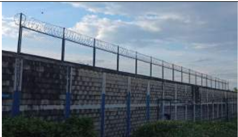
Ilustración 7: 20/12/2024 Instalación de parales y malla eslabonada sobre tanque. Vista exterior
