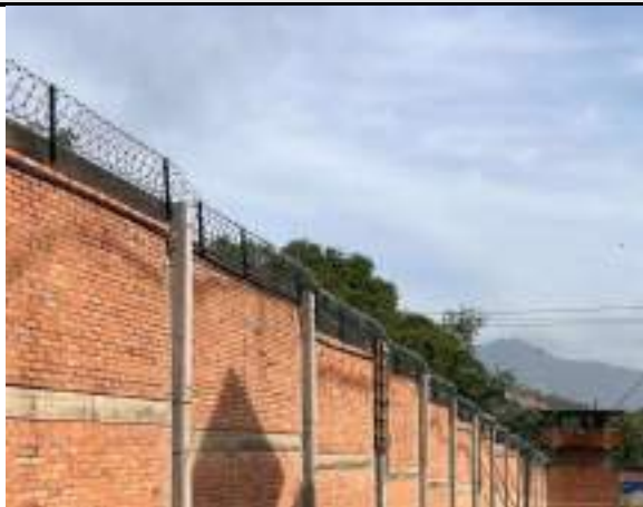
Ilustración 6: 20/12/2024 Instalación de concertina áreas muro perimetral zona norte
