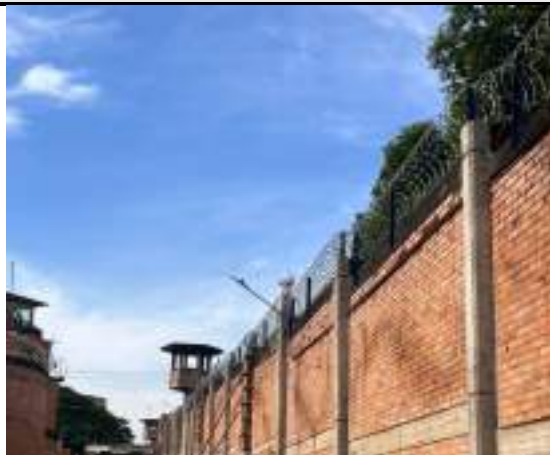
Ilustración 5: 20/12/2024 Instalación de concertina áreas externas e internas
