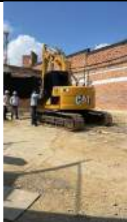
Ilustración 1: 13/01/2025 Ingreso de retroexcavadora para iniciar actividades de excavación
