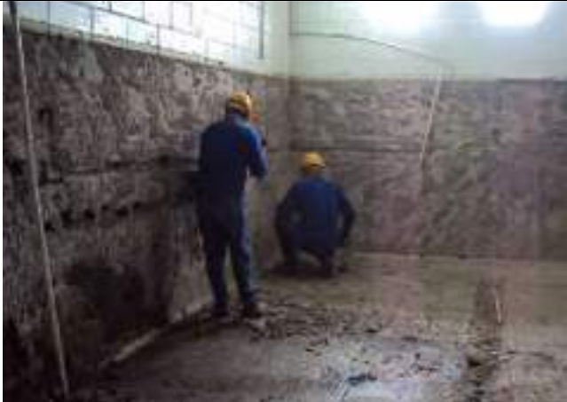
Ilustración 5: 21/10/2024 Picada de pañete de muros
