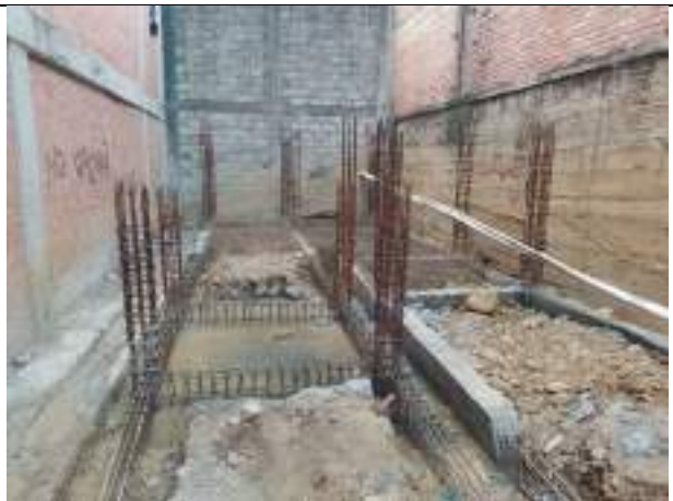
Ilustración 9: 20/12/2024 Fundición de 20 zapatas y fijación de acero de columnas
