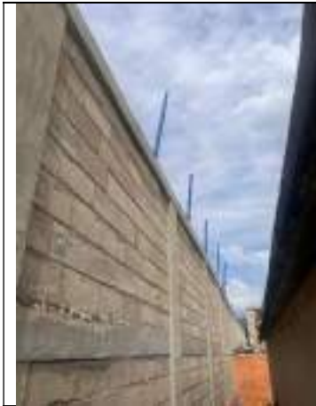
Ilustración 7: 06/12/2024 Instalación de parales
