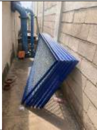
Ilustración 8: 06/12/2024 Suministro de marco con malla eslabonada.
