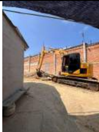
Ilustración 2: 13/01/2025 Excavación mecánica Garita 3
