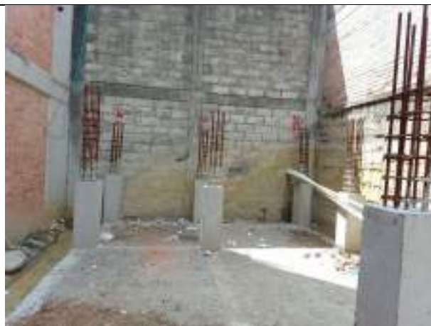
Ilustración 3: 13/01/2025 Fundición de columnas
