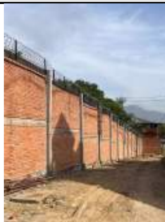
Ilustración 2: 20/12/2024 Lugar de Reforzamiento muro perimetral
