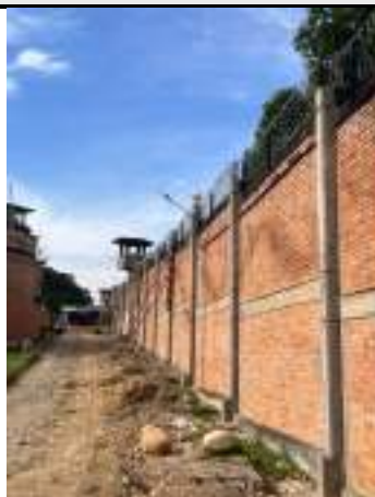
Ilustración 1: 20/12/2024 Lugar de Reforzamiento muro perimetral zona norte e instalación de concertina sobre muro
