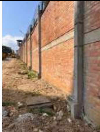
Ilustración 7: 13/01/2025 Muro perimetral reforzado.
