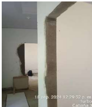
Figura 5. Se realizan instalaciones de pisos en cabaña 3 sede Turbo.
