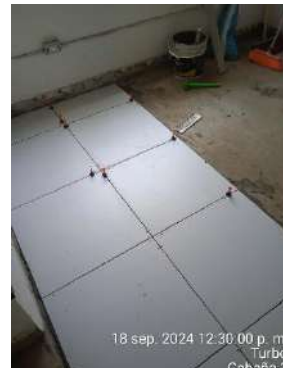
Figura 6.. Se realizan instalaciones de pisos en cabaña 3 sede Turbo.
