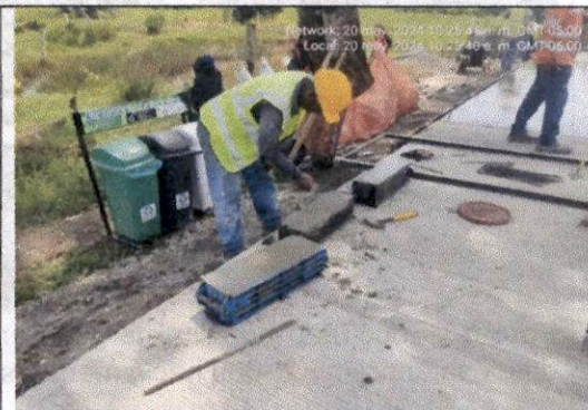
Fotografía 2. Toma de muestras de concreto tipo viguetas.
