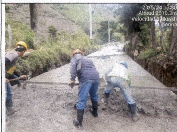
Foto 06 Construcción de pavimento en concreto hidráulico MR 38 KGF/CM2, colocación de canastilla y pasadores de 1" según diseño y modulación, desde la abscisa K1+914,75 hasta K1+903,75, se sacan muestras de concreto para fallar (viguetas y cilindros).
