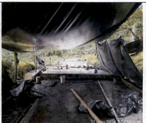
Foto 14 Construcción de pavimento en concreto hidráulico MR 38 KGF/CM2, colocación de canastilla y pasadores de 1" según diseño y modulación, desde la abscisa K1+854,25 hasta K1+851,50.
