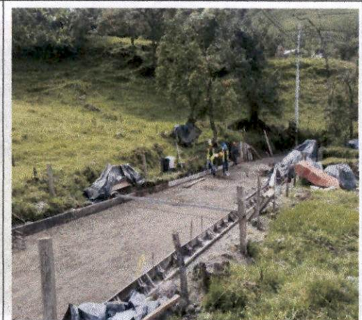
Foto 9 Colocación de formaleta para vaciado de concreto hidráulica abscisa K1+879 a K1+854,25.
