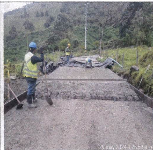
Foto 11 Construcción de pavimento en concreto hidráulico MR 38 KGF/CM2, colocación de canastilla y pasadores de 1" según diseño y modulación, desde la abscisa K1+865,25 hasta K1+854,25, se sacan muestras de concreto para fallar (viguetas y cilindros).
