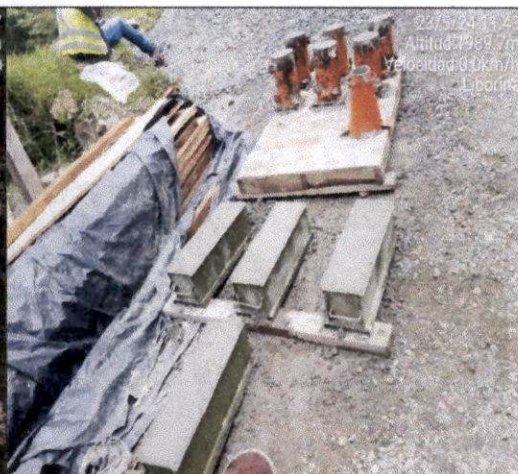
Foto 05 Muestras de concreto (Viguetas y cilindros) del vaciado del pavimento hidráulico MR 38 Kg/cm2, desde la abscisa K1+914,75 hasta K1+903,75.
