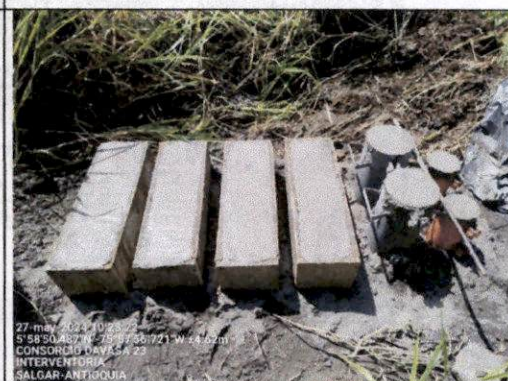
Foto 32 Tramo vial SALGAR: Salgar - La Cámara - La Quiebra (60AN05-1) - Control de Calidad, se han tomado diferentes muestras a la mezcla de concreto 28MPa viguetas y cilindros de 6" y 4" del vaciado del 27-05-2024 tramo del K1+848 al K1+810, para someterlos posterior al curado de los 14 o 28 días a pruebas de flexión y compresión.
