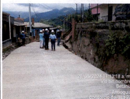
Foto 14. Recorrido de obra.
