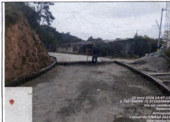
Foto 01 Construcción de losa entre abscisa K0+520 a K0+509.
