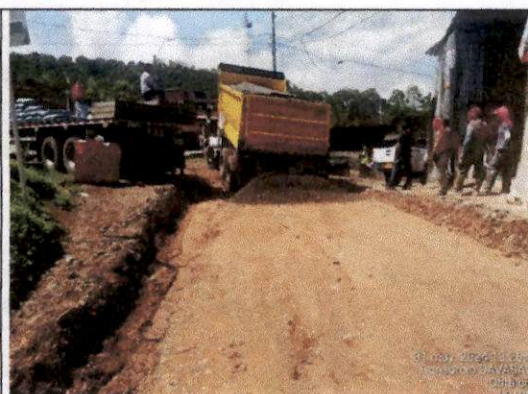
Foto 14 Instalación base granula k0+000.
