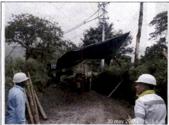
Foto 13 Construcción de invernadero abscisa K1+853 hacia menores.
