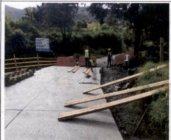
Foto 15 Encofrado bordillo margen derecha desde la abscisa K2+000 hacia menores.
