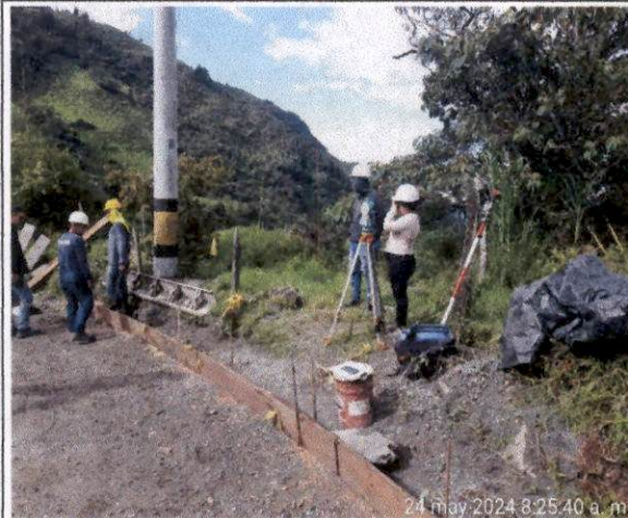
Foto 07 La comisión de topografía localiza los módulos del pavimento de concreto hidráulico desde la abscisa K1+903,75 hasta K1+887,25.
