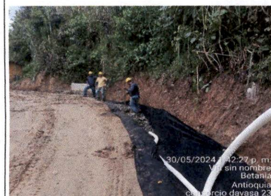
Foto 11. Construcción de filtro longitudinal K0+087.
