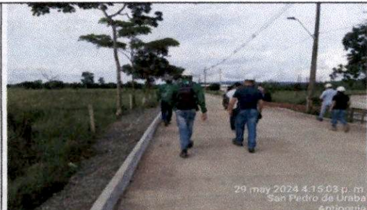
Fotografía 10. Recorrido por la obra en compañía del contratista y el supervisor tecnico.
