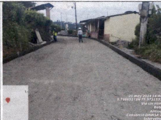
Foto 02 Encofrado entre abscisa K0+509 a K0+500.
