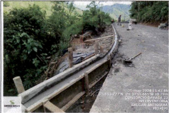
Foto 33 Tramo vial SALGAR: Salgar - La Cámara - La Quiebra (60AN05-1) - Vaciado bordillo 21 MPA desde el K1+890 hasta el K1+866 (24ml)
