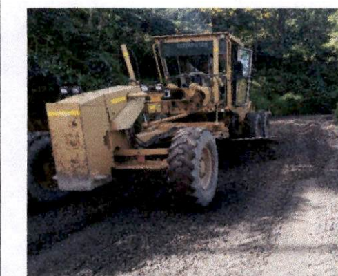
Foto 12. Extensión de base granular: K0+300 a K0+100.
