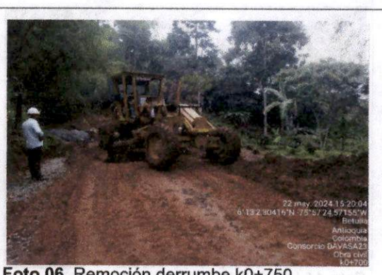
Foto 06. Remoción derrumbe k0+750.
