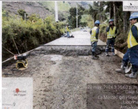
Foto 02 Construcción de pavimento en concreto hidráulico MR 38 KGF/CM2, colocación de canastilla y pasadores de 1" según diseño y modulación, se sacan muestras de concreto para fallar (viguetas y cilindros).
