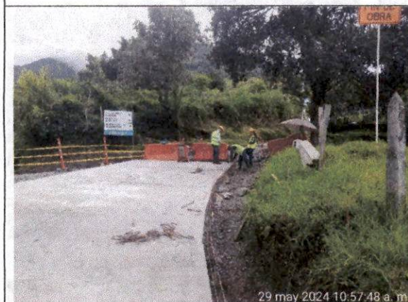
Foto 12 Colocación de acero de refuerzo para construcción de bordillo margen derecha desde la abscisa K2+000 hacia menores.
