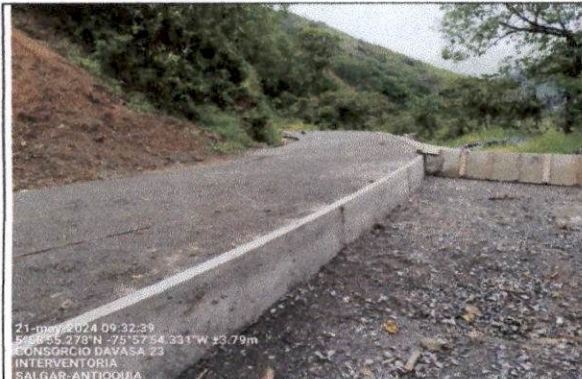
Foto 19 Tramo vial SALGAR: Salgar - La Cámara - La Quiebra (60AN05-1) - Bordillo terminado tramo K1+950 hasta la K2+150.
