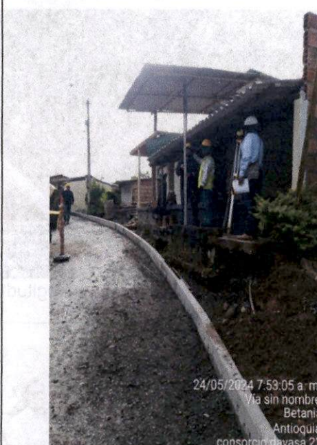
Foto 08. Verificación topográfica base granular. K0+500 a K0+485.
