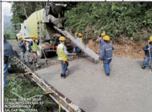
Foto 24 Tramo vial SALGAR: Salgar - La Cámara - La Quiebra (60AN05-1) - Instalación de canastillas y dovelas de 40 cm, 13 unidades por canastilla. El diámetro de las barras es de 1" (25.4 mm) y la separación entre centros de 20cm, durante el vaciado de concreto hidráulico MR38 tramo del K1+886 hasta el K1+848.
