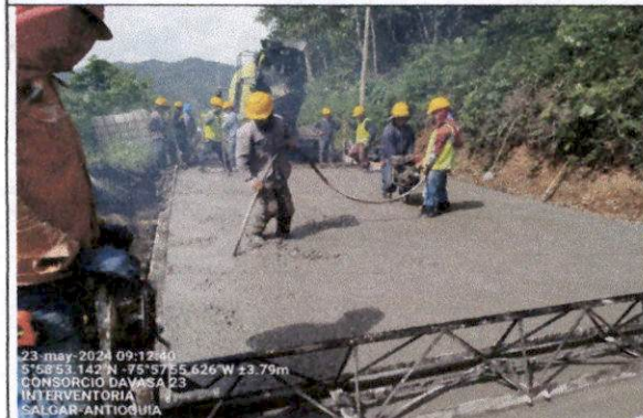
Foto 23 Tramo vial SALGAR: Salgar - La Cámara - La Quiebra (60AN05-1) -Vaciado de concreto hidráulico MR38 tramo del K1+886 hasta el K1+848.
