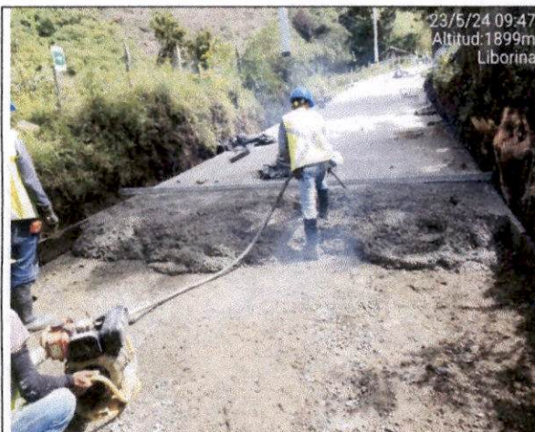
Foto 04 Construcción de pavimento en concreto hidráulico MR 38 KGF/CM2, colocación de canastilla y pasadores de 1" según diseño y modulación, desde la abscisa K1+914,75 hasta K1+903,75, se sacan muestras de concreto para fallar (viguetas y cilindros).
