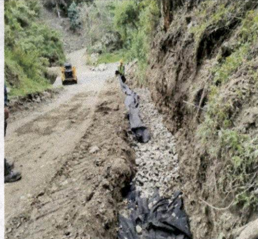
Foto 01 Construcción de filtro francés, se realizan las siguientes actividades: excavación mecánica, colocación de geotextil NT2500, colocación de tubería perforada de 4", colocación de material filtrante de 11/2", desde la abscisa K1+160 hasta K1+280
