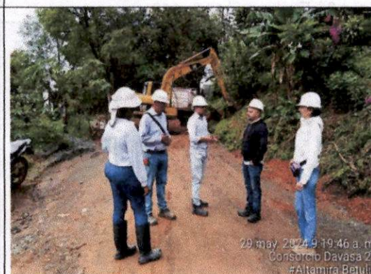
Foto 10 Recorrido de obra contratista e interventoría.
