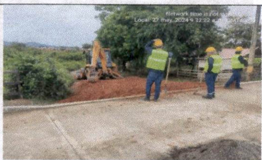
Fotografía 8. Adecuación con afirmado para acceso de motocicletas y vehículos.
