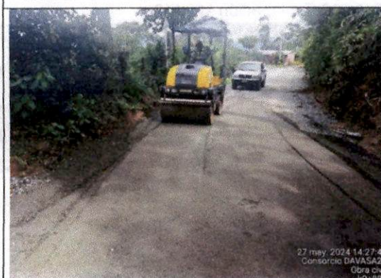
Foto 09 Instalación base granula k0+880.
