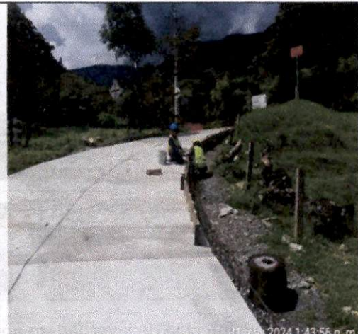
Foto 22 Encofrado bordillo margen derecha desde la abscisa K2+000 hacia menores.
