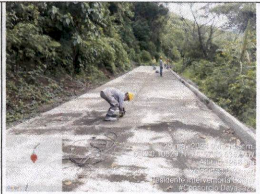
Foto 34 Tramo vial SALGAR: Salgar - La Cámara - La Quiebra (60AN05-1). Construcción de junta de dilatación para piso. Se realiza el repaso de las juntas de dilatación con cortadora, continuando las labores de limpieza de juntas, instalación de sellador elástico de poliuretano del K2+150 al 2+120.
