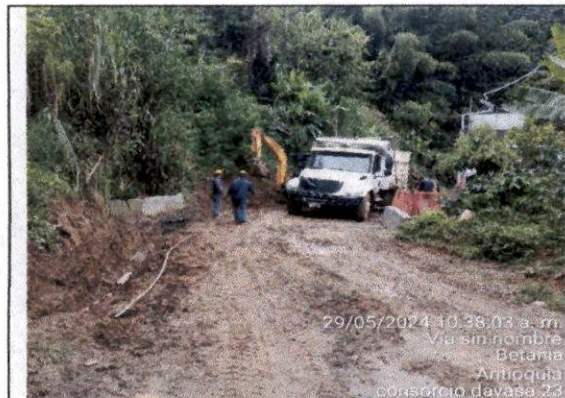
Foto 09. Excavación de filtro longitudinal K0+087.
