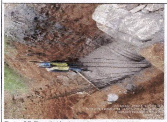
Foto 05 Fundición losa descole k0+270
