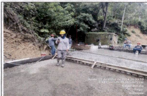
Foto 17 Tramo vial SALGAR: Salgar - La Cámara - La Quiebra (60AN05-1) - Vaciado de concreto hidráulico MR38 tramo de cinta de pavimento del K1+886 a la K1+892.
