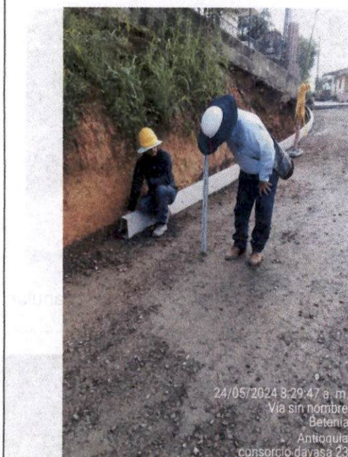
Foto 07. Verificación topográfica base granular. K0+500 a K0+485.
