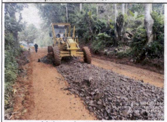
Foto 03 Mejoramiento de la subrasante k0+220.
