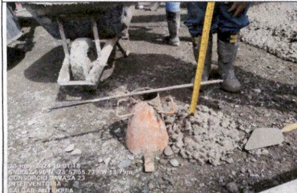
Foto 21 Tramo vial SALGAR: Salgar - La Cámara - La Quiebra (60AN05-1) - Prueba de asentamiento al concreto MR38 -4"+/- 1".
