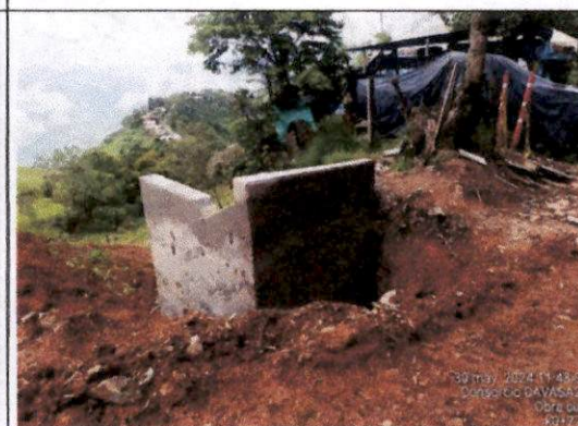
Foto 12 Fundición descole k0+270.
