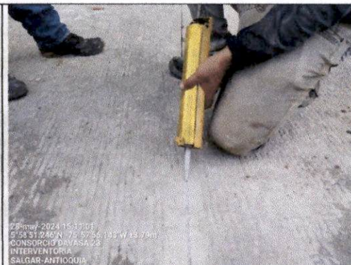
Foto 30 Tramo vial SALGAR: Salgar - La Cámara - La Quiebra (60AN05-1) – Construcción de junta de dilatación para piso. Se realiza instalación de sellador elástico de poliuretano de prueba, marca (Polyurethane Sealant).
