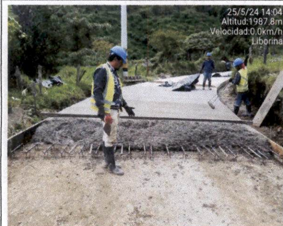
Foto 11 Construcción de pavimento en concreto hidráulico MR 38 KGF/CM2, colocación de canastilla y pasadores de 1" según diseño y modulación, desde la abscisa K1+887,37 hasta K1+879, se sacan muestras de concreto para fallar (viguetas y cilindros).
