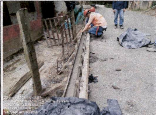
Foto 20 Tramo vial SALGAR: Salgar - La Cámara - La Quiebra (60AN05-1) - Vaciado bordillo 21 MPA desde la K1+927 hasta la K1+907 (20ml).
