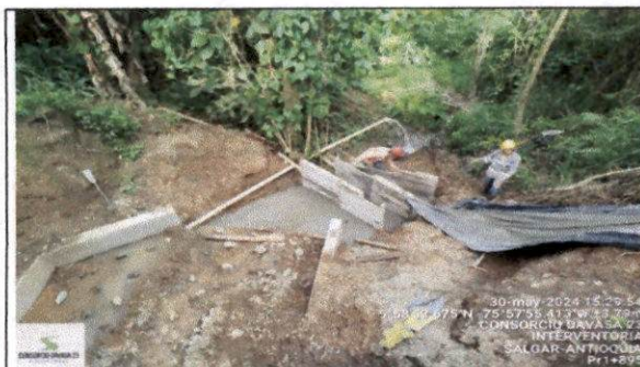
Foto 37 Tramo vial SALGAR: Salgar - La Cámara - La Quiebra (60AN05-1) – Durante el periodo se intervino el descole de la alcantarilla Doble de 36" del K1+895 (Disipador) con actividades de vaciado de solado.
