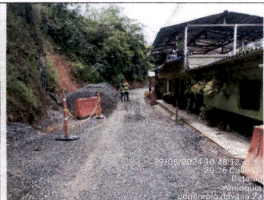
Foto 10. Nivelación de base mediante topografía.
