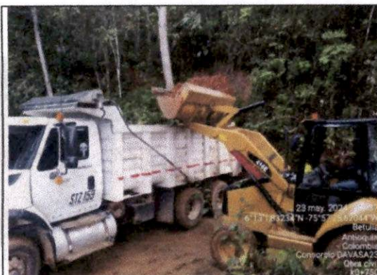
Foto 07 Remoción derrumbe k0+750.
