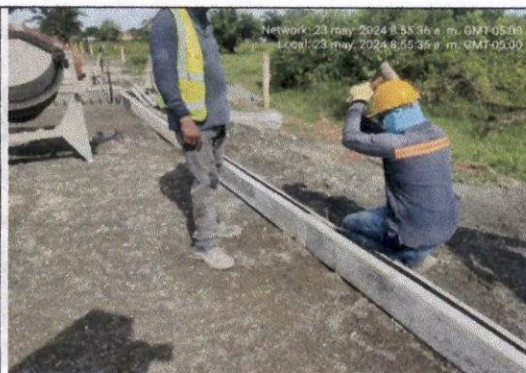
Fotografía 4. Instalación de rieles para pavimento.
