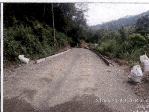
Foto 18 Tramo vial SALGAR: Salgar - La Cámara - La Quiebra (60AN05-1) - Instalación de 41ml de encofrado de la cinta de pavimento desde la K1+886 hasta la K1+845.
