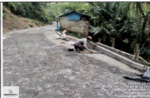
Foto 38 Tramo vial SALGAR: Salgar - La Cámara - La Quiebra (60AN05-1) – También se realizó el vaciado en sitio de losa de ajuste MR38 del K1+888 al K1+901,50. (sobrecanchos de calzada)
