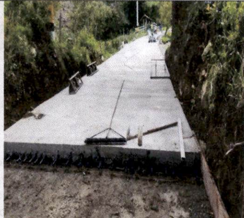
Foto 03 Construcción de pavimento en concreto hidráulico MR 38 KGF/CM2, colocación de canastilla y pasadores de 1" según diseño y modulación, se sacan muestras de concreto para fallar (viguetas y cilindros).
