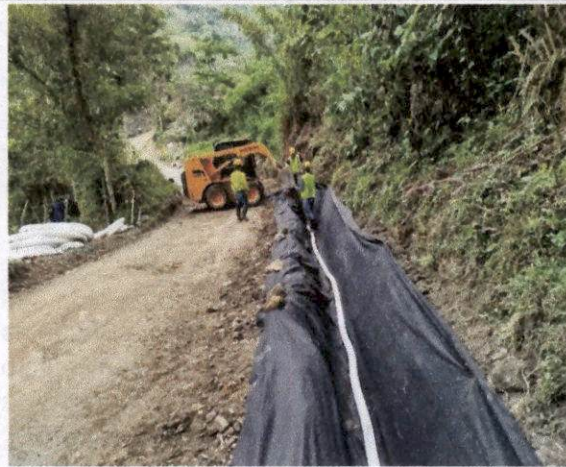
Foto 01 Construcción de filtro francés, se realizan las siguientes actividades: excavación mecánica, colocación de geotextil NT2500, colocación de tubería perforada de 4", colocación de material filtrante de 11/2", desde la abscisa K1+160 hasta K1+280.
