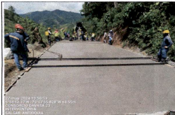
Foto 29 Tramo vial SALGAR: Salgar - La Cámara - La Quiebra (60AN05-1) - Realización texturizado de la cinta de pavimento en concreto hidráulico tipo MR38, tramo de vaciado del K1+848 hasta el K1+810.
