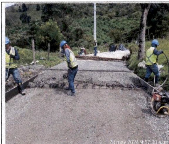
Foto 10 Construcción de pavimento en concreto hidráulico MR 38 KGF/CM2, colocación de canastilla y pasadores de 1" según diseño y modulación, desde la abscisa K1+879 hasta K1+865,25, se sacan muestras de concreto para fallar (viguetas y cilindros).
