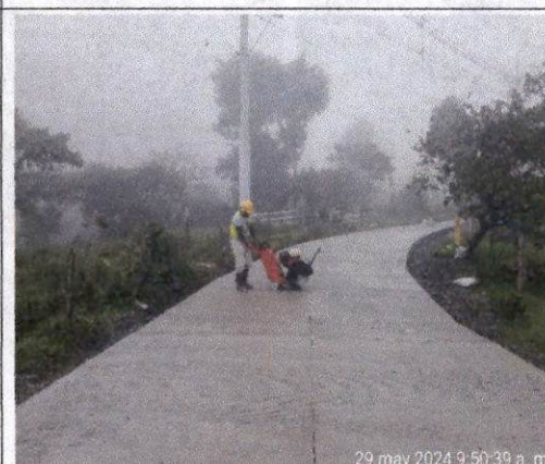
Foto 16 Construcción de junta de dilatación para piso, Transversal y longitudinal.
