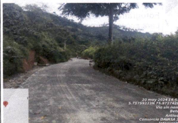
Foto 03 Extendida y compactación de la Base Granular km 0+800.
