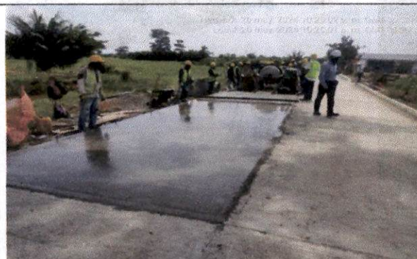
Fotografía 1. Fundición de MR en lateral izquierdo.
