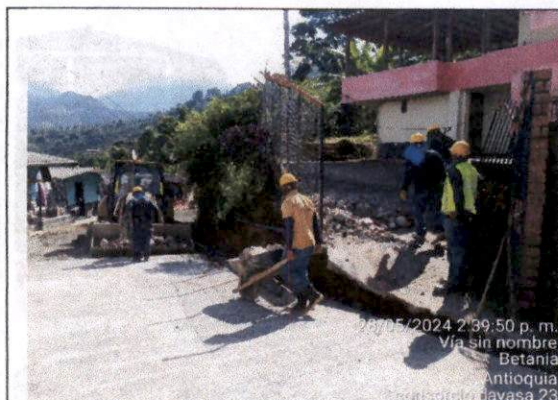
Foto 05. Verificación topográfica base granular. K0+500 a K0+485.
