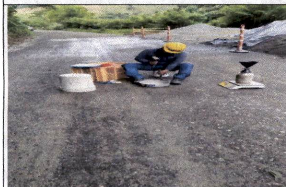
Foto 31 Tramo vial SALGAR: Salgar - La Cámara - La Quiebra (60AN05-1) - Control de Calidad, el día 29 de mayo de 2024 el Contratista realiza a través del técnico del Laboratorio de materiales ENSASE, la toma en campo de 5 densidades con cono y arena, para liberar la capa de subbase del tramo comprendido entre el K1+740 al K1+320.
