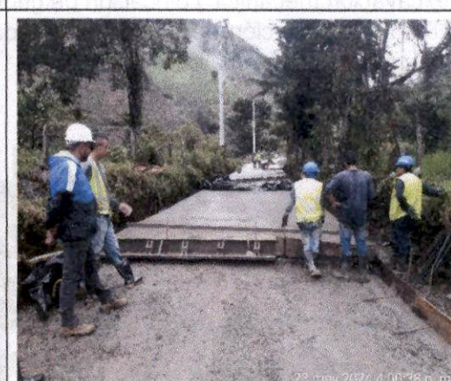
Foto 08 Construcción de pavimento en concreto hidráulico MR 38 KGF/CM2, colocación de canastilla y pasadores de 1" según diseño y modulación, desde la abscisa K1+914,75 hasta K1+903,75, se sacan muestras de concreto para fallar (viguetas y cilindros).
