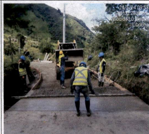
Foto 8 Construcción de pavimento en concreto hidráulico MR 38 KGF/CM2, colocación de canastilla y pasadores de 1" según diseño y modulación, desde la abscisa K1+903,75 hasta K1+887,25, se sacan muestras de concreto para fallar (viguetas y cilindros).
