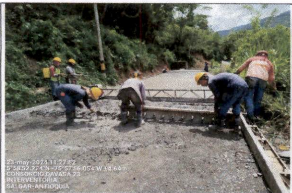
Foto 25 Tramo vial SALGAR: Salgar - La Cámara - La Quiebra (60AN05-1) - Instalación de formaleta para definir junta de construcción en el K1+848.
