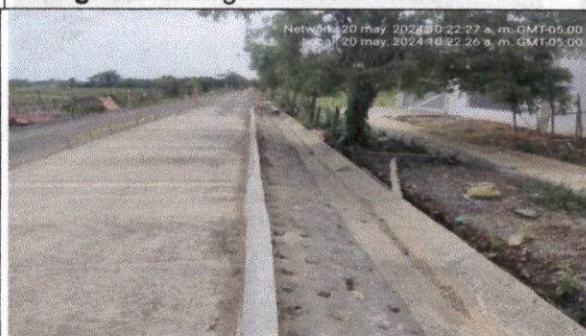
Fotografía 7. Construcción de cuneta y enrocado en lateral derecho.
