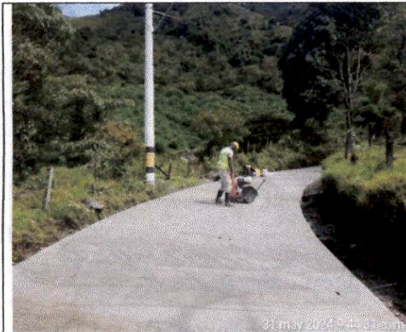
Foto 21 Construcción de junta de dilatación para piso Transversal y longitudinal desde la abscisa K1+950 hacia menores.
