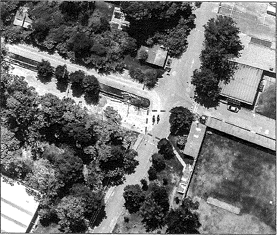
Ingreso a la escuela de caballería, zona de intervención
