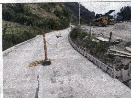
Foto 15 Vaciado de bordillo sobre la margen izquierda desde el K1+725 al K1+694,60, se utiliza concreto de 21 Mpa. Toma de muestras tipo cilindro.
