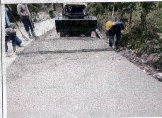
Foto 20 Construcción de pavimento en concreto hidráulico MR 38 KGF/CM2, vaciado de módulos de losas de pavimento rígido medio carril margen izquierda abscisa K1+408,85 a K1+359,35.
