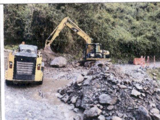
Foto 35 Obras complementarias para atender la problemática del sector de la Batea desde el K1+295 hasta el K1+270. Se realiza Jarillón para encausar la corriente de agua y poder dar apertura a las actividades de demolición y excavación.
