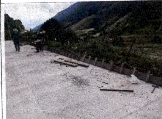
Foto 23 Construcción bordillo 21MPa, colocación de acero y encofrado de bordillo sobre la margen izquierda desde el K1+528,17 al K1+451,47, se utiliza concreto de 21 Mpa
