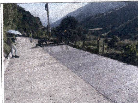
Foto 13 Construcción de pavimento en concreto hidráulico MR 38 KGF/CM2, vaciado de losas de concreto hidráulico medio carril margen izquierda abscisa K1+581,8 a K1+557,05, se aplica Antisol.
