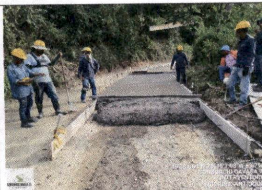
Foto 32 Construcción de pavimento en concreto hidráulico MR 38 KGF/CM2, vaciado de módulos de losas de 2.30x2.75 medio carril margen derecha abscisa K1+255 a K1+246,8.
