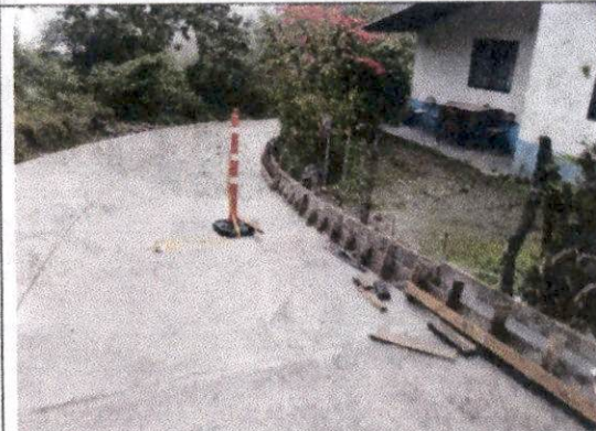
Foto 28 Construcción bordillo 21MPA, colocación de acero y encofrado de bordillo sobre la margen izquierda desde el K1+384,30 al K1+360,09, se utiliza concreto de 21 Mpa.
