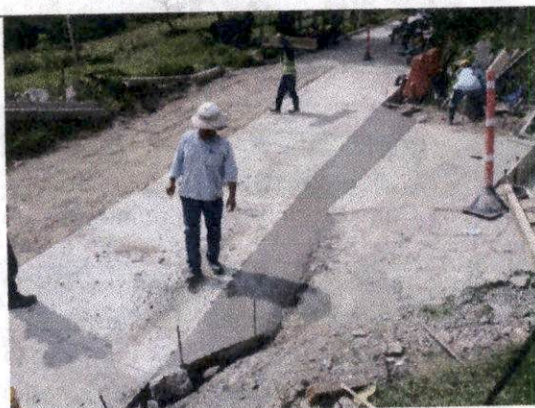
Foto 2 Construcción de pavimento en concreto hidráulico MR 38 KGF/CM2, vaciado de concreto hidráulico en la zona de empalme entre la vía y la carrera 7ma. Entre la K1+739,02 y la K1+751,12, se aplica Antisol.
