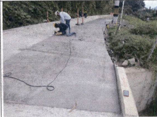
Foto 12 Construcción de pavimento en concreto hidráulico MR 38 KGF/CM2, vaciado de losas de concreto hidráulico medio carril margen izquierda abscisa K1+603,8 a K1+581,8, se aplica Antisol.
