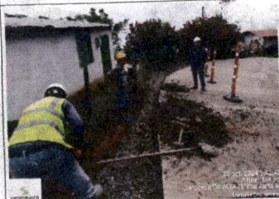
Foto 41 Excavación muro de confinamiento k0+460
