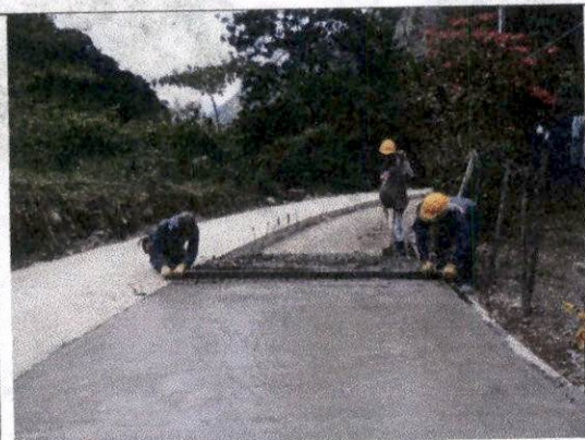
Foto 19 Construcción de pavimento en concreto hidráulico MR 38 KGF/CM2, vaciado de módulos de losas de 2.30x2.75 medio carril margen izquierda abscisa K1+408,85 a K1+359,35.
