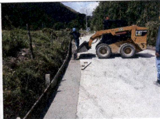
Foto 22 Construcción de pavimento en concreto hidráulico MR 38 KGF/CM2, vaciado de sobreanchos de calzada en concreto hidráulico, carril margen izquierda abscisa K1+538 hasta el K1+526,50, se aplica Antisol.
