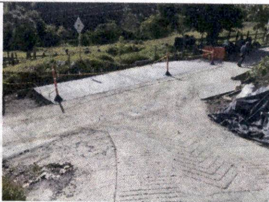
Foto 8 Construcción de pavimento en concreto hidráulico MR 38 KGF/CM2, vaciado de losas de concreto hidráulico medio carril margen izquierda abscisa K1+752,8 a K1+741,8, se aplica Antisol.
