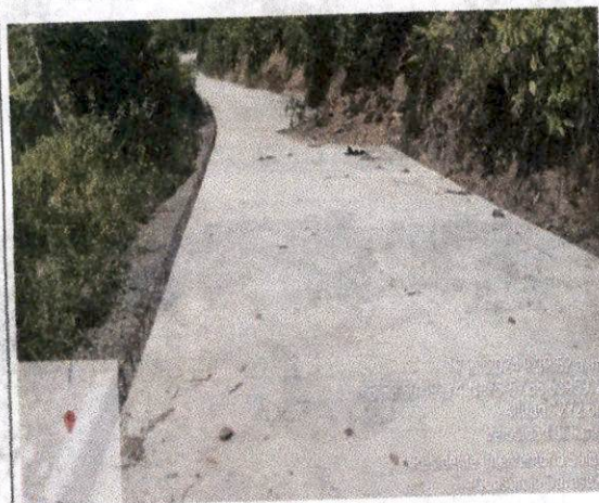
Tramo vial SALGAR: Salgar - La Cámara - La Quebra (60AN05-1) - Se realizan actividades de construcción de bordillo - Colocación de Acero de refuerzo fy=420 Mpa (Grado 60), desde el K1+787 hasta el K1+759.
