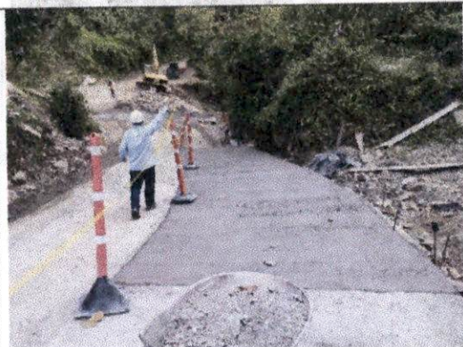
Foto 29 Construcción de pavimento en concreto hidráulico MR 38 KGF/CM2, vaciado de módulos de losas de pavimento rígido medio carril margen izquierda abscisa K1+359,35 a K1+308,10.
