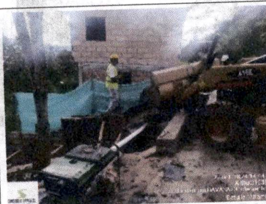
Foto 40 fundición de paredes de canal disipador
