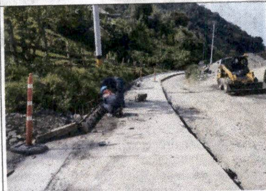
Foto 3 Construcción de bordillo 21MPa, colocación de acero, encofrado y vaciado de bordillo carril margen derecha abscisa K1+725,25 a K1+738,95.
