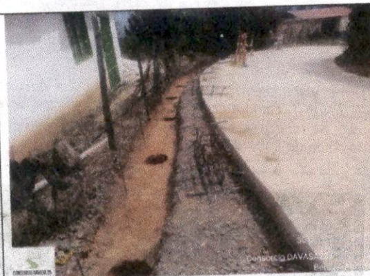
Foto 9 Construcción de micropilotes
