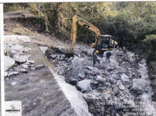
Foto 36 Obras complementarias para atender la problemática del sector de la Batea desde el K1+295 hasta el K1+270. Se adelantan labores de conformación de acceso para ingresar la maquinaria, y posteriormente se apertura las actividades de demolición de la estructura hidráulica existente con compresor y martillo.
