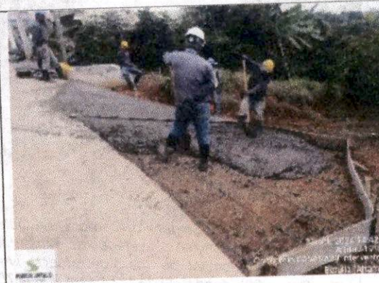
Foto 12 Extensión de concreto de empalme para acceso a vía vereda k0+445.
