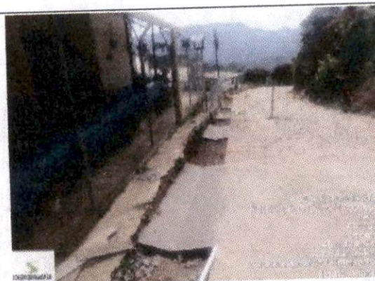
Foto 8 Fundición de cunetas k0+400.
