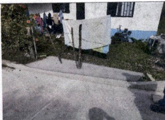
Foto 30 Construcción de pavimento en concreto hidráulico MR 38 KGF/CM2, vaciado de rampa de acceso a predio privado en concreto hidráulico, desde el K1+387,90 hasta el K1+384,30 (3.6m)
