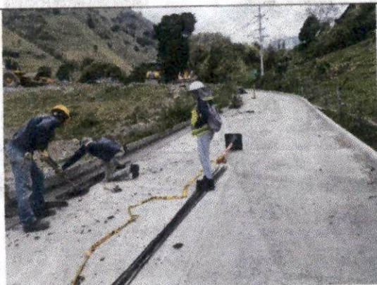
Foto 17 Construcción de pavimento en concreto hidráulico MR 38 KGF/CM2, vaciado de sobreanchos de vía en concreto hidráulico, carril margen izquierda abscisa K1+695 hasta el K1+598,30, se aplica Antisol.
