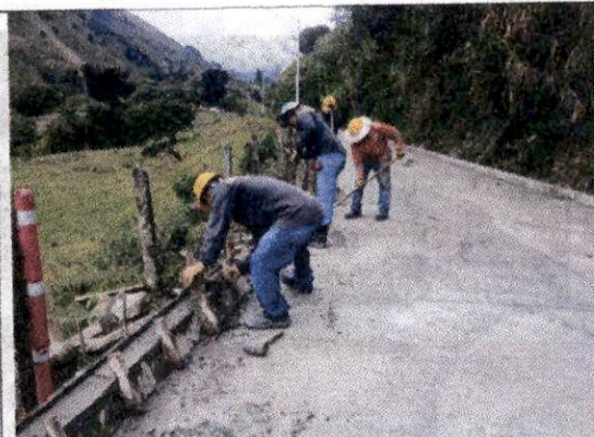
Foto 24 Vaciado de bordillo sobre la margen izquierda desde el K1+528,17 al K1+451,47, se utiliza concreto de 21 Mpa
