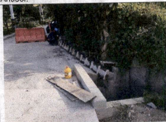
Foto 4 Construcción de bordillo 21MPa, colocación de acero, encofrado y vaciado de bordillo carril margen derecha conectando con la obra hidráulica K1+750, 5
