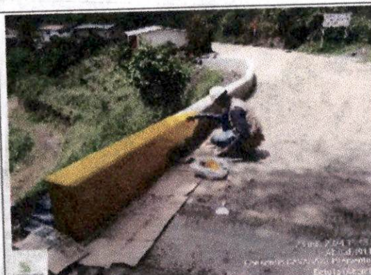
Foto 42 Señalización con pintura tipo tráfico reflectiva k0+035
