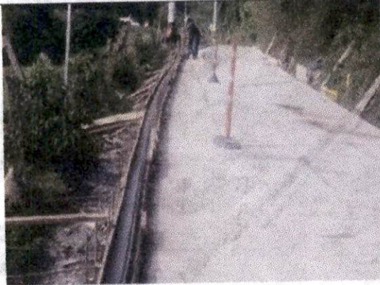
Foto 21 Vaciado de bordillo sobre la margen izquierda desde el K1+602,64 al K1+529,77, se utiliza concreto de 21 Mpa
