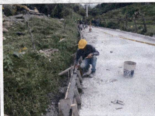
Foto 16 Vaciado de bordillo sobre la margen izquierda desde el K1+725 al K1+694,60, se utiliza concreto de 21 Mpa.
