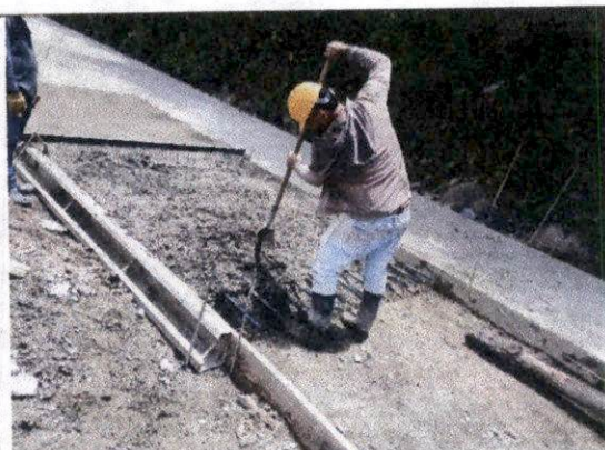
Foto 18 Construcción de pavimento en concreto hidráulico MR 38 KGF/CM2, vaciado de módulos de losas de 2.30x2.75 medio carril margen izquierda abscisa K1+507,85 hasta la K1+461.1, se aplica Antisol.
