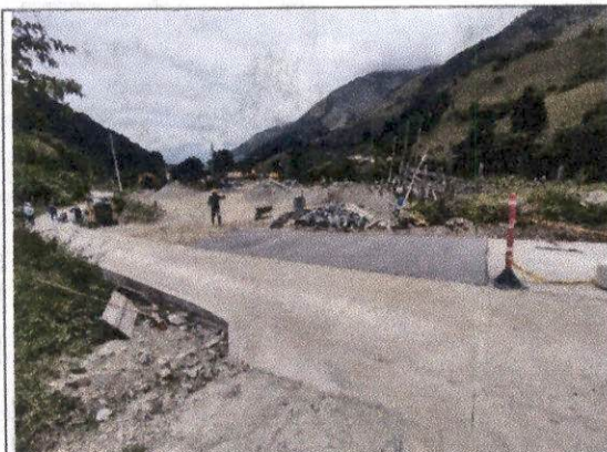
Foto 9 Construcción de pavimento en concreto hidráulico MR 38 KGF/CM2, vaciado de losas de concreto hidráulico medio carril margen izquierda abscisa K1+741,8 a K1+733,55, se aplica Antisol.
