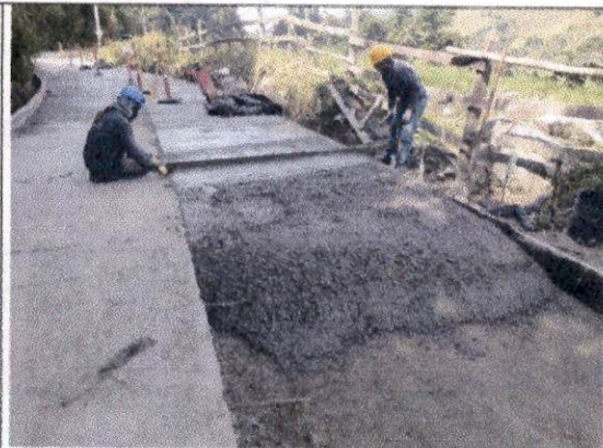
Foto 6 Construcción de pavimento en concreto hidráulico MR 38 KGF/CM2, vaciado de módulos de losas de 2.30x2.75 medio carril margen derecha abscisa K1+603,8 a K1+647,8, se aplica Antisol.
