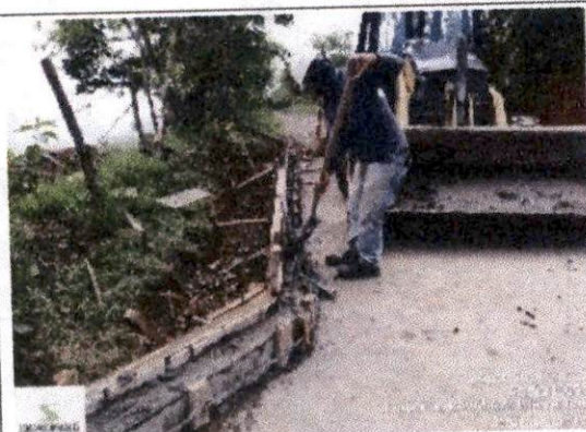
Foto 5 Fundición de bordillo k0+390.
