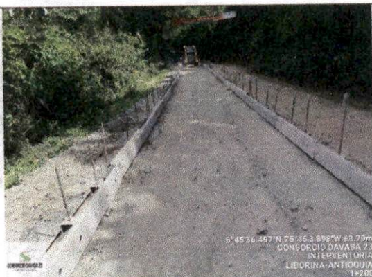
Foto 34 Construcción de pavimento en concreto hidráulico MR 38 KGF/CM2, encofrado carril margen izquierda desde el K1+226,55 al K1+200.
