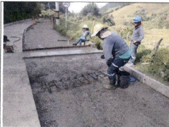
Foto 5 Construcción de pavimento en concreto hidráulico MR 38 KGF/CM2, colocación de canastilla y pasadores de 1" (12 unidades por canastilla). El diámetro de las barras es de 1" (25.4 mm) y la separación entre centros de 20 cm, medio carril margen derecha abscisa K1+603,8 a K1+647,8, se aplica Antisol.
