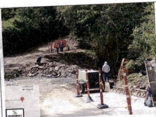
Foto 38 Obras complementarias para atender la problemática del sector de la Batea desde el K1+295 hasta el K1+270. Se Plantea la construcción de un muro de contención de la banca de 6 m de altura por 23 m de longitud con la respectiva estructura de la batea sobre la corona del muro. Complementariamente su respectiva losa de disipación.
