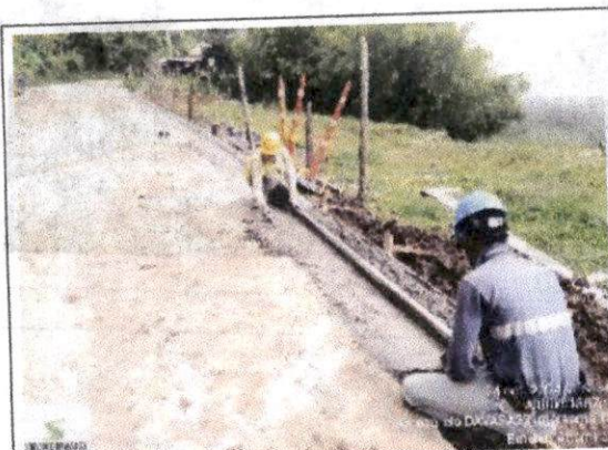
Foto 39 Construcción de cunetas k0+320
