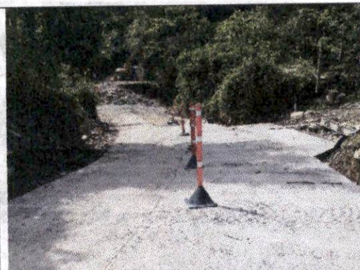
Foto 31 Construcción de pavimento en concreto hidráulico MR 38 KGF/CM2, vaciado de módulos de losas de pavimento rígido medio carril margen izquierda abscisa K1+308,10 a K1+300,62.
