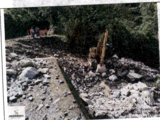
Foto 37 Obras complementarias para atender la problemática del sector de la Batea desde el K1+295 hasta el K1+270. Se realiza actividades de excavación.
