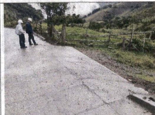
Foto 27 Construcción de pavimento en concreto hidráulico MR 38 KGF/CM2, vaciado de rampa de acceso a predio privado en concreto hidráulico, desde el K1+664,25 hasta el K1+655,40 (8,85m)
