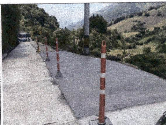
Foto 14 Construcción de pavimento en concreto hidráulico MR 38 KGF/CM2, vaciado de losas de concreto hidráulico medio carril margen izquierda abscisa K1+581,8 a K1+557,05, se aplica Antisol.
