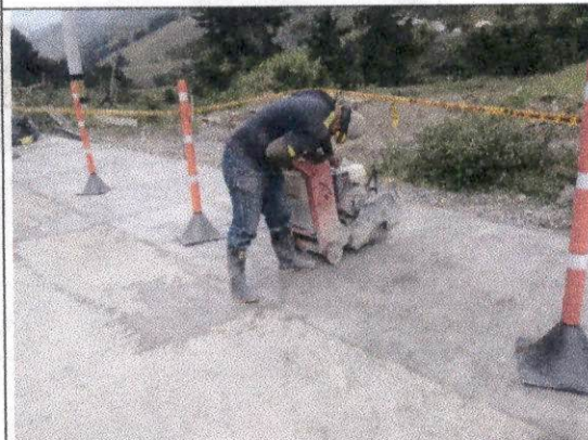
Foto 11 Construcción de pavimento en concreto hidráulico MR 38 KGF/CM2, labores de definición de juntas de dilatación con equipo de disco de corte.
