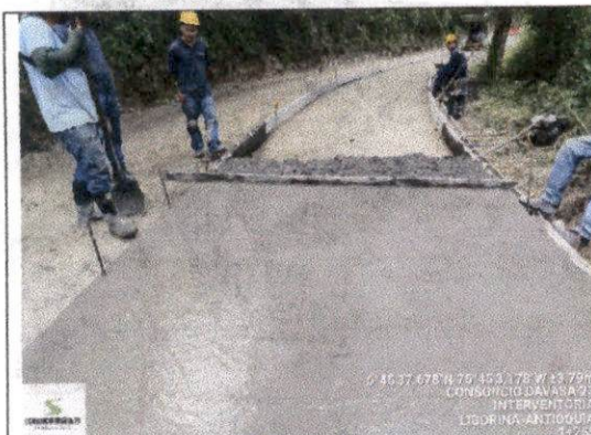
Foto 33 Construcción de pavimento en concreto hidráulico MR 38 KGF/CM2, vaciado de módulos de losas de 2.30x2.75 medio carril margen derecha abscisa K1+246,8 hasta la K1+238,20.
