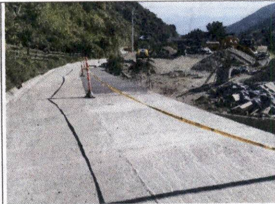
Foto 10 Construcción de pavimento en concreto hidráulico MR 38 KGF/CM2, vaciado de losas de concreto hidráulico medio carril margen izquierda abscisa K1+733,55 a K1+713,55, se aplica Antisol.
