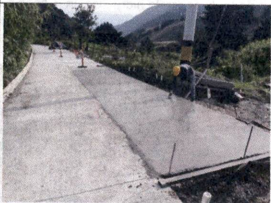
Foto 7 Construcción de pavimento en concreto hidráulico MR 38 KGF/CM2, vaciado de módulos de losas de 2.30x2.75 medio carril margen derecha abscisa K1+647,8 a K1+683,55, se aplica Antisol.
