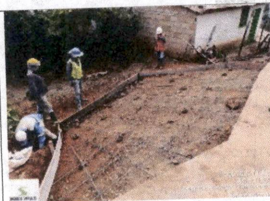
Foto 11 Conformación del terreno para fundición concreto de acceso a vía vereda k0+445
