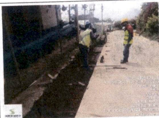
Foto 7 Conformación y nivelación de terreno para la construcción de cunetas.
