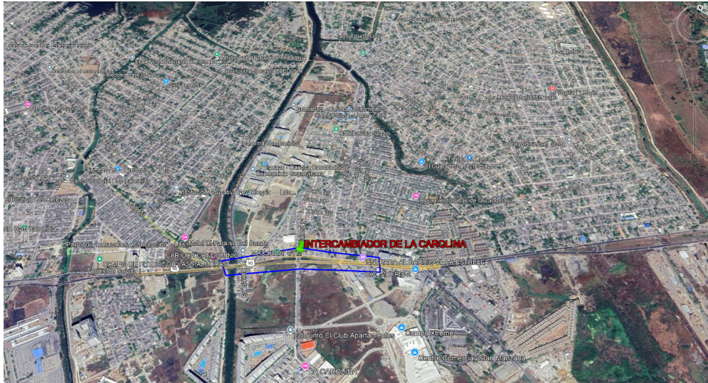
Figura 1.1. Localización de la vía
