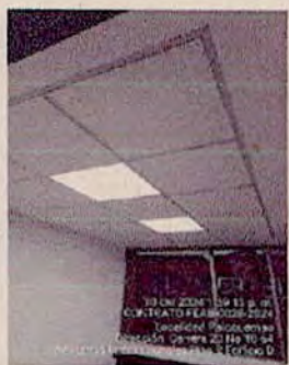
SEDE PALOQUEMAO - Estructuración e instalación de cielo raso modulado 60x60 y luminarias - OFICINA DE ASUNTOS INTERNACIONALES PISO 2 EDIFICIO D
