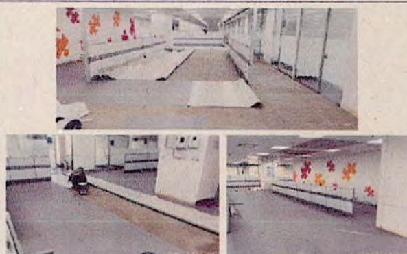
SEDE BUNKER - Se realiza actividad de aplicación de adhesivo para instalación de piso vinílico, se realiza rectificación de nivel, se realiza corte e instalación de soldadura - TERCER PISO - EDIFICIO II
