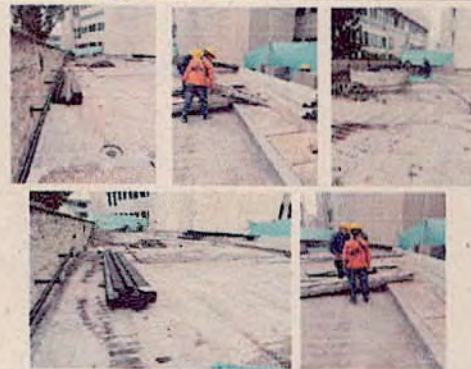
SEDE BUNKER - Se realiza actividad de trasiego de material necesario para iniciar la instalación de estructura metálica para el piso deck, se realiza actividad de aplicación de anticorrosivo en los perfiles metálicos - PISO DECK - PLAZOLETA PRINCIPAL
