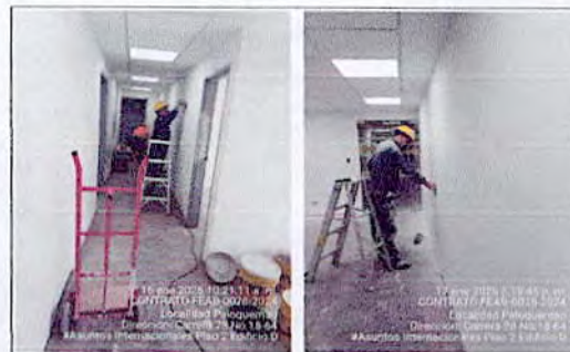
SEDE PALOQUEMAO - Resacas, estuco y pintura de muros - OFICINA DE ASUNTOS INTERNACIONALES PISO 2 EDIFICIO D
