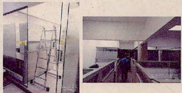
SEDE BUNKER - Se finaliza actividad de instalación de divisores en vidrio, pintura de muros, acabado de cenefas, queda pendiente para entrega la instalación del sanitising de la puerta de acceso - SOTANO - EDIFICIO T
