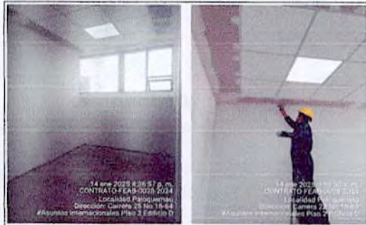
SEDE PALOQUEMAO - Ujado y pintura de cenefes - OFICINA DE ASUNTOS INTERNACIONALES PISO 2 EDIFICIO D
