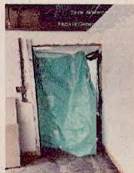
SEDE PALOQUEMAO - Desmonte de puerta metálica de acceso y resane de vano - OFICINA DE ASUNTOS INTERNACIONALES PISO 2 EDIFICIO D
