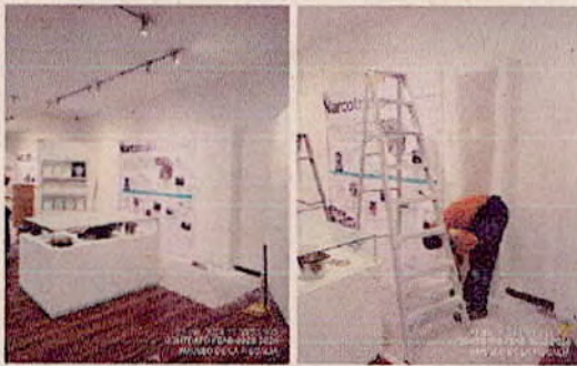
SEDE INURBE - Se finaliza actividad de construcción de muro de información, muro zona NARCOTRAFICO - MUSEO DE LA FISCALIA
