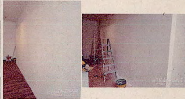
SEDE INURBE - Se finaliza actividad de construcción de muro de información, muro zona NARCOTRAFICO - MUSEO DE LA FISCALIA
