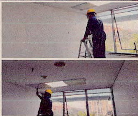
SEDE BUNKER - Se adelantan actividades de pintura de muros internos y bajo placa al interior de los despachos de la zona del tercer piso - TERCER PISO - EDIFICIO II
