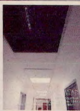
SEDE PALOQUEMAO - Estructuración e instalación de cielo raso modulado 60x60 y luminarias - OFICINA DE ASUNTOS INTERNACIONALES PISO 2 EDIFICIO D
