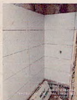
SEDE PALOQUEMAO -Enchape de muros en duchas mujeres - GIMNASIO PISO 2 1/2
