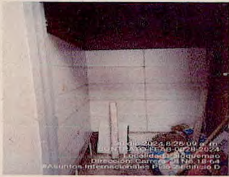
SEDE PALOQUEMAO - Enchape de muros en baño- OFICINA DE ASUNTOS INTERNACIONALES PISO 2 EDIFICIO D
