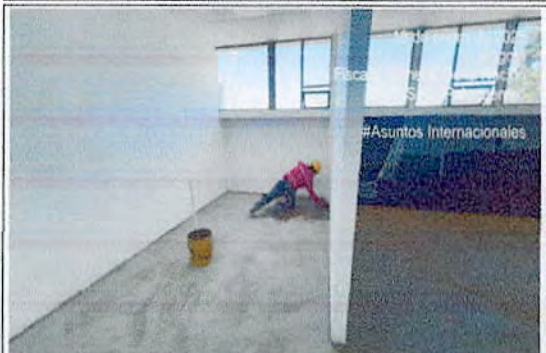
SEDE PALOQUEMAO - Aplicación de mortero para piso vinílico - OFICINA DE ASUNTOS INTERNACIONALES PISO 2 EDIFICIO D
