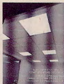
SEDE PALOQUEMAO - Estructuración e instalación de cielo raso modulado 60x60 y luminarias - OFICINA DE ASUNTOS INTERNACIONALES PISO 2 EDIFICIO D
