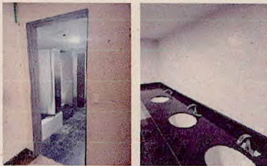
SEDE PALOQUEMAO - Pendiente instalación de puerta de madera con chapa y espejo y cseo - BAÑO SERVIDORES CELDAS PISO 3
