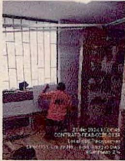
SEDE PALOQUEMAO -Resane de reglas realizadas para instalación de tuberías hidráulicas y eléctricas e instalación de enchape de muros en duchas hombres - GIMNASIO PISO 2 1/2
