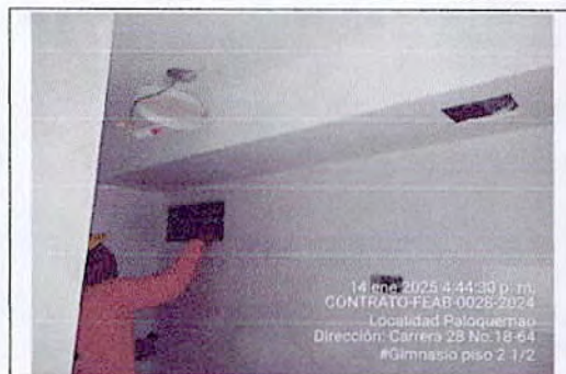
SEDE PALOQUEMAO - Pintura de rejilla e instalación de cielo raso drywall en cuarto de baño en duchas mujeres - GIMNASIO PISO 2 1/2
