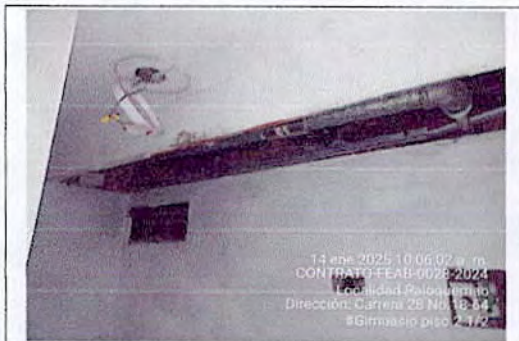
SEDE PALOQUEMAO - Desmonte de cielo raso y luminaria redonda en cuarto de baño en duchas mujeres - GIMNASIO PISO 2 1/2
