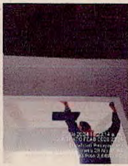
SEDE PALOQUEMAO - Instalación de cielo raso modular de 40x60 y tomas para luminarias - OFICINA DE ASUNTOS INTERNACIONALES PISO 2 EDIFICIO D
