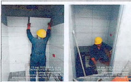
SEDE PALOQUEMAO - Instalación de enchape de muros y piso en baño - OFICINA DE ASUNTOS INTERNACIONALES PISO 2 EDIFICIO D
