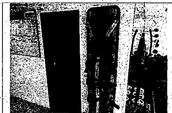
SEDE PALOQUEMAO - Pendiente instalación de puerta de madera con chapa en baño de hombres - GIMNASIO PISO 2 I/2
