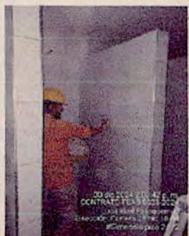
SEDE PALOQUEMAO -Enboquillado de enchape de muros y pintura de muros en duchas hombres - GIMNASIO PISO 2 1/2
