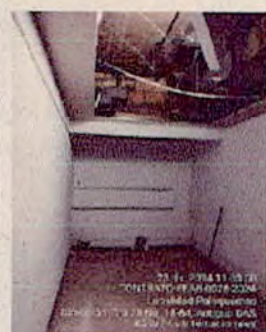
SEDE PALOQUEMAO - Construcción de cenefas e instalación de tomas para luminarias - OFICINA DE ASUNTOS INTERNACIONALES PISO 2 EDIFICIO D
