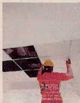
SEDE PALOQUEMAO - Estructuración e instalación de cielo raso modulado 60x60 y luminarias - OFICINA DE ASUNTOS INTERNACIONALES PISO 2 EDIFICIO D
