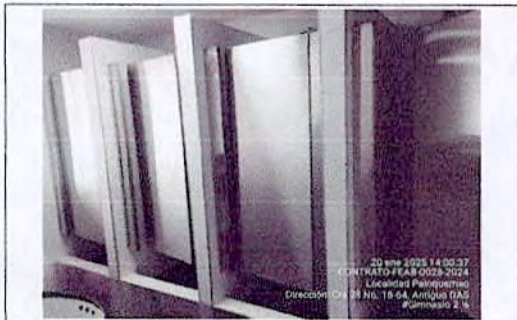
SEDE PALOQUEMAO -Instalación de puertas de acero inoxidable en duchas hombres - GIMNASIO PISO 2 1/2
