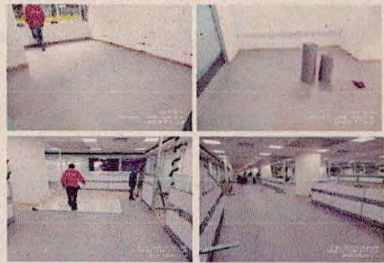
SEDE BUNKER - Se realiza actividad de aplicación de adhesivo para instalación de piso vinílico, se realiza rectificación de niveles, se realiza corte e instalación de tabladura - TERCER PISO - EDIFICIO H
