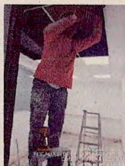
SEDE PALOQUEMAO - Estructuración e instalación de cielo raso modulado 60x60 y luminarias - OFICINA DE ASUNTOS INTERNACIONALES PISO 2 EDIFICIO D
