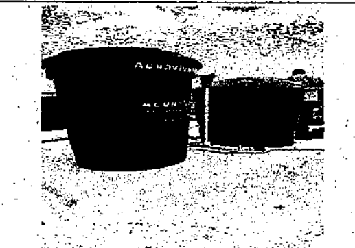
SEDE LA SOLEDAD AK28 - Instalación de tanques de agua potable y conexión de tuberías - PLACA DE CUBIERTA
