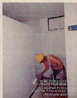
SEDE PALOQUEMAO -Enboquillado de enchape de muros y pintura de muros en duchas hombres - GIMNASIO PISO 2 1/2
