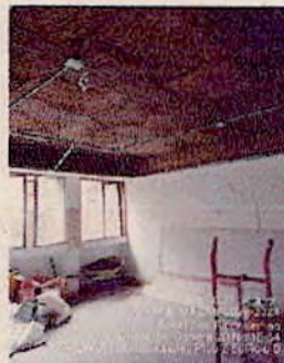
SEDE PALOQUEMAO - Construcción de cenefas e instalación de fomas para luminarias - OFICINA DE ASUNTOS INTERNACIONALES PISO 2 EDIFICIO D
