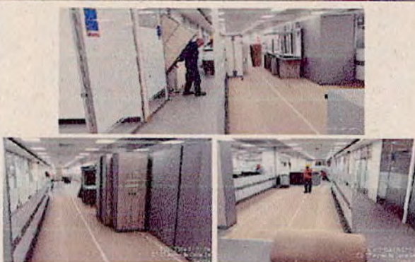
SEDE BUNKER - Se realiza actividad de movimiento de mobiliario hasta punto de acopio - TERCER PISO - EDIFICIO II
