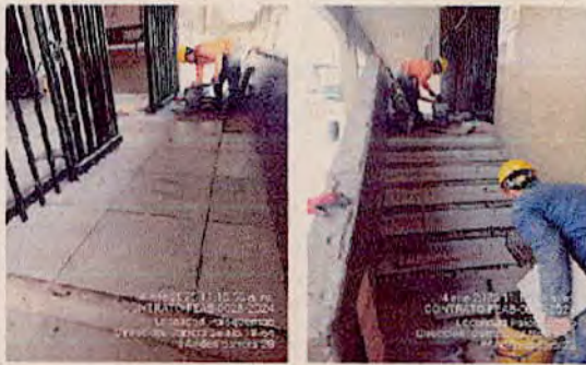
SEDE PALOQUEMAO - Instalación de cerámica en acceso ala norte, pendiente construcción nariz con gravilla lavada en escalera acceso ala norte - ANDÉN OCCIDENTAL CARRERA 28
