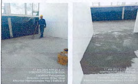
SEDE PALOQUEMAO - Raspado y nivelación de piso con pegador - OFICINA DE ASUNTOS INTERNACIONALES PISO 2 EDIFICIO D
