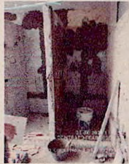
SEDE PALOQUEMAO -Resane de reglas realizadas para instalación de tuberías hidráulicas y eléctricas e instalación de enchape de muros en duchas hombres - GIMNASIO PISO 2 1/2
