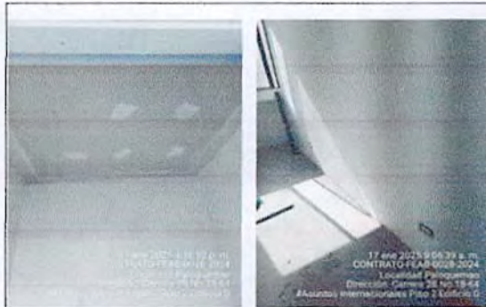
SEDE PALOQUEMAO - Instalación de cielo raso en baño e instalación de tomas eléctricas - OFICINA DE ASUNTOS INTERNACIONALES PISO 2 EDIFICIO D
