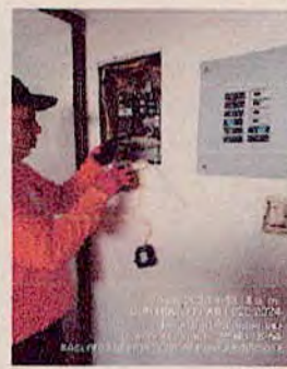
SEDE PALOQUEMAO - Instalación de breakers en caja eléctrica existente y tomas para luminarias - OFICINA DE ASUNTOS INTERNACIONALES PISO 2 EDIFICIO D
