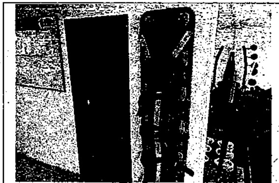
SEDE PALOQUEMAO - Pendiente instalación de puerta de madera con chapa en baño de hombres - GIMNASIO PISO 2 1/2
