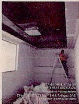
SEDE PALOQUEMAO - Construcción de cenefas e instalación de tomas para luminarias - OFICINA DE ASUNTOS INTERNACIONALES PISO 2 EDIFICIO D
