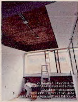
SEDE PALOQUEMAO - Construcción de cenefas e instalación de tomas para luminarias - OFICINA DE ASUNTOS INTERNACIONALES PISO 2 EDIFICIO D
