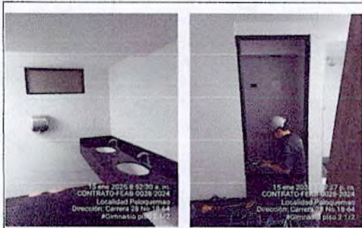
SEDE PALOQUEMAO - Instalación de enchufes eléctricos y marco metálico para puerta de cuarto de baño en duchas mujeres - GIMNASIO PISO 2 1/2
