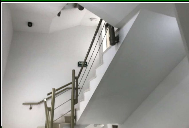
ÁREAS COMUNES - ESCALERA DE EMERGENCIA
