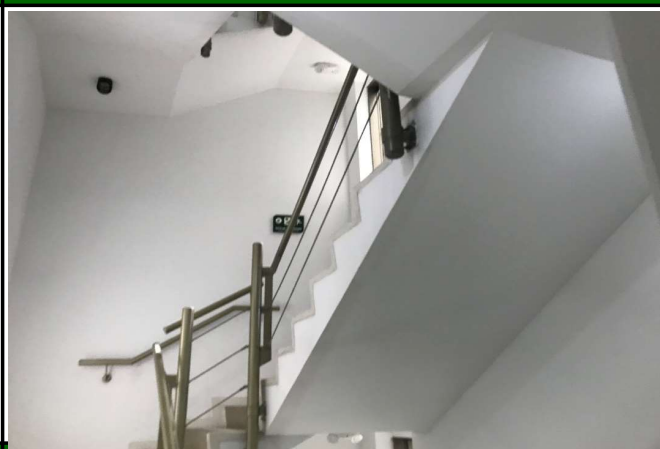
ÁREAS COMUNES - ESCALERA DE EMERGENCIA
