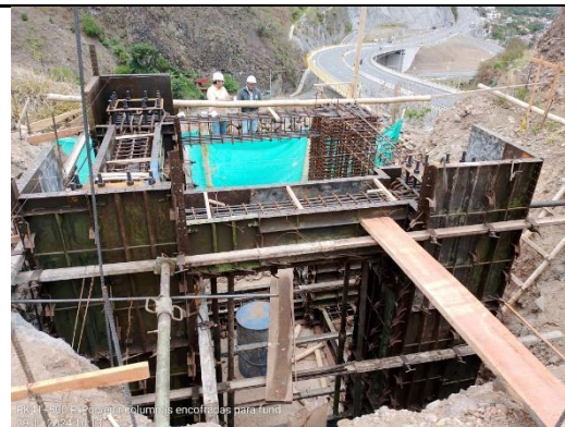
Fotografía 4-45 PR41+500 E1 Puente Peatonal El Porvenir.
