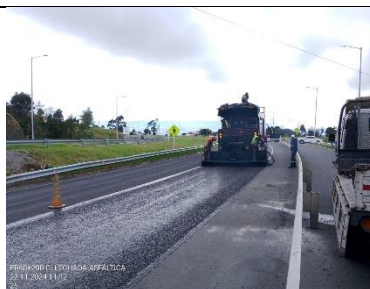
Fotografía 4-37 PR68+200. Corrección de indicador de textura con lechada asfáltica.
