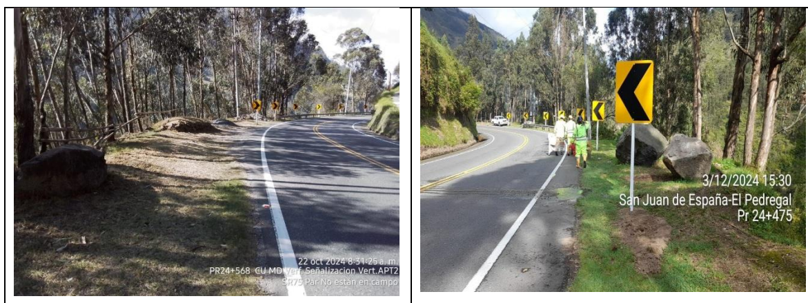
Fotografía 4-76 PR24+475 CU-MD. Reposición de señales para cumplimiento del Nivel de Servicio.
