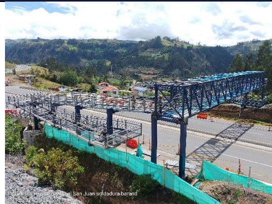
Fotografía 4-43 PR18+060 Peatonal San Juan
