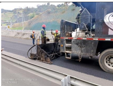
Fotografía 4-36 PR68+200. Corrección de indicador de textura con lechada asfáltica.
