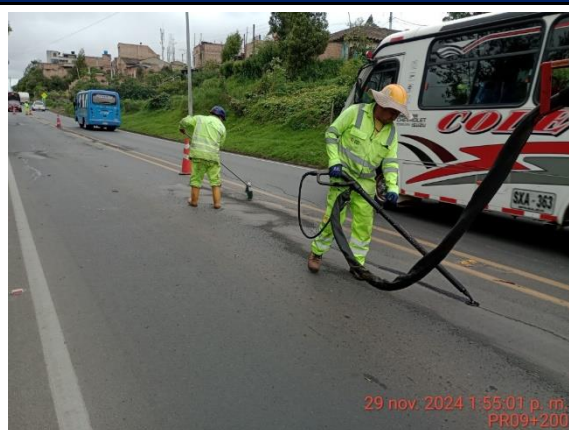
Fotografía 4-22 PR9+200 Mantenimiento y tratamiento de fisuras en pavimento.
