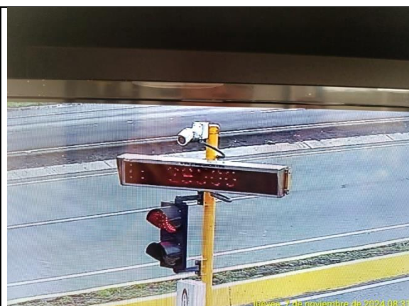
Fotografía 4-56 Registro de sobre peso en cámara de video instalada por Interventoría es estación de pesaje sector Cubijan. 02-11-2024
