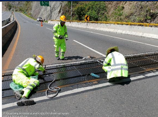
Fotografía 4-32 PR47+800 Mantenimiento en puente Guáitara.
