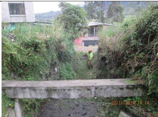
Fotografía 4-34 PR69+320 Roceria y limpieza a descoles de alcantarilla
