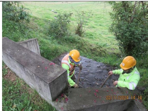
Fotografía 4-35 PR69+500 Mantenimiento y limpieza en alcantarillas
