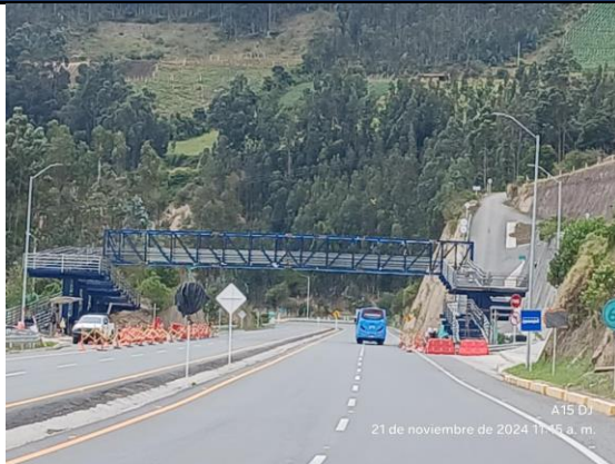
Fotografía 4-42 PR18+060 Peatonal San Juan.
