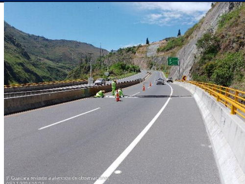
Fotografía 4-33 PR47+800 Mantenimiento en puente Guáitara.
