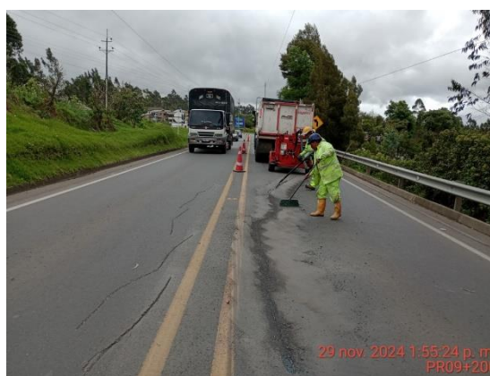
Fotografía 4-23 PR9+200 Mantenimiento y tratamiento de fisuras en pavimento.
