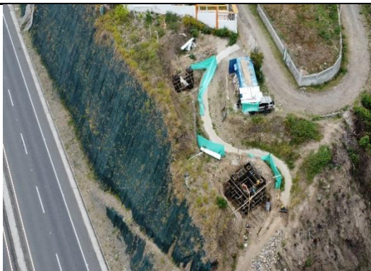
Fotografía 4-44 PR41+500 E1 Puente Peatonal Porvenir.
