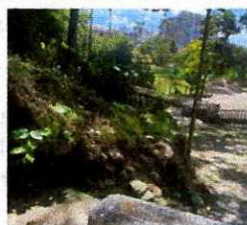
5. REPARACIÓN DE PIEDRA TIPO GAVION QUE SE ENCUENTRA EN MAL ESTADO.
