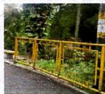
2. CAMBIO Y MEJORAMIENTO DE BARANDA METÁLICA
