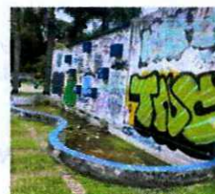
3. REHABILITACIÓN DE LA FUENTE EXISTENTE QUE SE ENCUENTRA EN LA ZONA
