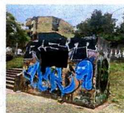
6. REPARACIÓN DE BAÑOS PARA PONERLOS EN USO Y ACTIVARLOS EN EL SECTOR.
