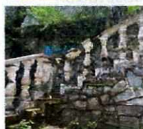
1. RECUPERACIÓN DEL BALAUSTRADO
