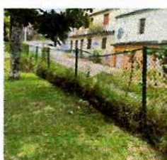
4. RETIRO TOTAL DE MALLA ESTABONADA QUE SE ENCUENTRA PERIMETRALMENTE
