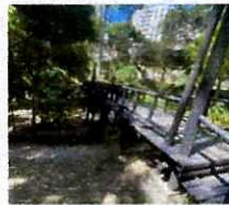
4. RESTAURACIÓN PUENTE DE MADERA
