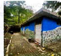
5. RECUPERACIÓN DE BAÑOS EXISTENTES
