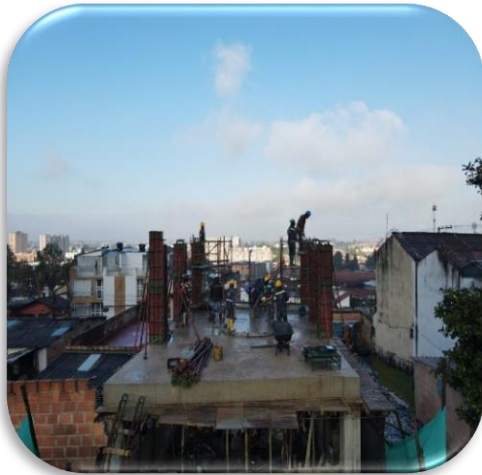
Fundida de columnas
