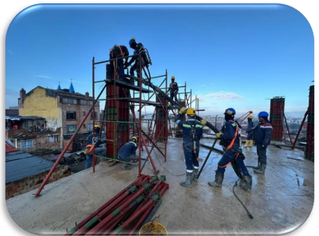
Fundida de columnas
