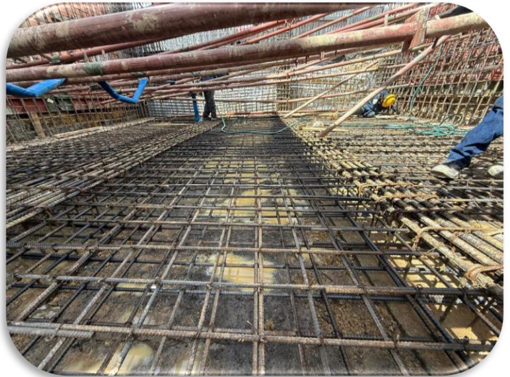
Armado de cimentación
