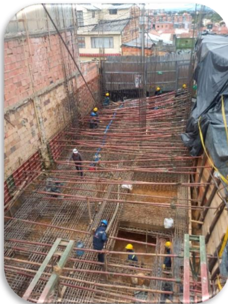
Armado de vigas de cimentación
