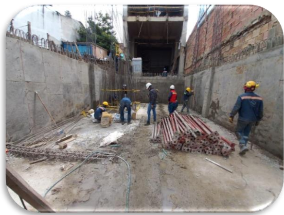
Muros y placa de sótano
