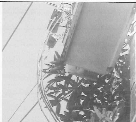
SUMINISTRO E INSTALACIÓN DE TERMINALES TIPO OJO
