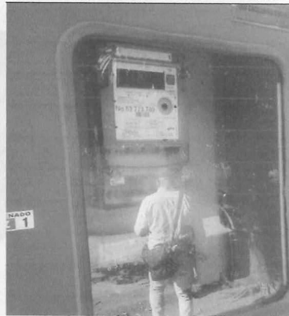
SUMINISTRO E INSTALACIÓN DE MEDIDOR TRIFASICO
