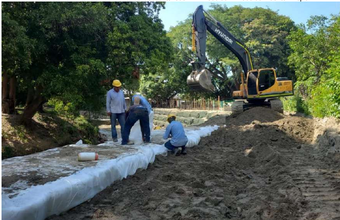
Ilustración 10. Reparación de via de Geocontendor– K2+800.00 – k2+900.00. Fuente: Propia.
