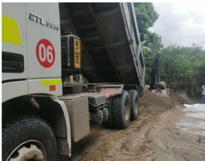
Figura 5: Cargue de material de sedimento removido
