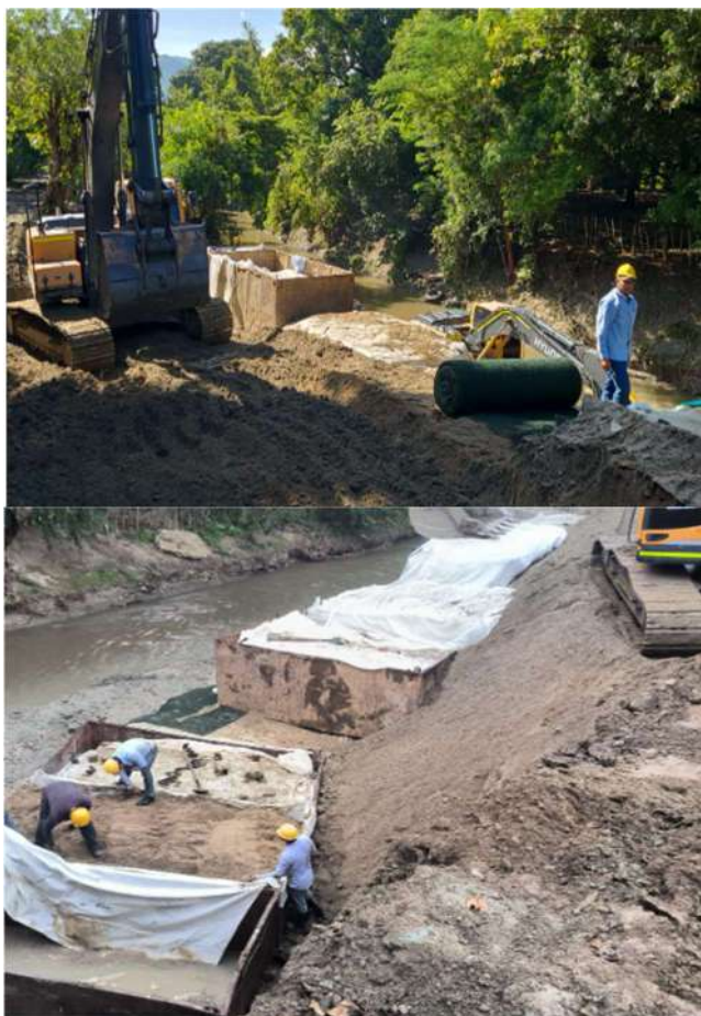
Figura 12: Construcción de geocontenedores
