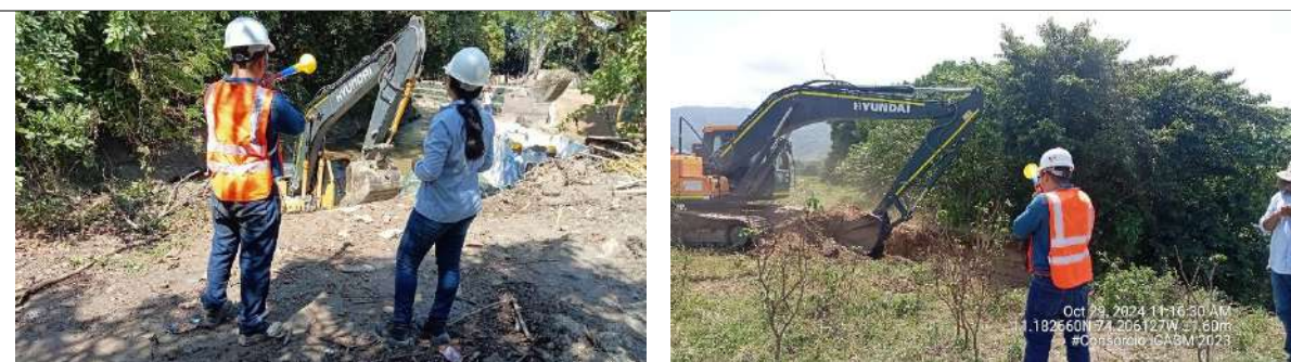
Ilustración 5. Jornada de ahuyentamiento en frente de obra de geocontenedores 1 y 2 durante el periodo octubre 2024.
