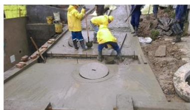
Descripción: CIV 1003043-12 Instalación de concreto MR-41 en franja central
