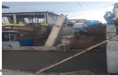
Descripción: CIV 1003043-12 Instalación de concreto de 3000 psi en espacio público
