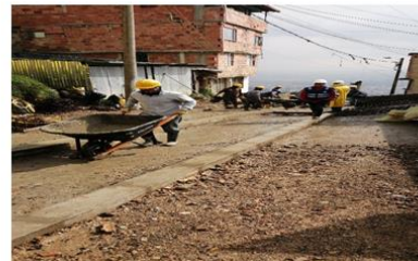
Descripción: CIV 1003043-12 Instalación de concreto MR-41 en franja central
