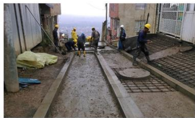
Descripción: CIV 1003043-12 Instalación de concreto MR-41 en franja central
