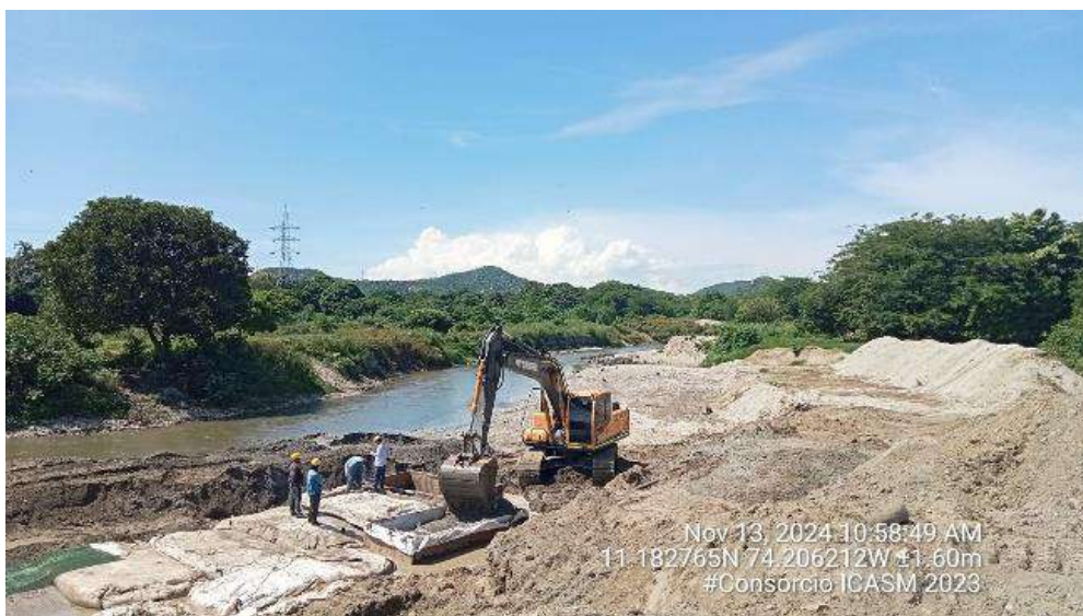
Ilustración 5. Frente de obra geocontenedores número 2. De fondo, mancha negra generada por goleros.
