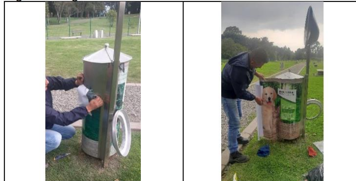
Labores de limpieza y mantenimiento tapa superior
