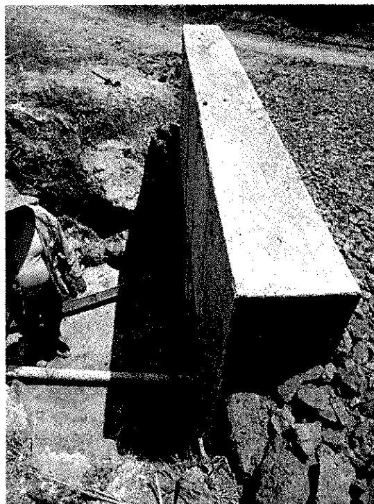
Imagen 9 - verificación de estado punto crítico 7. Grupo 1
