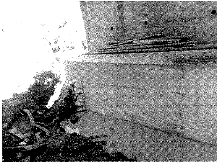
Imagen 3 - Verificación de estado punto crítico 3, Grupo 1
