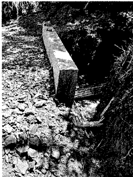
Imagen 8 - verificación de estado punto crítico 7. Grupo 1
