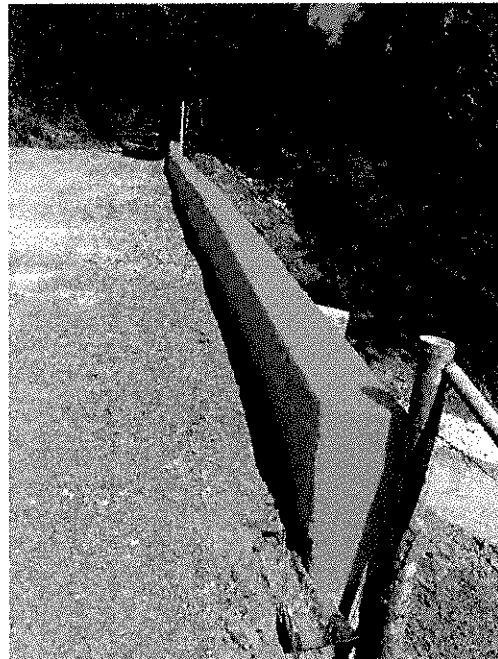
Imagen 6 - verificación de estado punto crítico 4. Grupo 1
