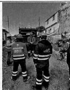
Foto No: 8 Descripción: INSTALACIÓN CAMPAMENTO EN 500MS
