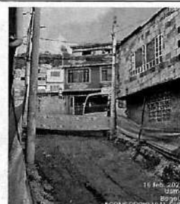
Foto No: 8 Descripción: INSTALACION CAMPAMENTO ZONA 5003408
