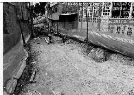
Foto No: 6 Descripción: ORDEN Y ASEO EN FRENTES DE OBRA
