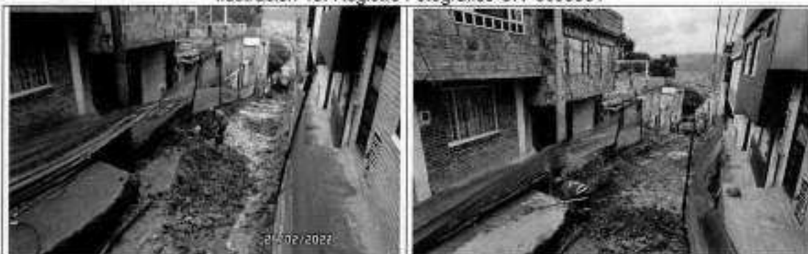
Retiro de material sobrante y ajuste de mangueras domiciliarias.
