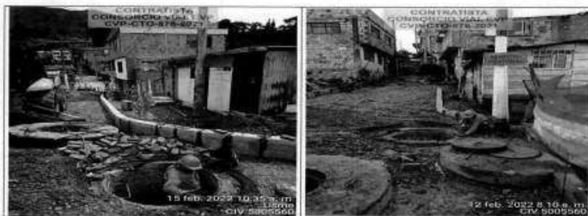
Nivelación pozos de inspección
