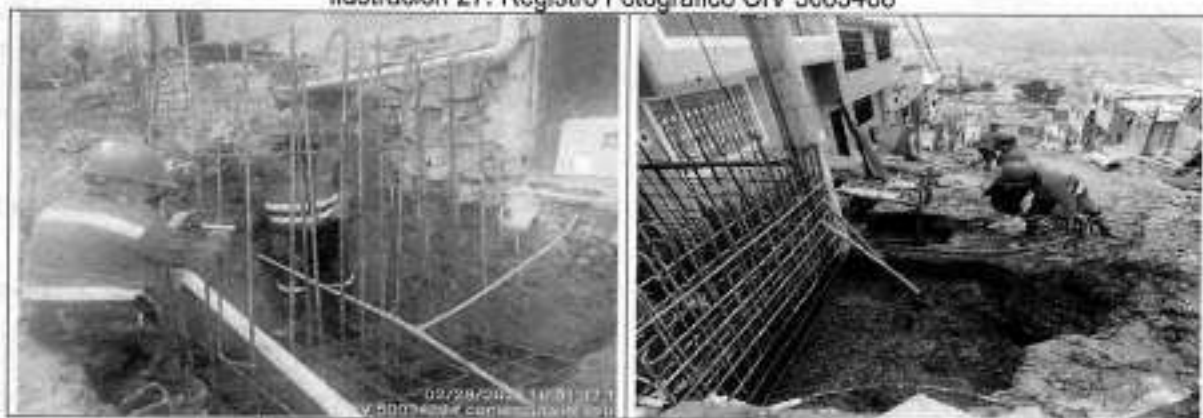
Armado y fundida de muros zarpas para muros de contención
