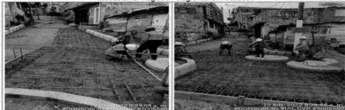
Instalación hierro de refuerzo en vía
