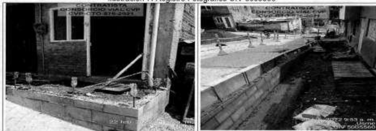
Instalación bloque estructural en arcilla
