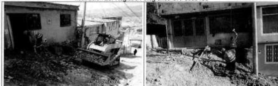
Demolición de placas en concreto
