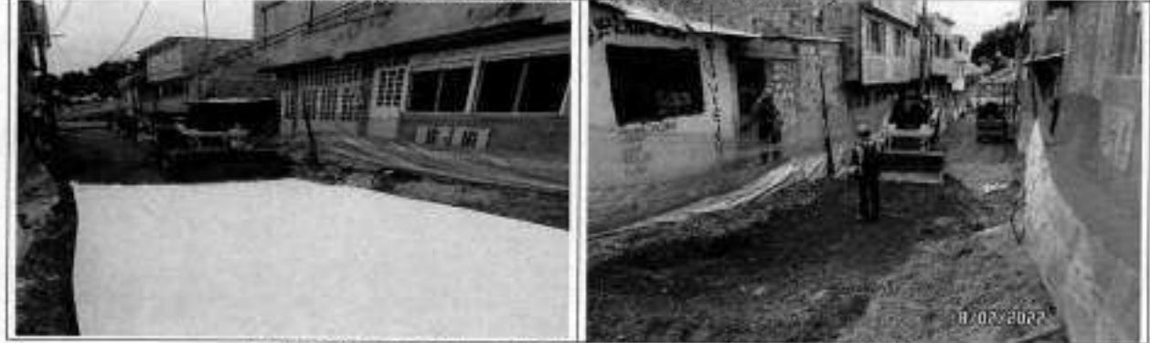
Instalación geotextil y material granular de mejoramiento RCD
