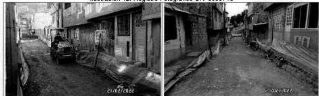
Compactación y extendido de material PA RCD
