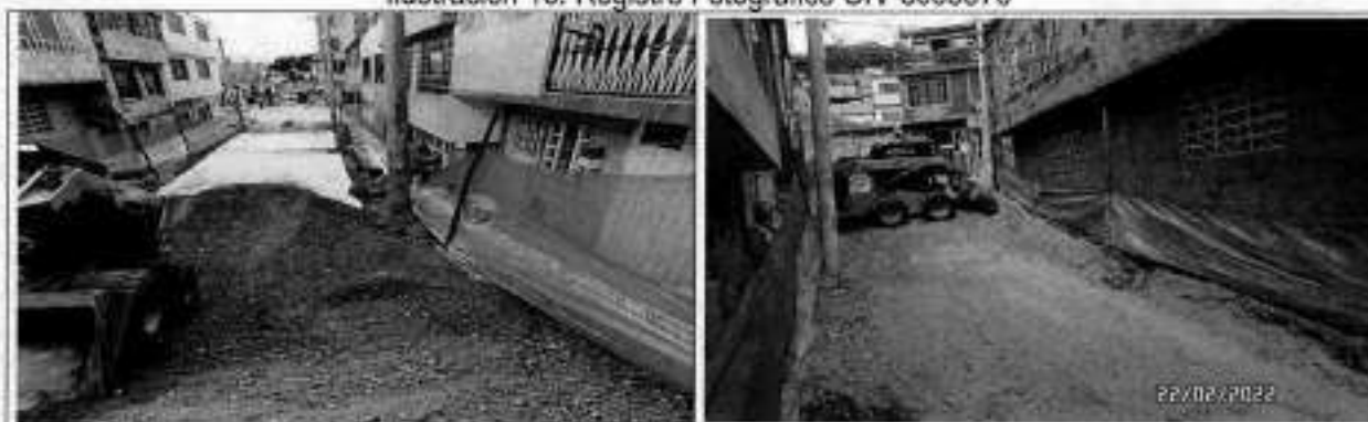
Extendido de geotextil y material tipo PA RCD
