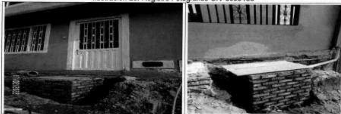
Construcción de cajas de inspección
