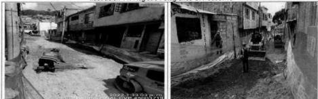
Extendido de material PA RCD
