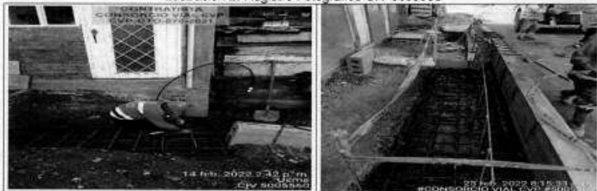
Conformación zarpas para muros
