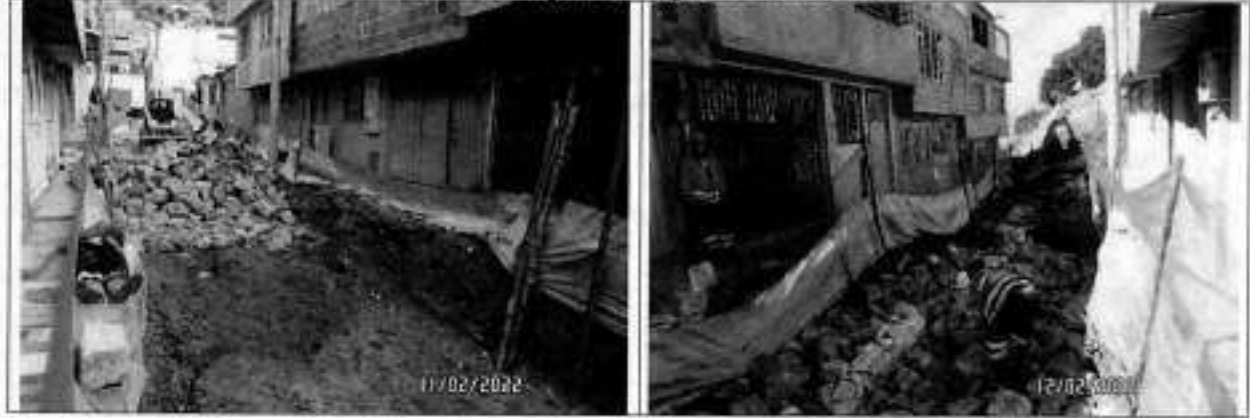
Instalación raja R-25
