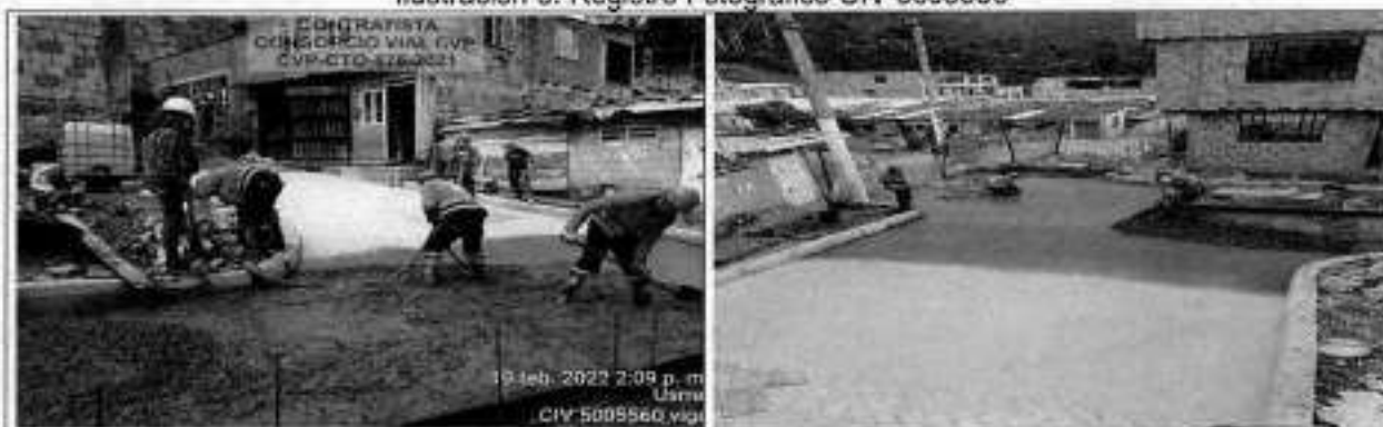
Instalación concreto tipo MR-41
