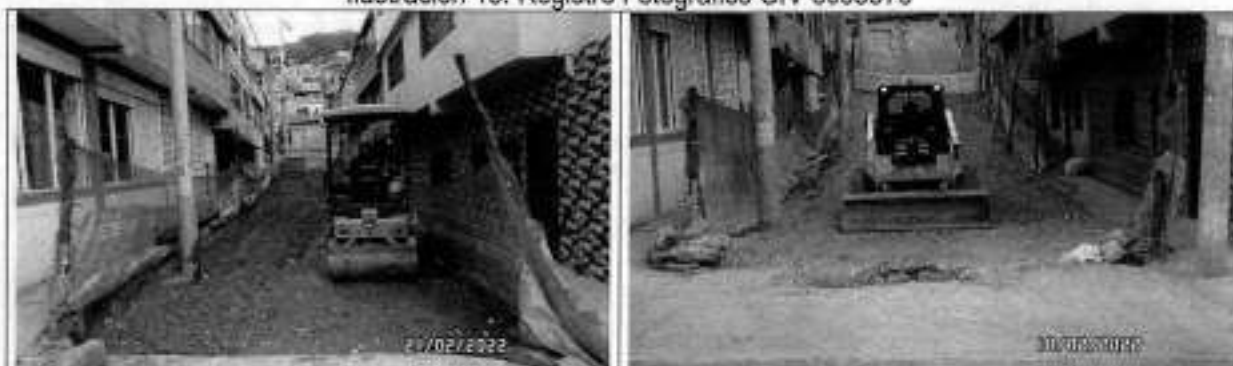
Extendido de material de mejoramiento RCD
