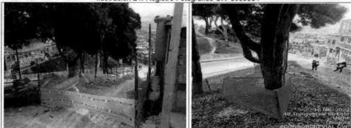
Instalación cerramiento y protección de árboles.
