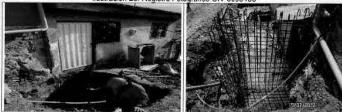
Conformación de zarpas y muros de contención
