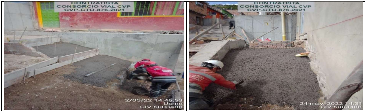
Extendido de concrete de solados
