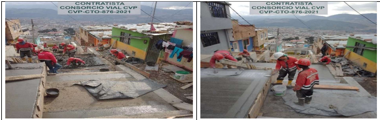
Instalación concreto de 3000 psi en escaleras
