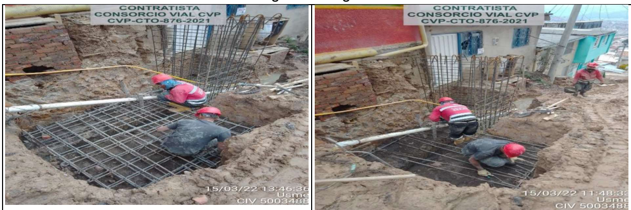
Figurado y armado de hierro para las zarpas de los muros
