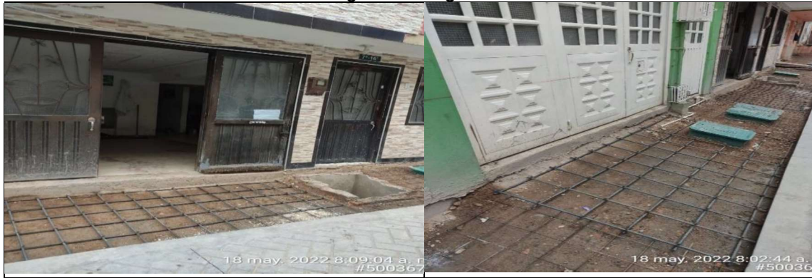
Ilustración 18. Registro Fotográfico CIV 5003670
