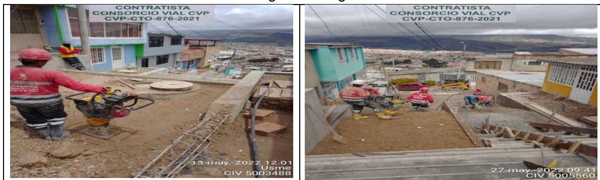
Relleno de subbase pea y compactación en la zona de los descansos de las escaleras
