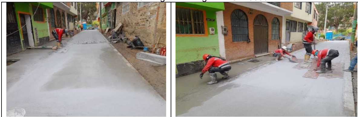
Instalación concreto MR-41 en calzada
