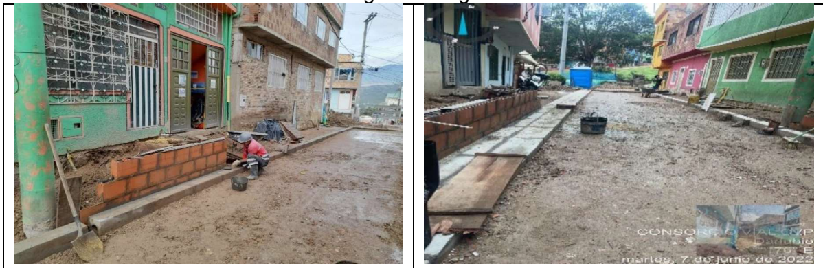
Construcción de muro en bloque estructural en arcilla y llenado de las dovelas de los muros con grouting.
