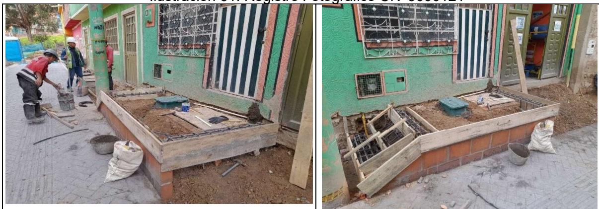
Conformación de escaleras de acceso
