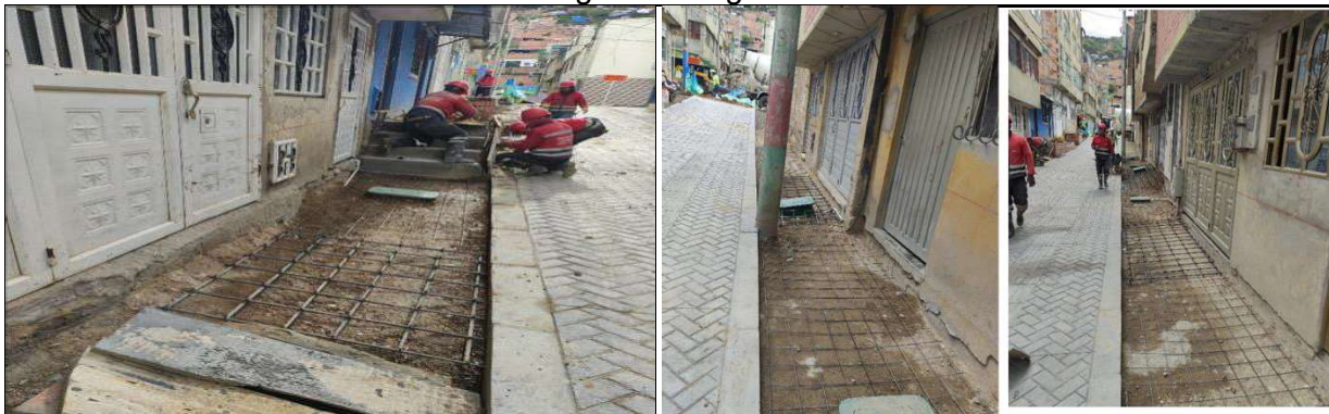
Instalación acero de refuerzo en andenes
