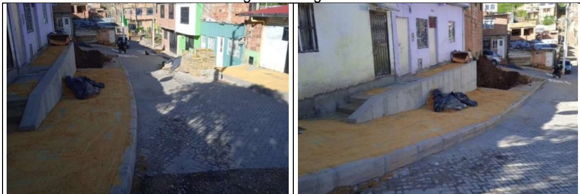
Sellado de andenes con arena
