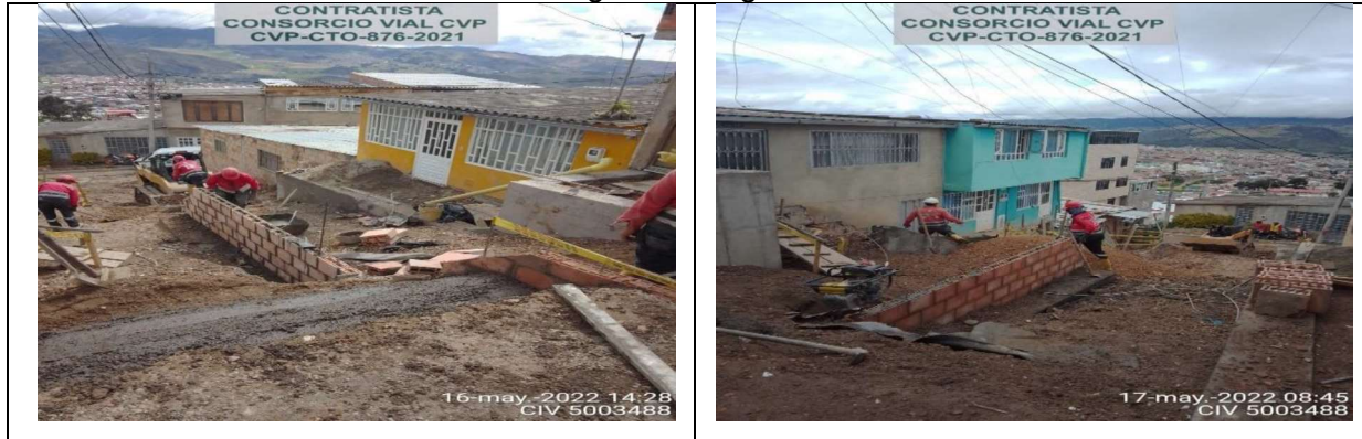
Construcción de muro en bloque estructurales en arcilla
