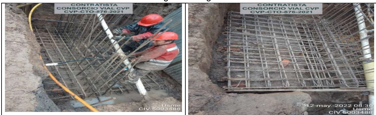
Figurado y armado de hierro para las zarpas de los muros
