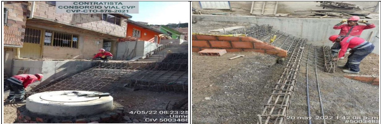
Armado de acero en escaleras y vigas
