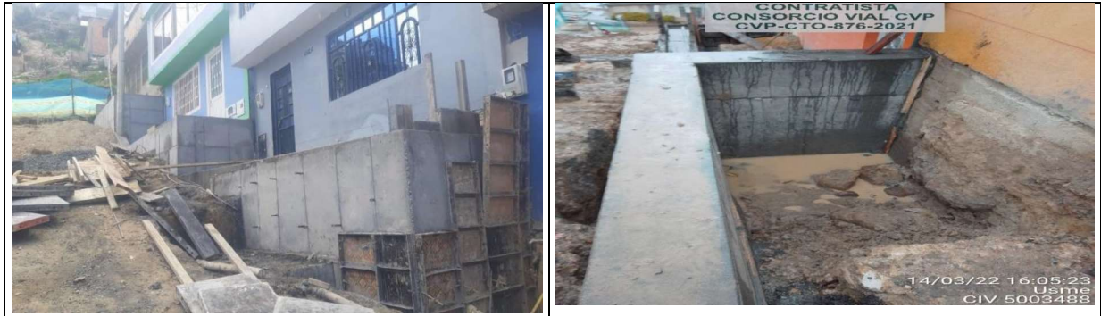
Fundida de concreto de 3000 psi muros
