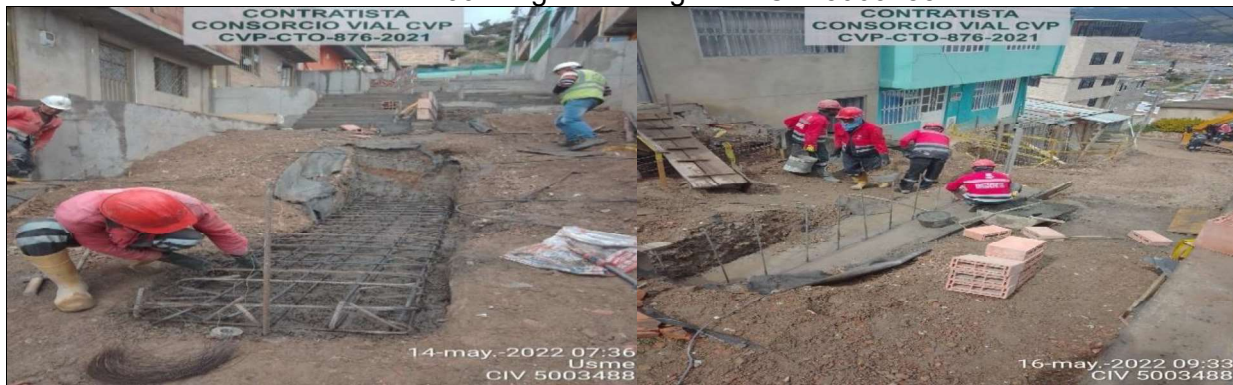
Armado de zarpas para muro central
