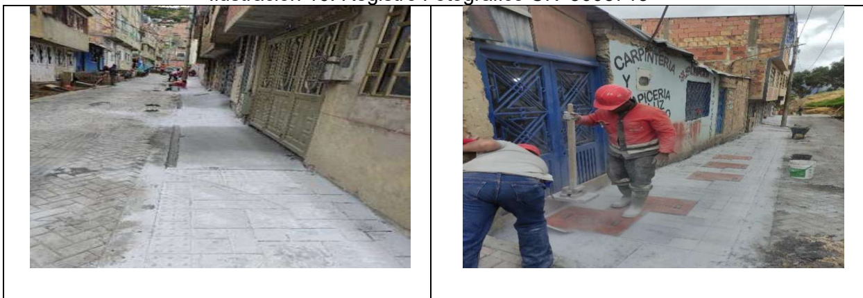
Instalación concreto MR-41 en andenes
