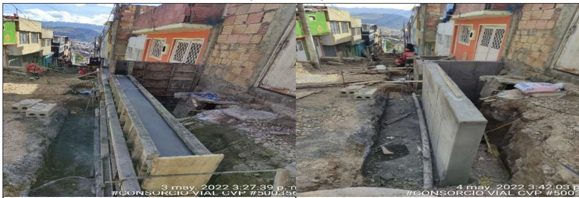
Instalación concreto de 3000 psi para muro
