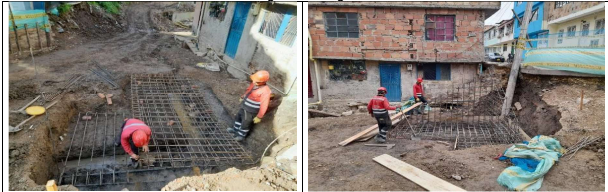
Figurado y armado de acero para muros
