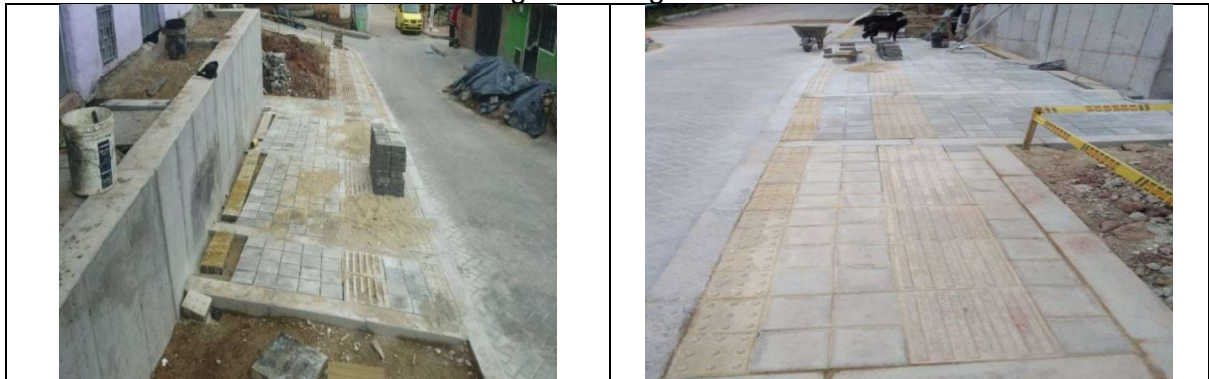
conformación de andenes e instalación de losetas prefabricadas
