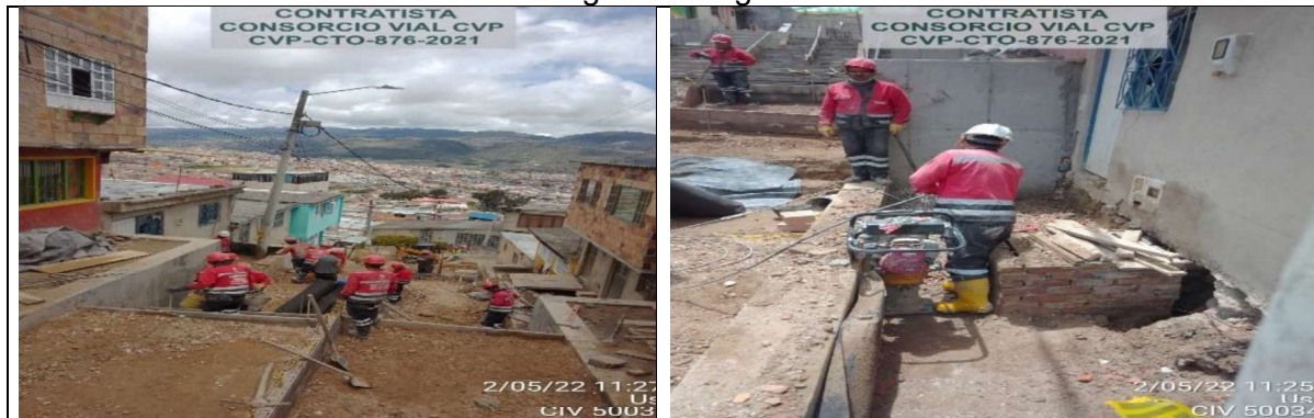
Compactación de subbase tipo PEA
