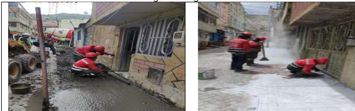
Instalación concreto MR-41 en andenes
