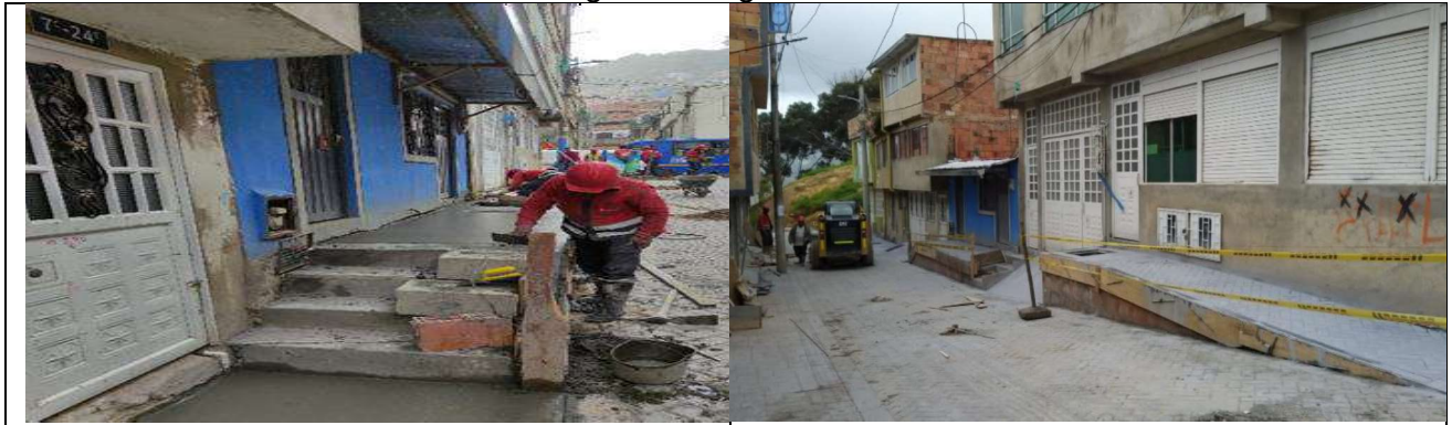
Conformación de escaleras y rampas de acceso principal
