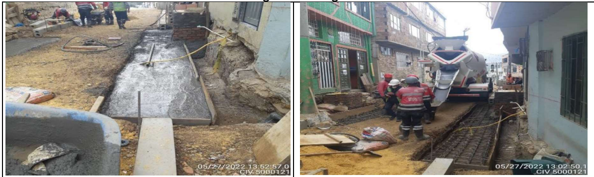
Armado de acero y fundida concreto de 3000 para zarpas
