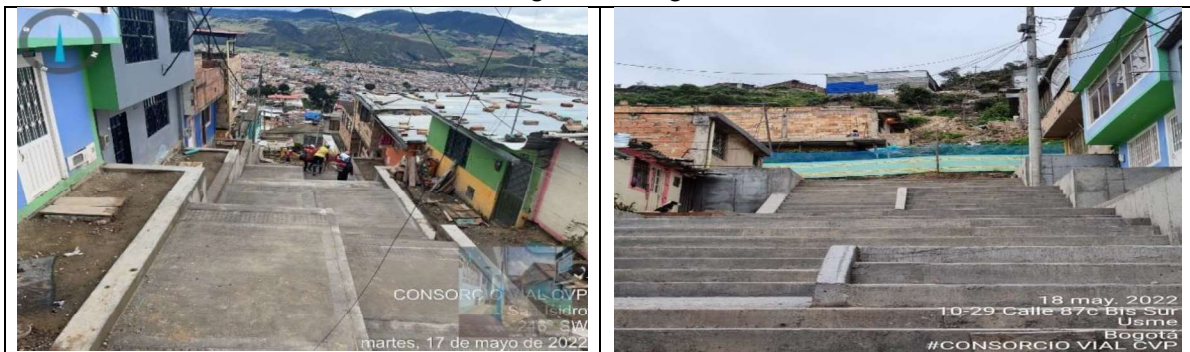
Vista general avance de obras
