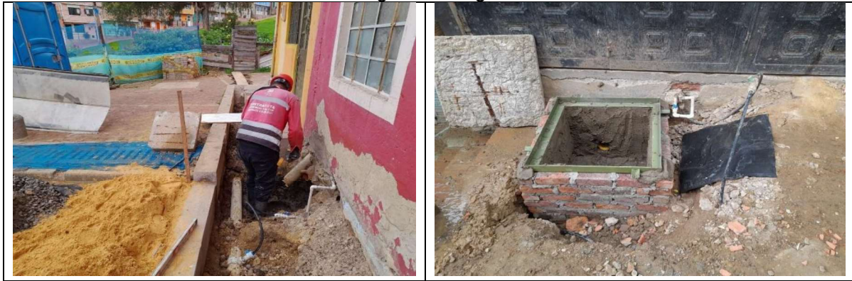
Construcción cajas de inspección
