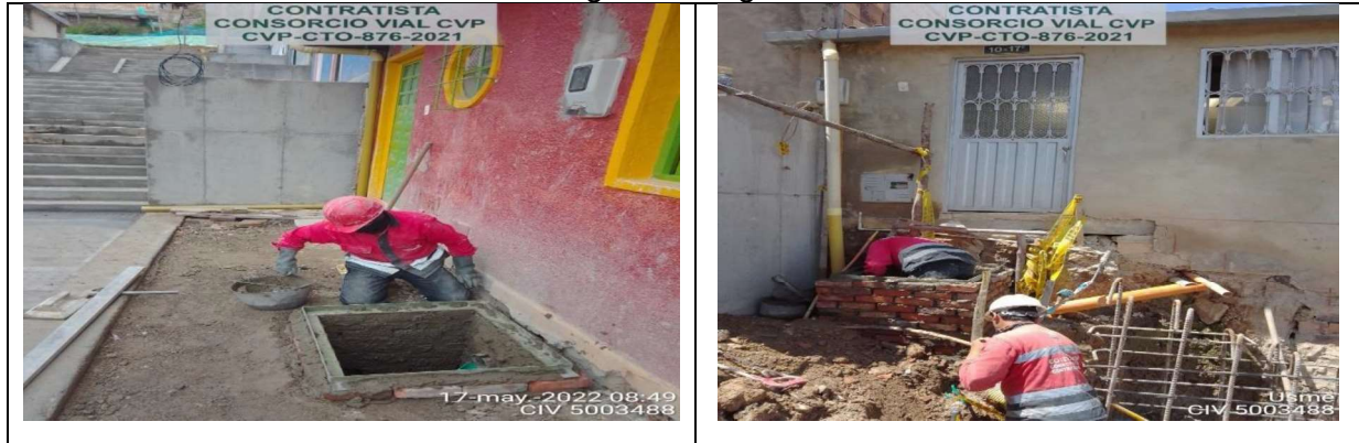
Construcción cajas de inspección
