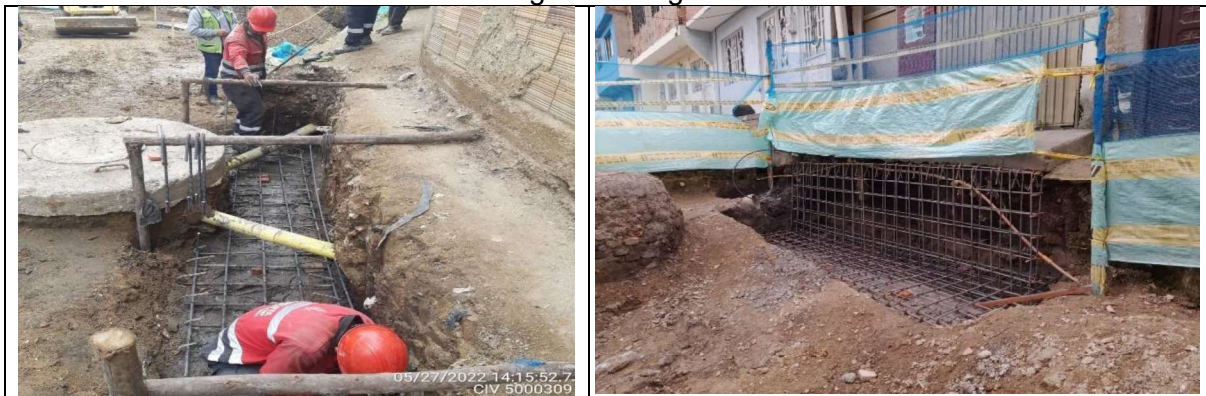
Figurado y armado de aceros para muros
