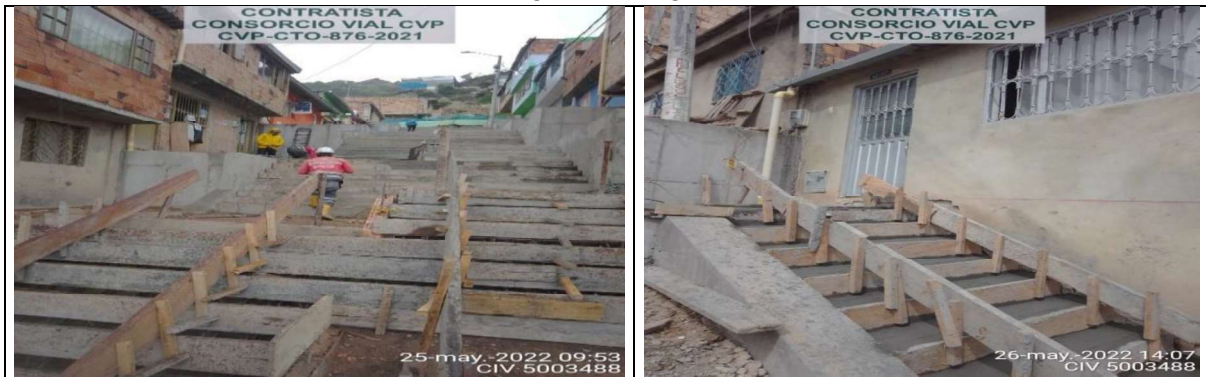
Conformación de escaleras
