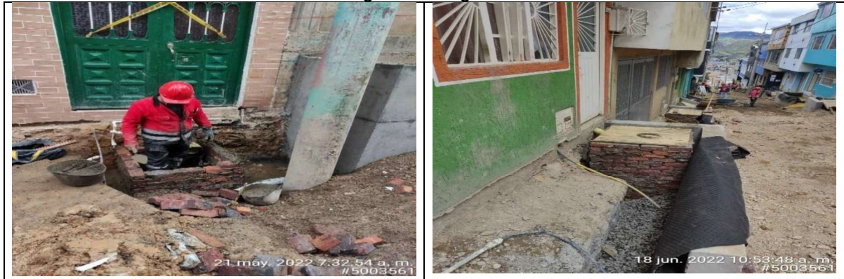
Construcción de cajas de inspección
