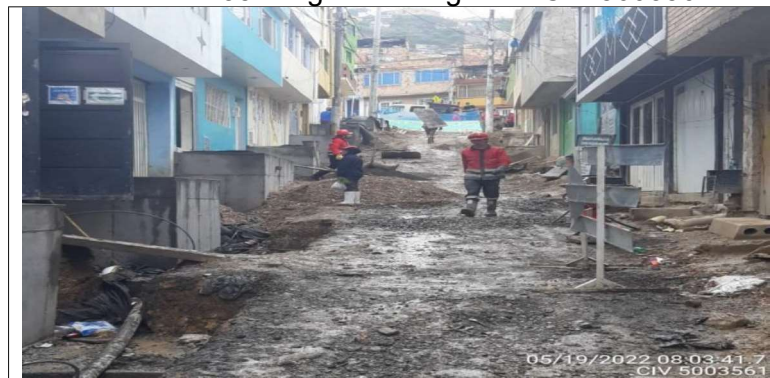
Vista general de avance
