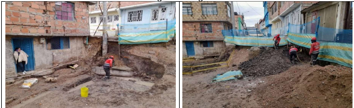
Excavaciones para conformación muros T-2 y T-1
