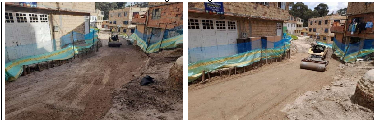
Extendido y compactación de material de mejoramiento
