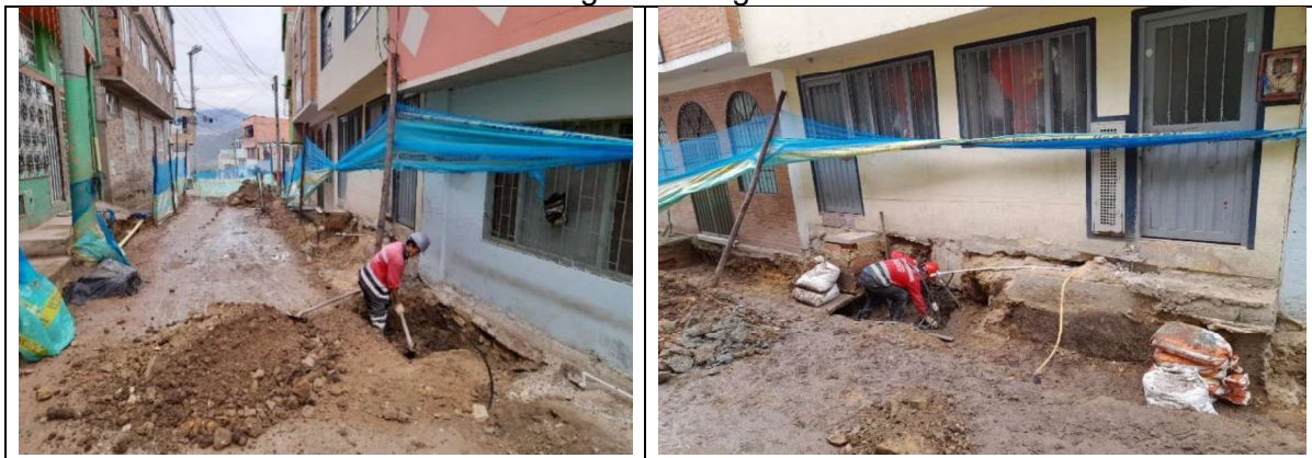
Excavaciones en zona de andenes
