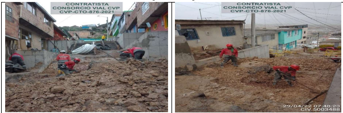
Excavaciones manuales en parte baja del segmento
