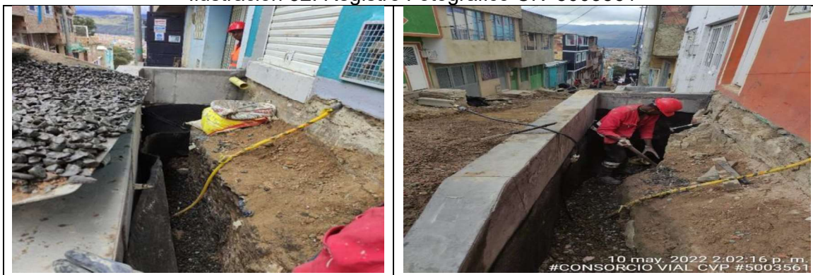
Instalacion de geodren
