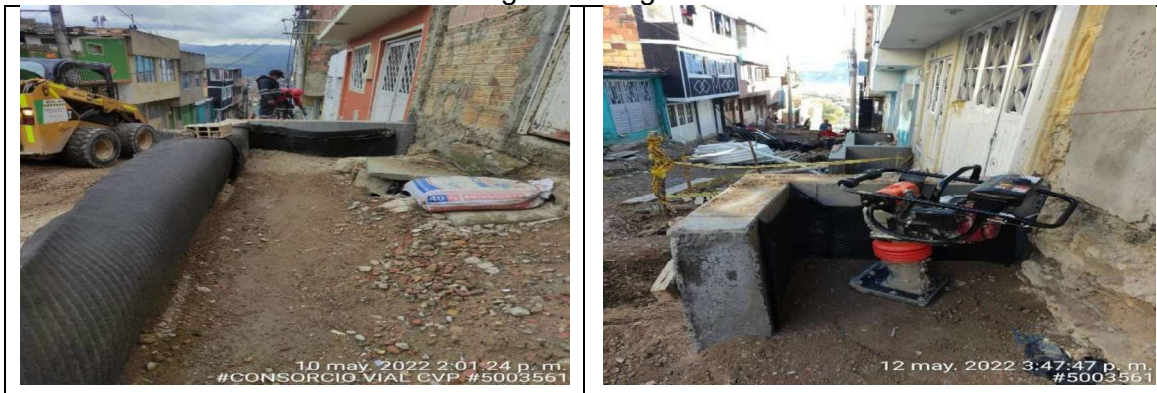
Compactación de material granular
