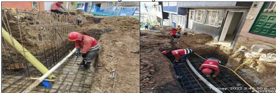
Armado de acero para las zarpas en muros
