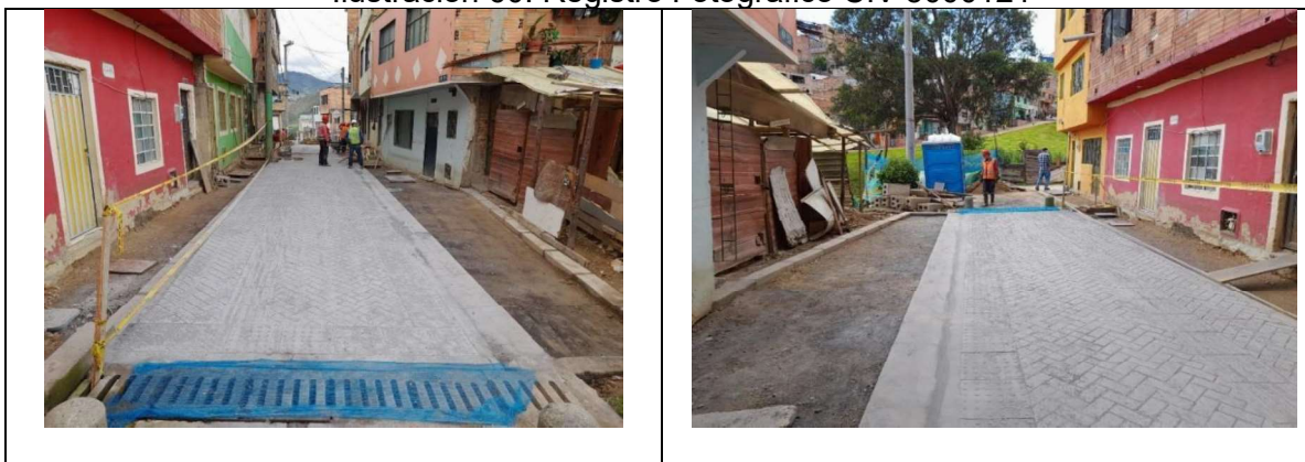
Instalación concreto MR-41 en calzada
