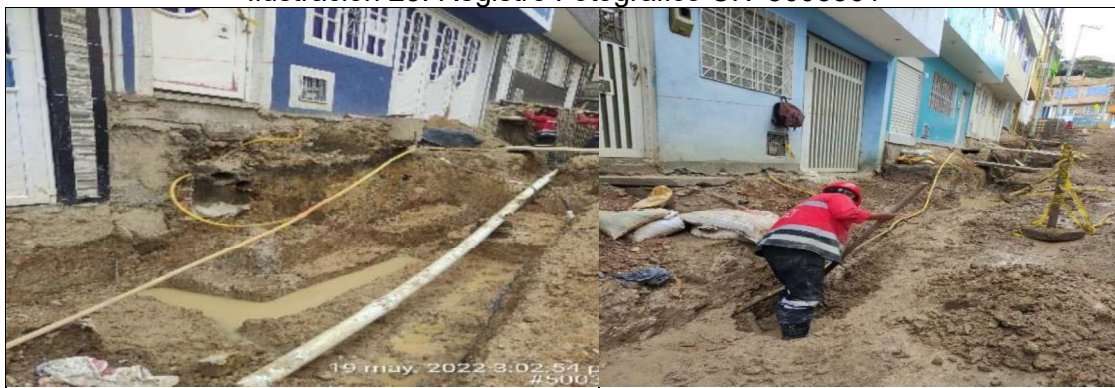
Excavación manual para zarpas
