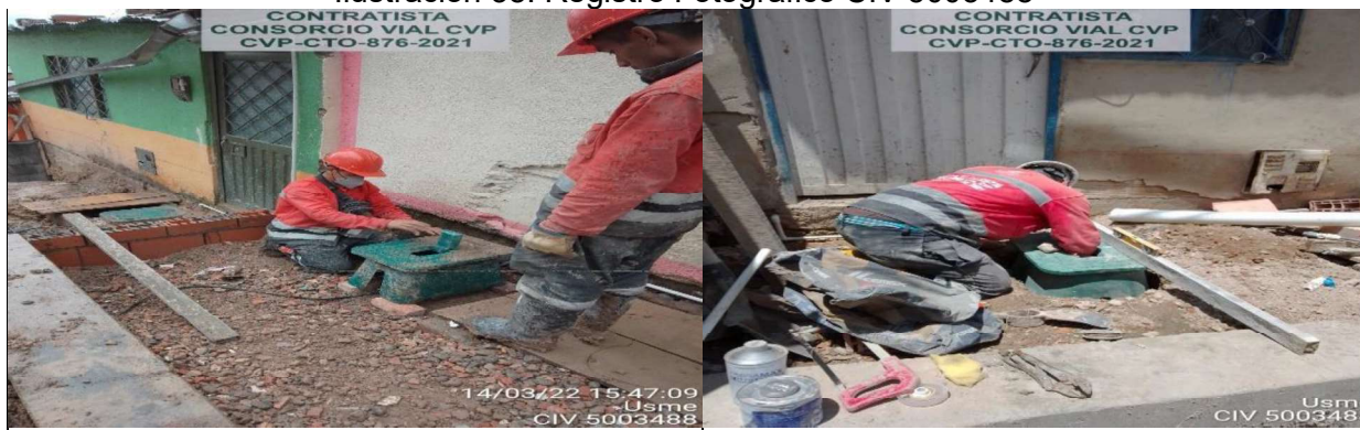
Instalacion de las cajillas de acueducto y de los punto de red de agua potable
