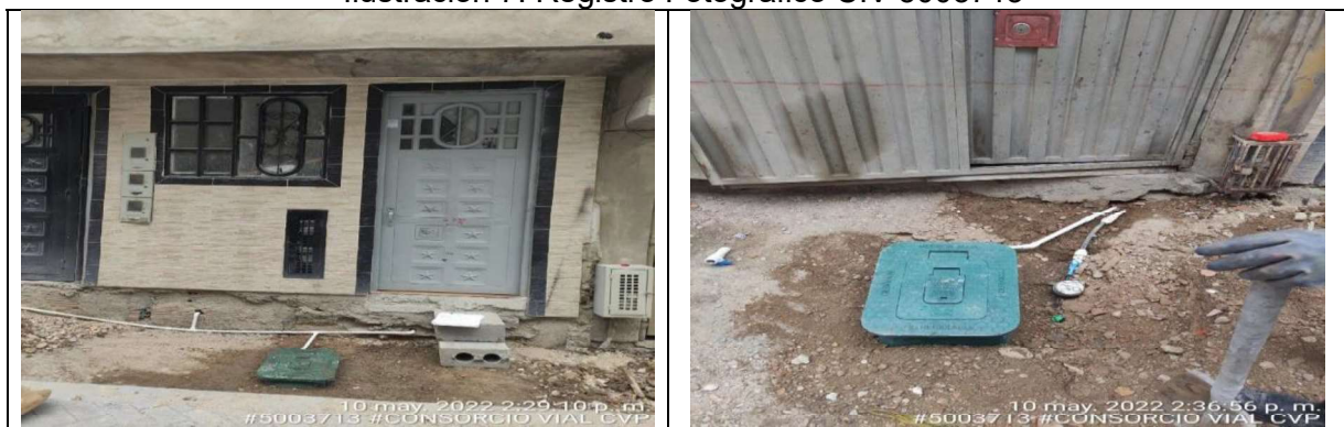
Instalaciones cajillas y puntos hidráulicos de red de agua potable
