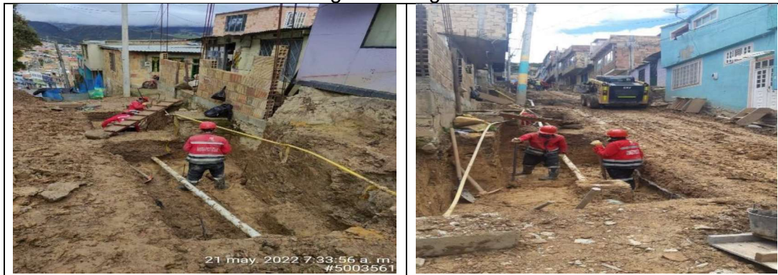
Excavación manual para zarpas
