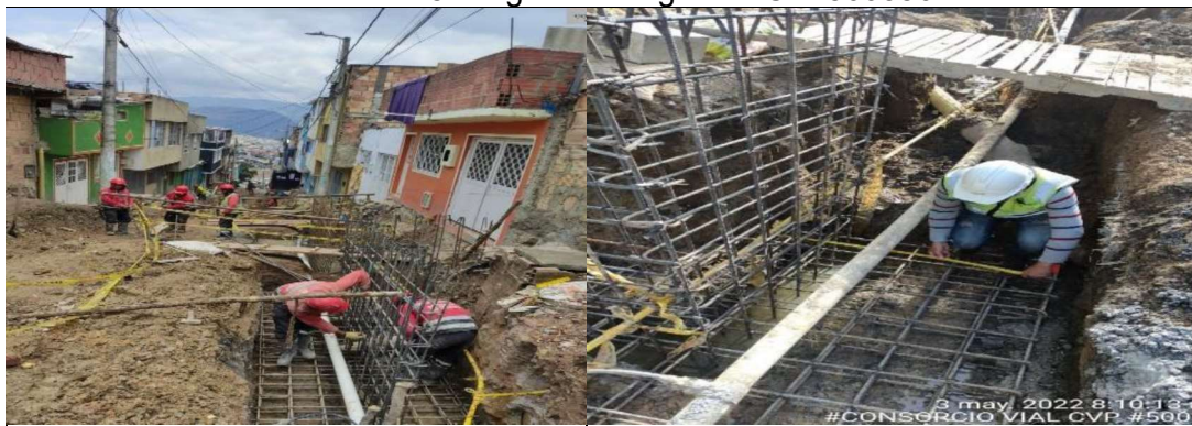
Armado de acero para las zarpas en muros
