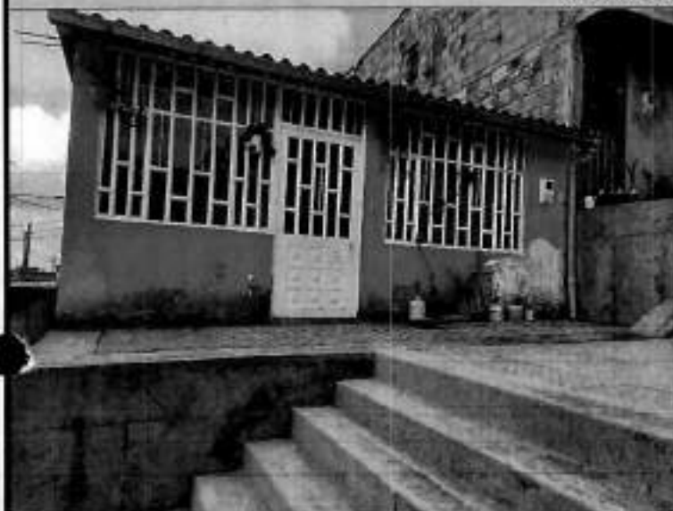
FOTO 1: Antes de instalación de baranda
