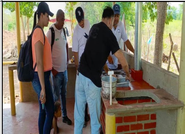
Foto 20. Seguimiento a la construcción de estufas ecoeficiente terminadas en el sector de El Molino.
