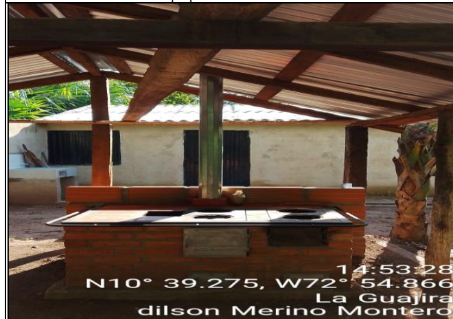
Foto 33. Seguimiento a la construcción de estufas ecoeficientes terminadas en el sector de El Molino de propiedad de Dilson Merino.
