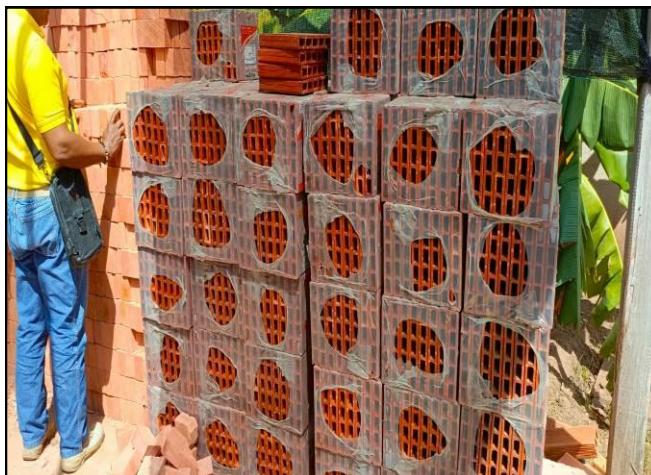
Foto 05. Seguimiento a los materiales de construcción (baldosas tablones) de las estufas ecoeficientes en bodegas del contratista Agua Luna.
