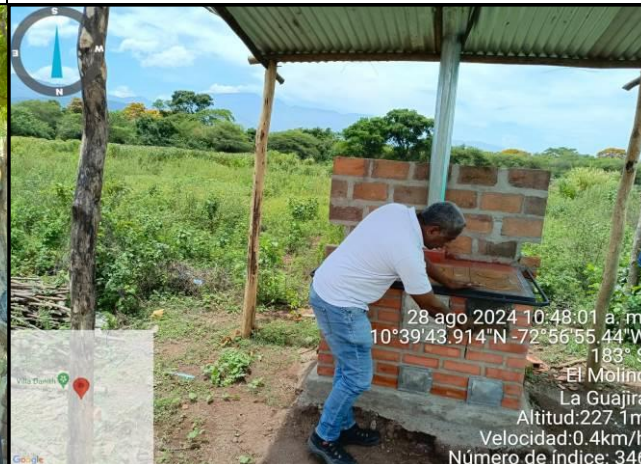
Foto 22. Seguimiento a la construcción de estufas ecoeficiente terminadas en el sector de El Molino.
