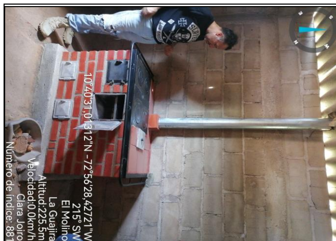
Foto 29. Seguimiento a la construcción de estufas ecoeficientes terminadas en el sector de El Molino de propiedad de Clara Joiro.
