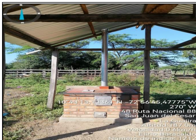
Foto 35. Seguimiento a la construcción de estufas ecoeficientes terminadas en el sector de San Juan Del Cesar de propiedad de Elirio Baracaldo.
