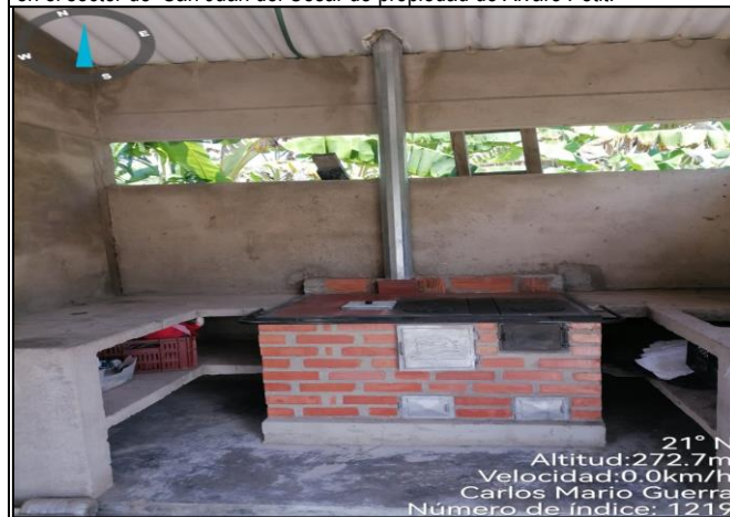
Foto 27. Seguimiento a la construcción de estufas ecoeficientes terminadas en el sector de El Molino de propiedad de Carlos Mario Guerra.
