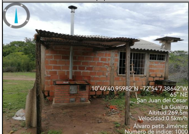
Foto 25. Seguimiento a la construcción de estufas ecoeficientes terminadas en el sector de San Juan del Cesar de propiedad de Álvaro Petit.
