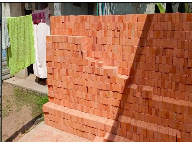
Foto 06. Seguimiento a los materiales de construcción (Ladrillo) de las estufas ecoeficientes en bodegas del contratista Agua Luna.
