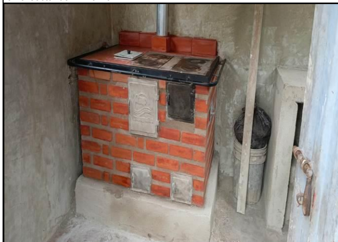
Foto 13 Seguimiento a la construcción de estufas ecoeficientes terminadas en el sector de San Juan del Cesar.
