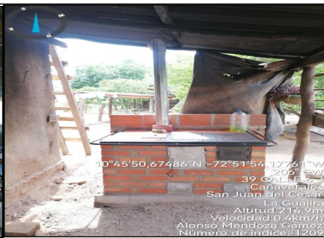
Foto 24. Seguimiento a la construcción de estufas ecoeficientes en el sector de San Juan del Cesar de propiedad de Alonso Mendoza.
