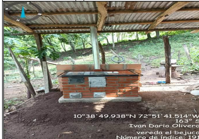
Foto 39. Seguimiento a la construcción de estufas ecoeficientes terminadas en Vereda el Bejuco de propiedad de Iván Darío Olivero.
