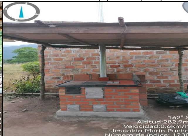
Foto 40. Seguimiento a la construcción de estufas ecoeficiente terminadas en el sector de El Molino de propiedad de Jesualdo Marín Puche.
