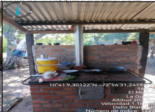
Foto 28. Seguimiento a la construcción de estufas ecoeficiente terminadas en el sector de El Molino de propiedad de Delio Blanchar.
