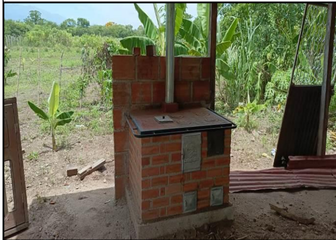
Foto 15. Seguimiento a la construcción de estufas ecoeficientes terminadas en el sector de San Juan del Cesar.
