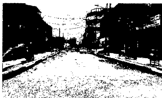
IMAGEN N° 10: Frente de obra.
