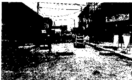
IMAGEN N° 9: Frente de obra.
