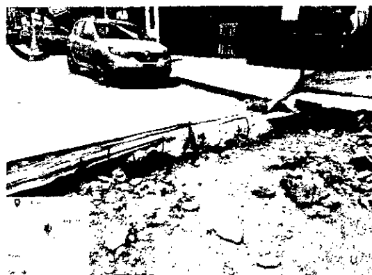
Fotografía 2. Cerramientos perimetrales inexistentes.
