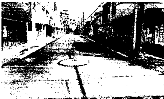
IMAGEN N° 15: Frente de obra en abandono.
