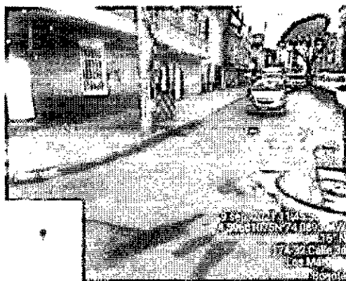
Imagen No.17 y 18 – Sumideros sin protección para material de arrastre.
