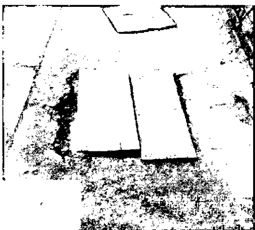
Plafonado cajas de inspección
