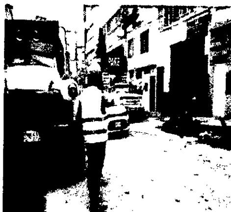
Foto No 4. Aux. tráfico segmento 3-6
