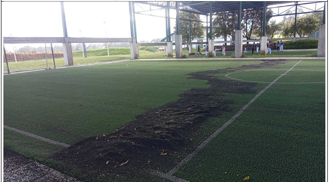
CEPILLADO GRAMA SINTÉTICA Y RELLENO EN CAHUCHO GRANULADO
