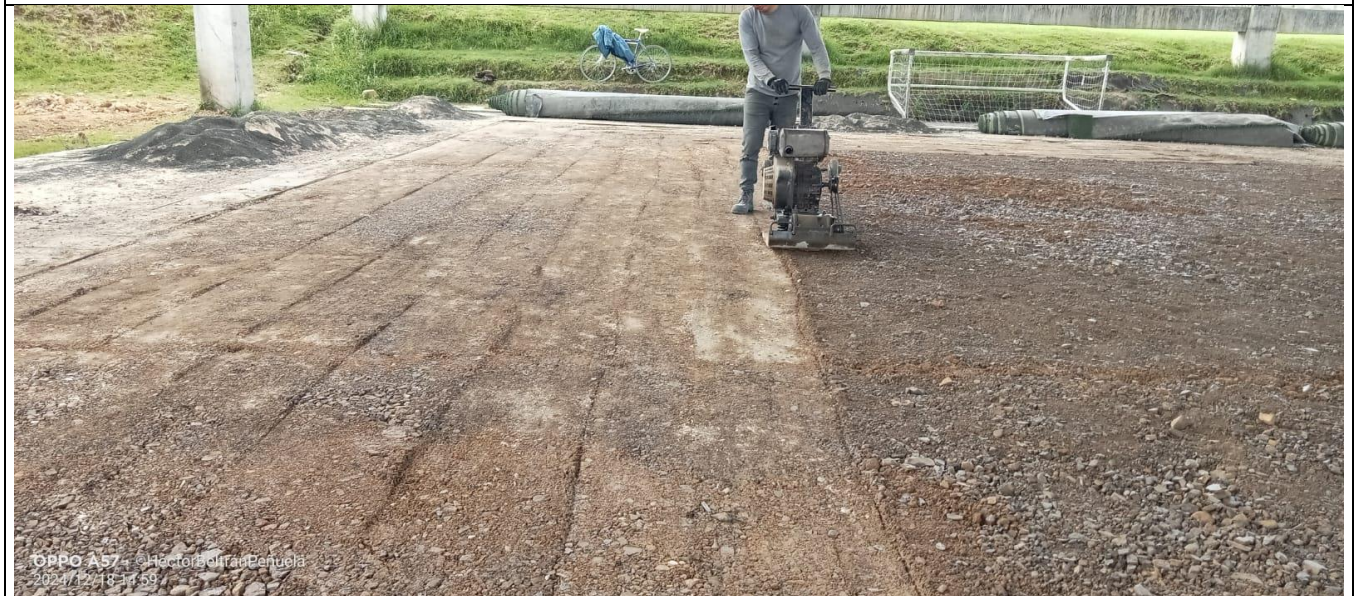
COMPACTACION Y MEJORAMIENTO DE LA SUBRASANTE INVOLUCRANDO ÚNICAMENTE MATERIAL ADICIONADO
