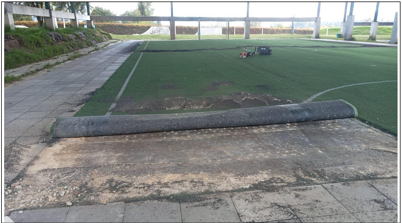
LEVANTAMIENTO DE GRAMA SINTÉTICA
