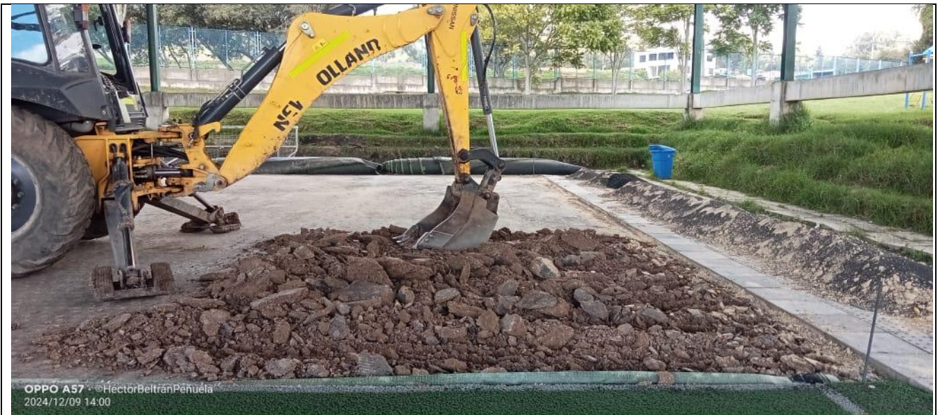
DESCAPOTE PARA MEJORAMIENTO DE LA SUBRASANTE
