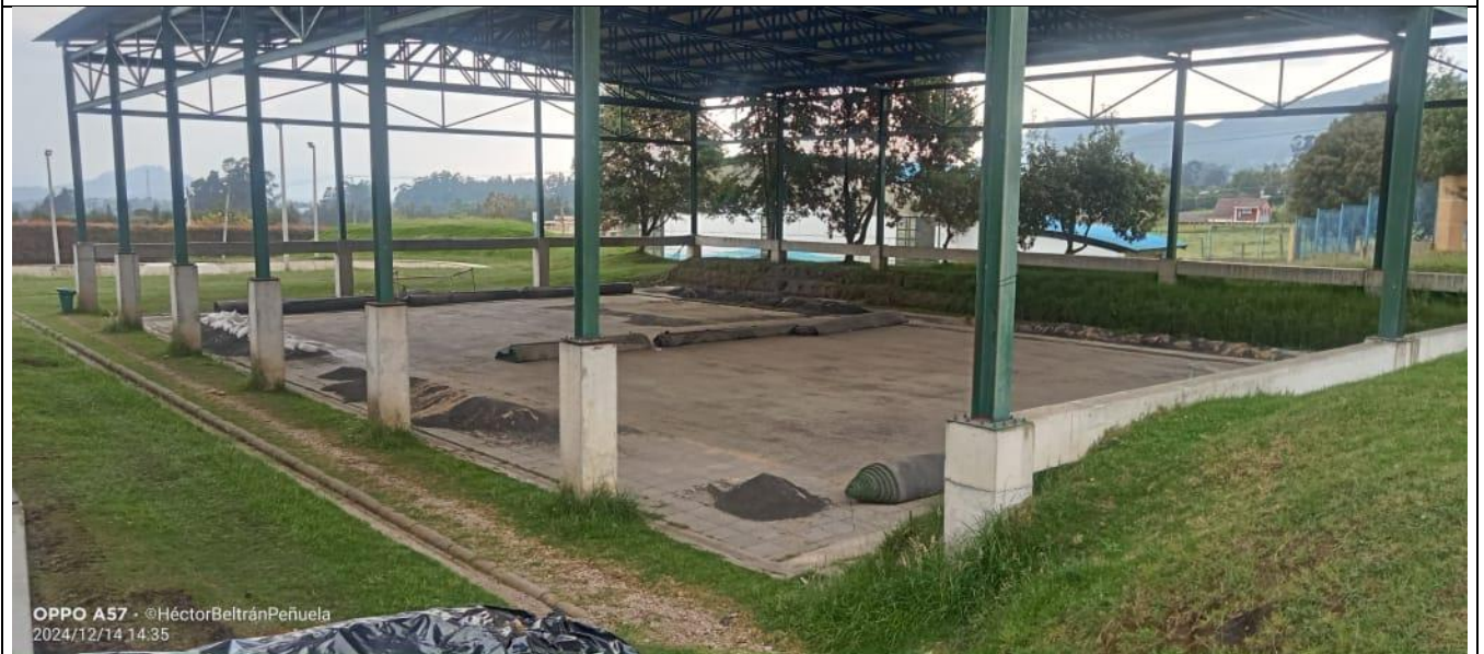
DESMONTE GENERAL GRAMA SINTETICA
