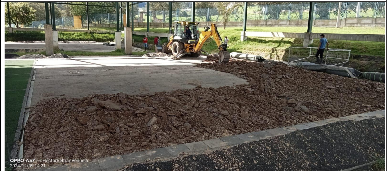
DESCAPOTE PARA MEJORAMIENTO DE LA SUBRASANTE
