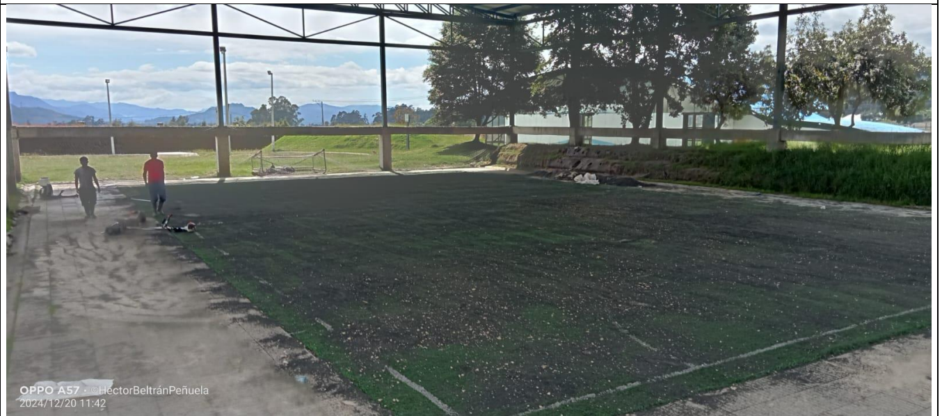
CEPILLADO GRAMA SINTETICA Y RELLENO EN CAHUCHO GRANULADO
