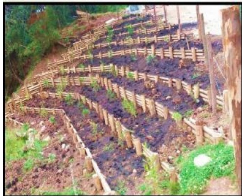
Foto 3. Figura de terrazas con tierra firma y siembra de material vegetal. Fuente: https://repository.ucatolica.edu.co/bitstream/10983/8459/6/Anexo%20A.%20MANUAL%20DE%20OBRAS%20DE%20BIOINGENIERIA%20EN%20ZONAS%20DE%20LADERAS%20CON%20PROCESOS%20DE%20REMOCION%20DE%20MASA%20PA.pdf
