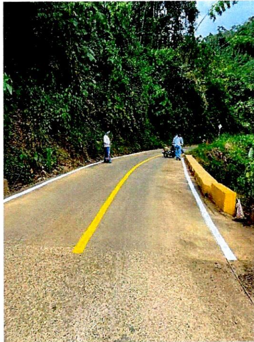
Imagen 10 Demarcación en obra. G5 punto crítico 1
