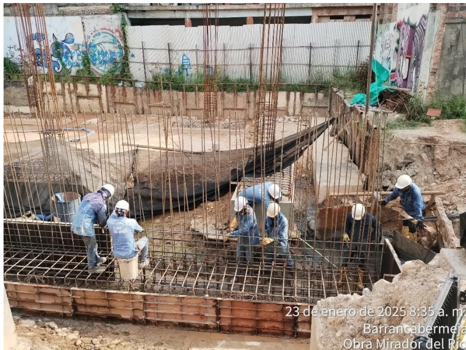
Armado y encofrado de viga
