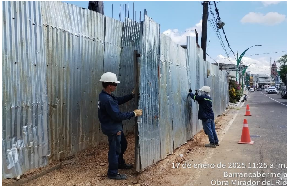
Ampliación de encerramiento en lámina
