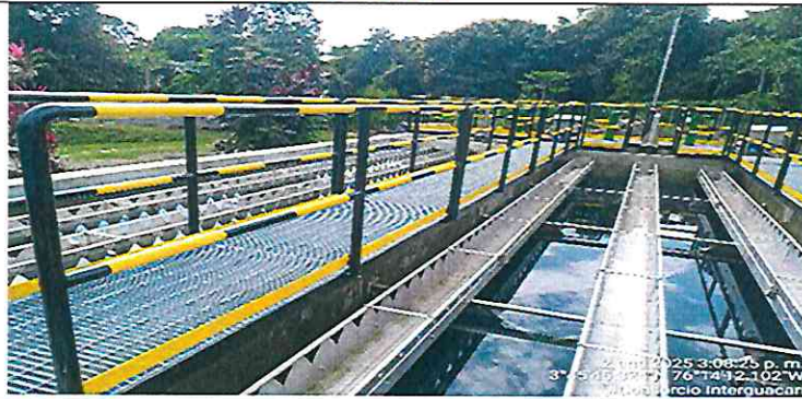
Sedimentador 2 : En pruebas con personal de Acuavalle
