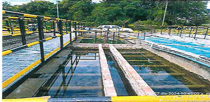
Sedimentador 1: Sin intervenir - Lo más probable es que inicie trabajos la tercera semana de Enero de 2025.
