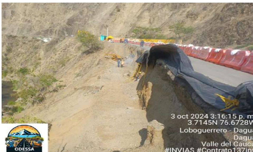
Imagen 10 Fotografía del sitio del PR55+050, anclajes
