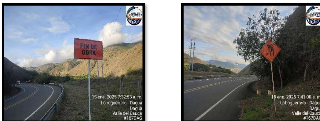
Imagen 6. Señalización instalada en el PR55+050
