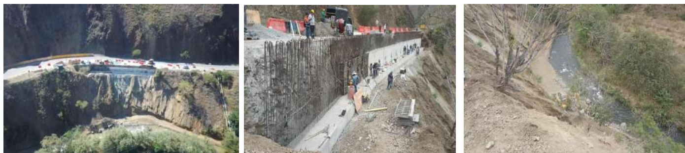
Imagen 11 Fotografía del sitio del PR55+050 micropilotes
