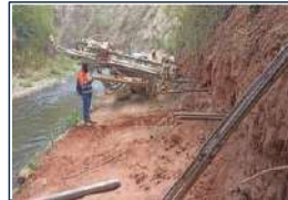
Fotografía No 03 AMARRE DE ACERO MURO PR55+050
