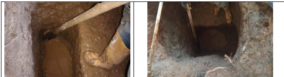
Figura 2 Apique en Escalera 2
