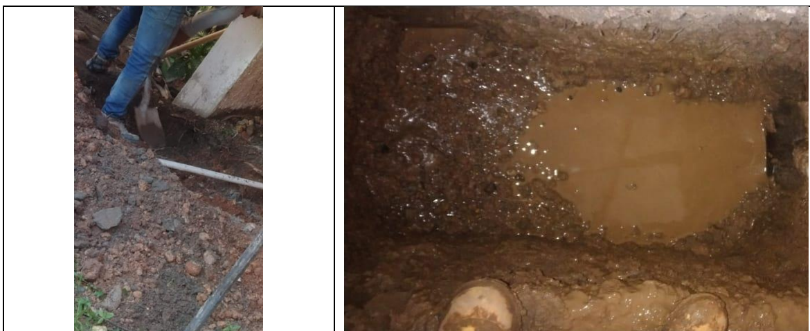
Figura 3 Apique en escalera 3
