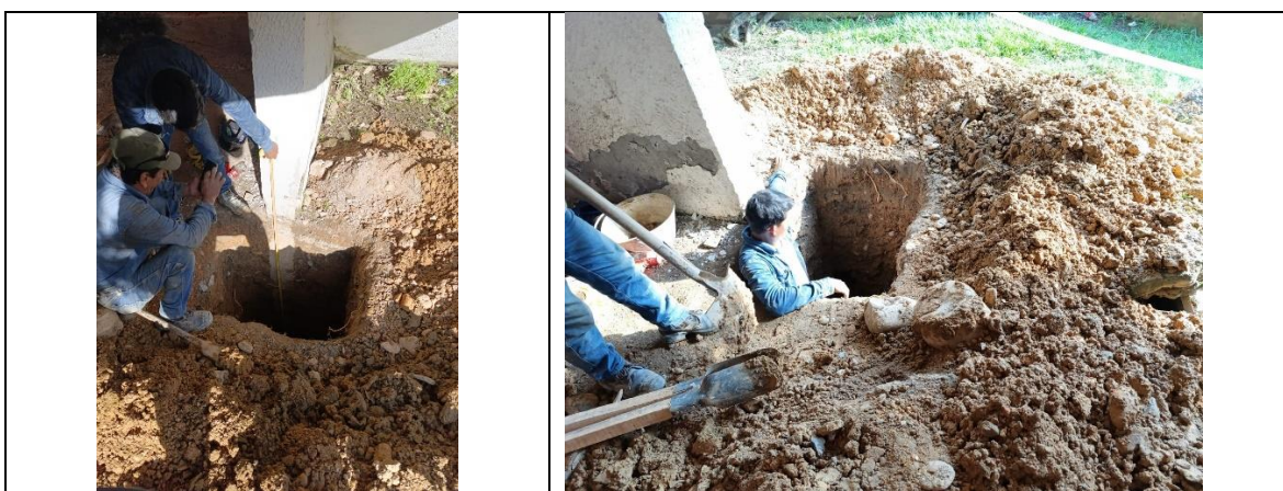
Figura 1 Apique en Escalera 1
