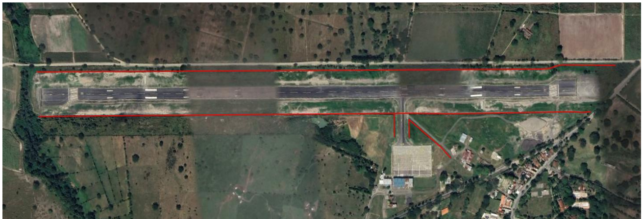
Imagen 4. Canales manejo de aguas lado aire pista 01 – 19
