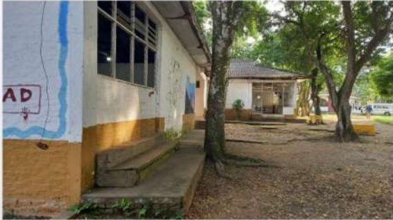
EXTERIORES EN SU CONDICION INICIAL
