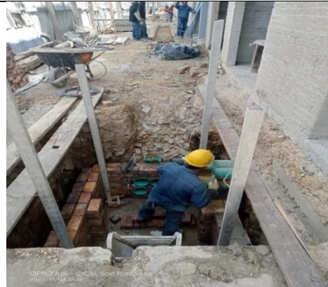
Sector 1 y 5, fachada occidental, armado de caja de inspección de acometida eléctrica
