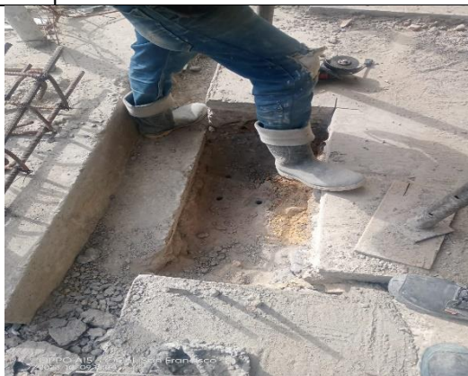
Excavación para cimentación de columna para soporte de asentamiento, circulación sectores 2 y 3
