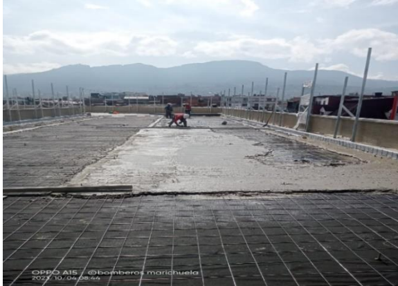
Cargue de sobre piso con mortero impermeabilizado, Sector 5 Cubierta
