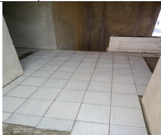
Instalación de enchape en granito pulido en punto fijo de sector 1 piso 2, acceso comunidad
