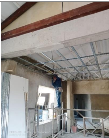
Instalación de estructura para cielorraso en acceso de polivalente, sector 2 piso 2
