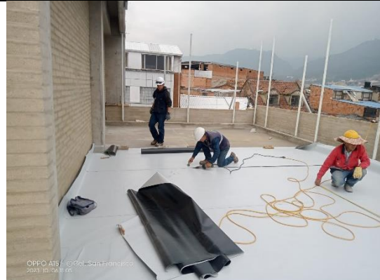
Instalación de membrana pvc sarnafil en sector 4 y 3, cubierta
