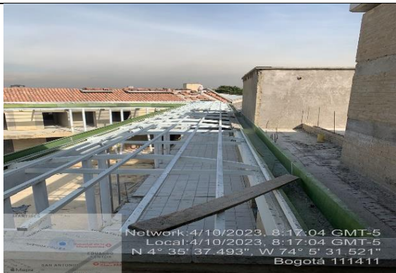
Instalación de teja de barro en último tercio de cubierta, Sector 1
