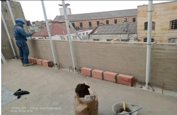
Sector 3 plataforma cubierta, instalación de bordillos en concreto y bloque No. 4
