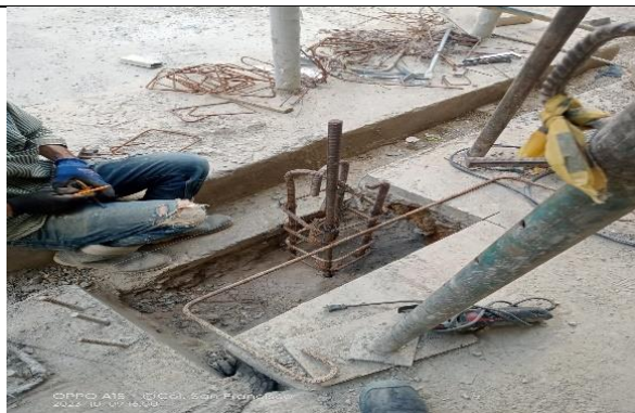
Armado de refuerzo para soporte de columnas de soporte de asentamiento, circulaciones Sectores 2 y 3
