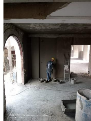
Afinado de muros en pañete quemado en acceso de comunidad, Sector 1 Piso 1
