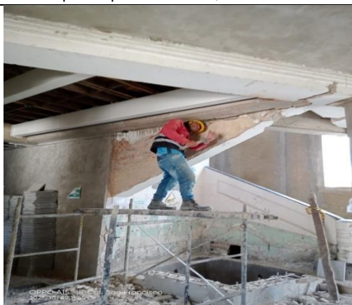
Demolicion de pañete viejo en acceso de comunidad, Sector 1 piso 1
