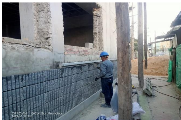
Instalación de prefabricado sobre enchape ranurado, Sector 2 fachada Norte
