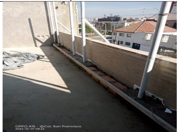
Vaciado en concreto para bordillos en postes de cerramiento, Sector 3, cubierta. Plataforma
