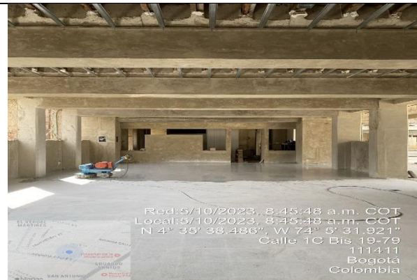
Continuación de destronque de piso en aula multiple-comedor- sector 2 piso 1
