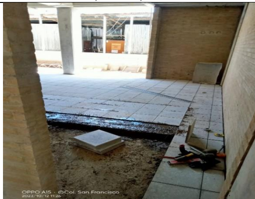
Instalación de enchape en granito pulido en aulas de sector 4 piso 1
