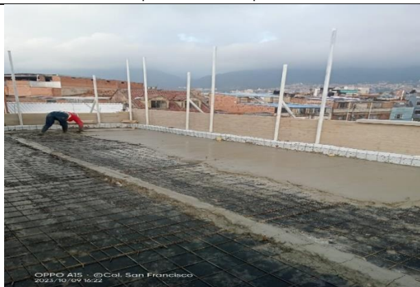
Cargue de Sobre piso en sector 4 Cubierta
