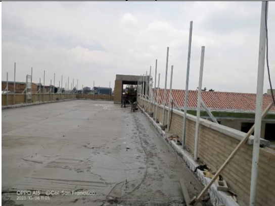
Sector 5 cubierta, Cargue completo de sobre piso en mortero impermeabilizado
