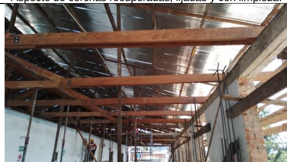
Instalación de cerchas completas in situ.
