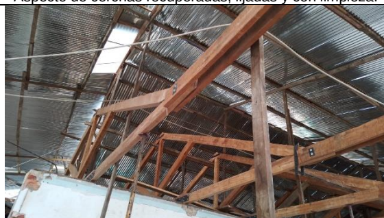
Aspecto de empalme de tirante.
