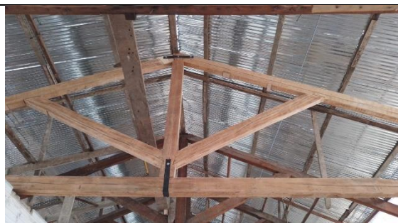
Aspecto de cerchas recuperadas, lijadas y con limpieza.
